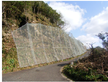
三原林道落石柵
