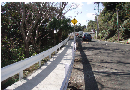
檜立 仮の歩道
