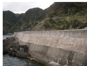
洞輪沢護岸整備
