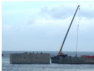
ケーソン設置状況
