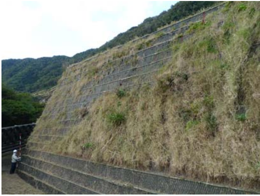
青ヶ島池之沢地区の落石防護擁壁
