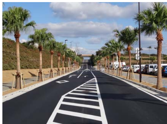
全線完成した都市計画道路
