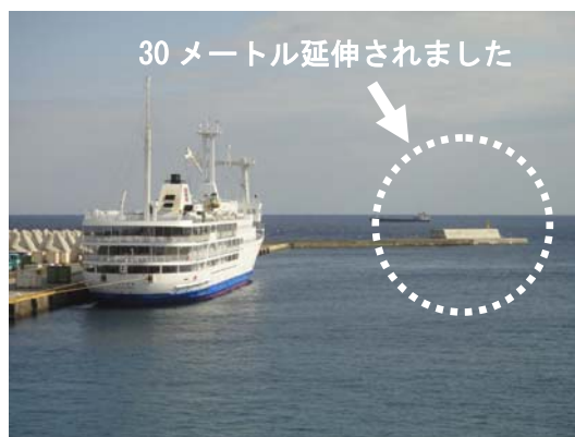
神湊港の防波堤整備
