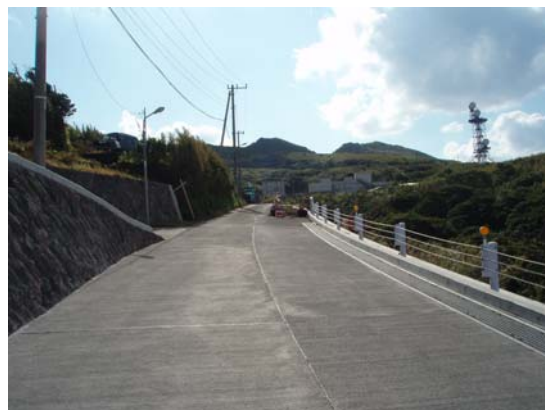
青ヶ島中原地区の道路整備
