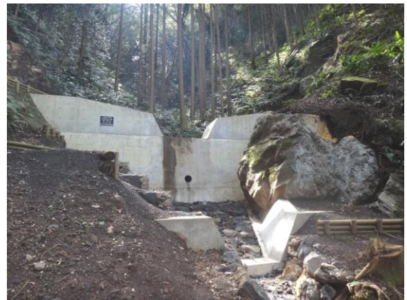
大賀郷地区の治山工事
