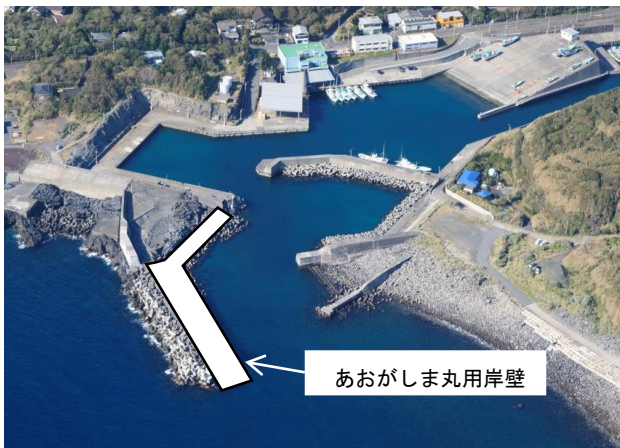
八重根漁港の岸壁整備工事
