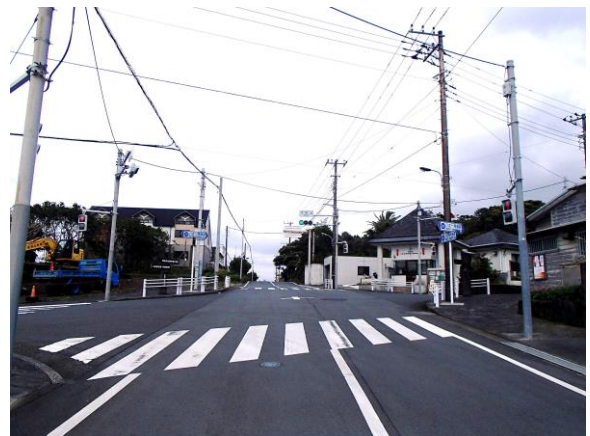
大中上交差点の道路拡幅工事
