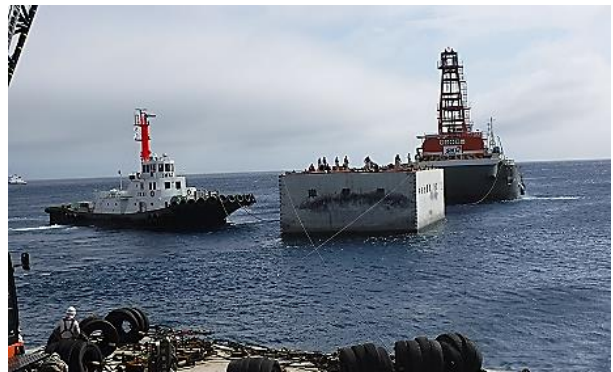
ケーソン据付の様子（神湊(底土)港）
