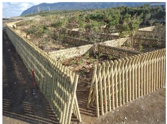
◇三根地区の垂戸保安林改良緊急工事
