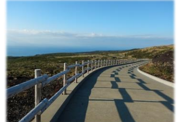
③多摩産材のガードレールと海の眺望
