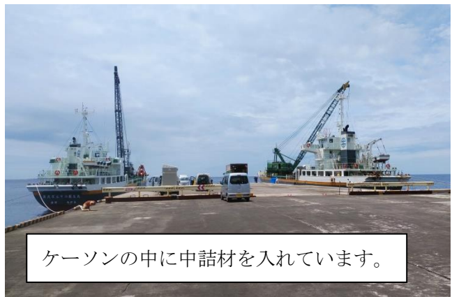
ケーソン中詰状況
