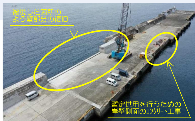
施工状況写真(令和元年7月18日撮影)
