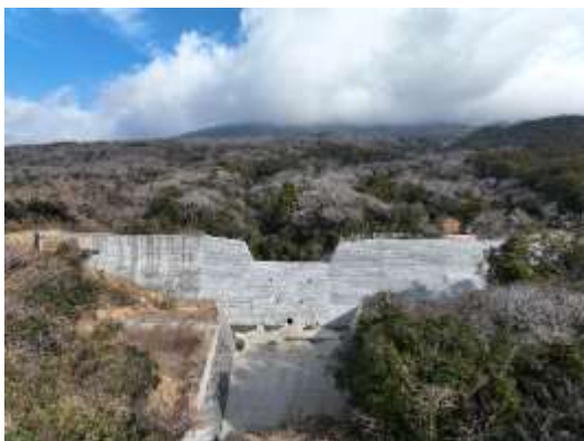
滝川沢砂防堰堤(概成)
