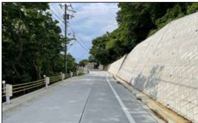
狭隘道路の現道拡幅や線形改良等を推進
