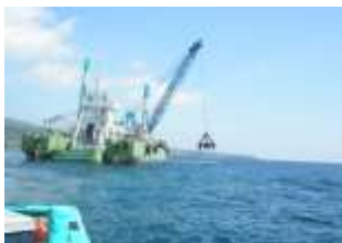
【自然石の投入】
