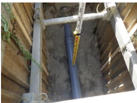
下水道管の整備状況
