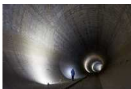
神田川・環状七号線 地下調節池
