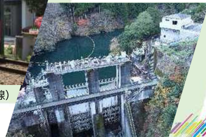
白丸調整池ダム
