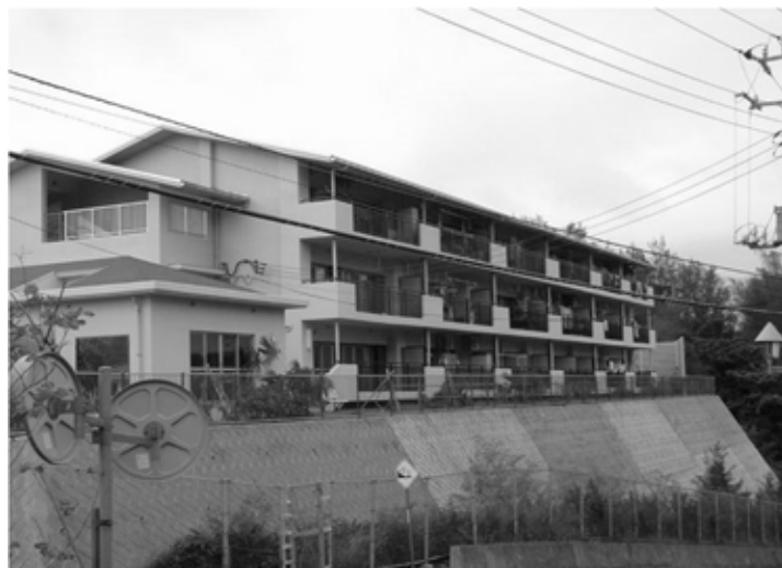
都営二見台アパート3号棟（父島）（平成11年度完成）
