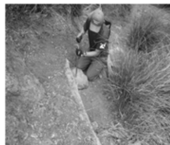
都レンジャーによる歩道補修
