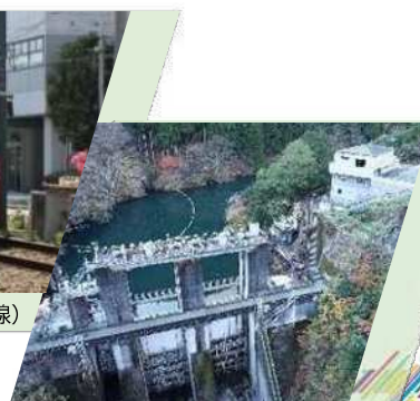
白丸調整池ダム
