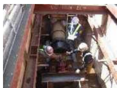
<水道管路の工事>
