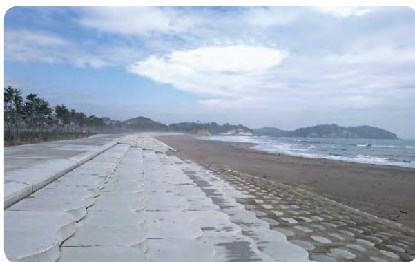
↑ 写真左下の白い部分が新しい堤防 菖蒲田浜海岸（七ヶ浜町）
