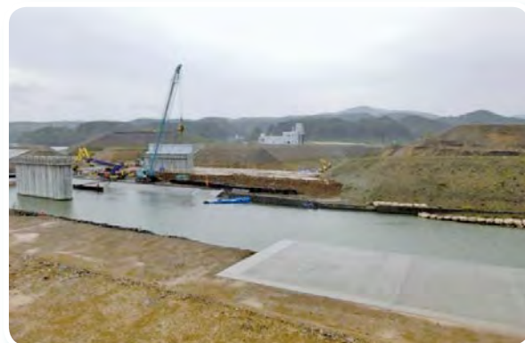
かさ上げ工事が進む南三陸町
