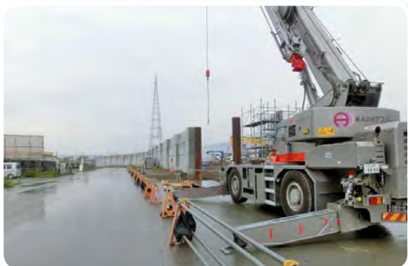
整備進む商港岸壁の防波堤(気仙沼市)
