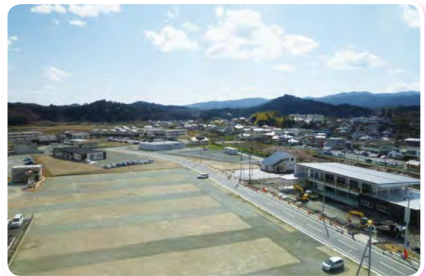
広野駅東側開発状況（馬場医院周辺） 平成29年4月13日撮影
