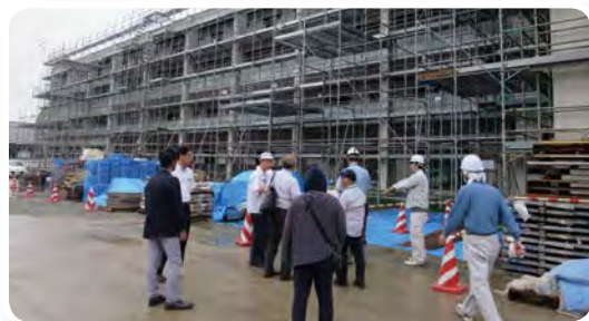
富岡町内視察【災害公営住宅建設現場】
