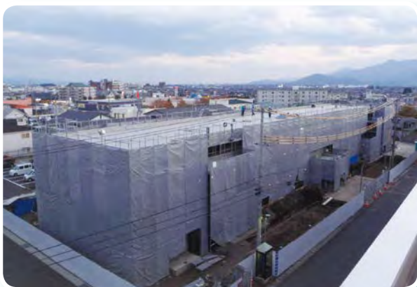
工事が進む「県営備後第1アパート」(盛岡市)
