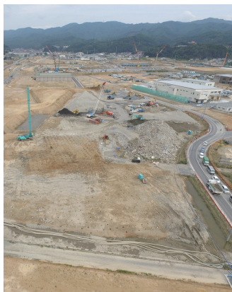
かさ上げ工事が進む鹿折地区（2015年9月）
