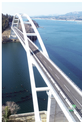
完成した気仙沼大島大橋
