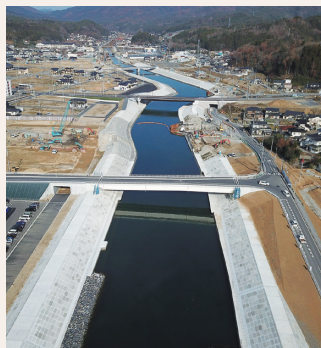
架け替えられた浪板橋と 工事中の鹿折川防潮堤
