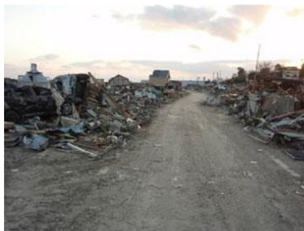
全壊地域(石巻市日和が丘2丁目付近)
