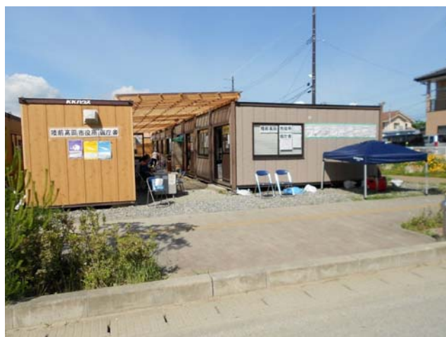
〈仮庁舎 右側に発電機が設置されている〉
