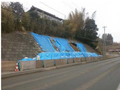
写真 3：津波により崩れた法面
