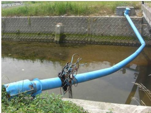
津波により損傷した水管橋（山田町）の復旧作業
