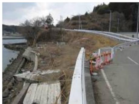
写真－3 津波で壊された道路
