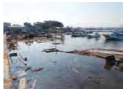
写真-6 施設全体の沈下・冠水
