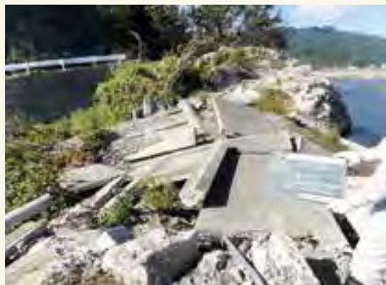
写真1：堤防の破損状況（小鍬川）
