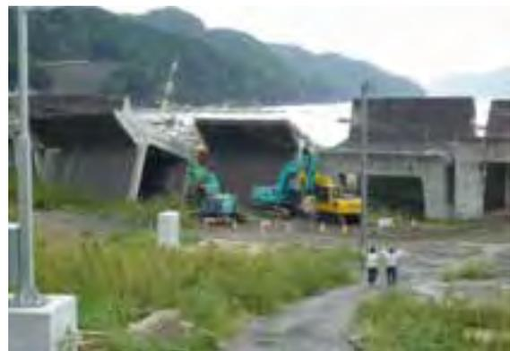
津波により倒壊した防潮堤
