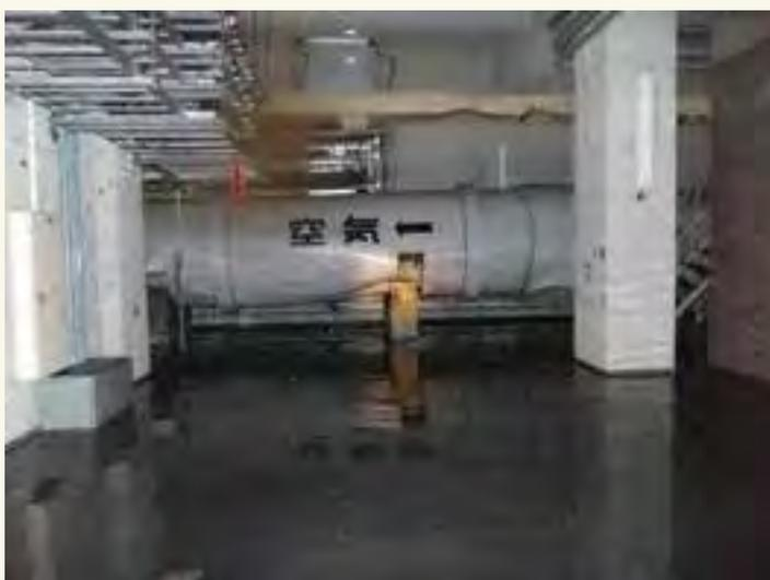
送風機棟地下1階浸水状況
