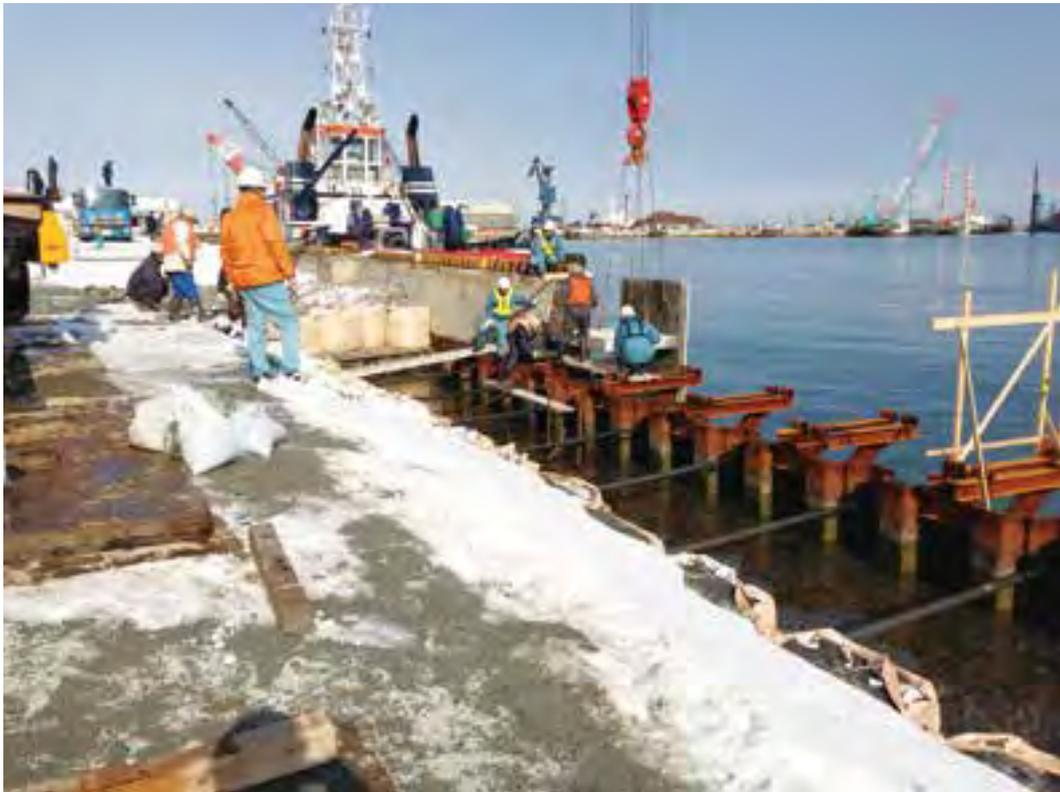
写真3：岸壁復旧工事（海上に仕切りを設置中、その後背後を埋め立てる）
