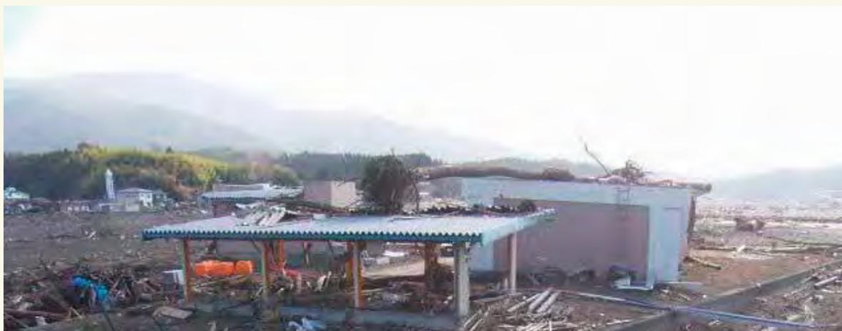
海岸から4km離れた水源地及び電気室。高田松原の松が津波により電気室の屋根に打ち上げられていた。
