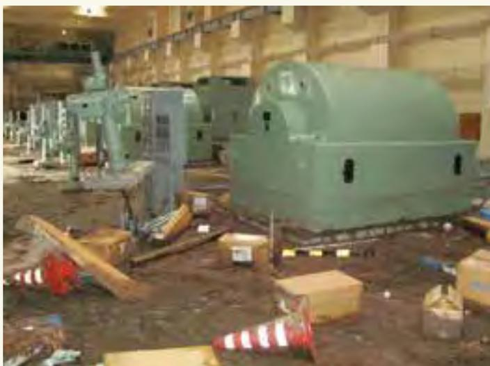
送風機棟 1階送風機設備被災状況
