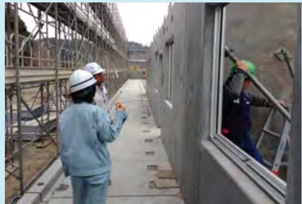
薄磯団地建築工事③
