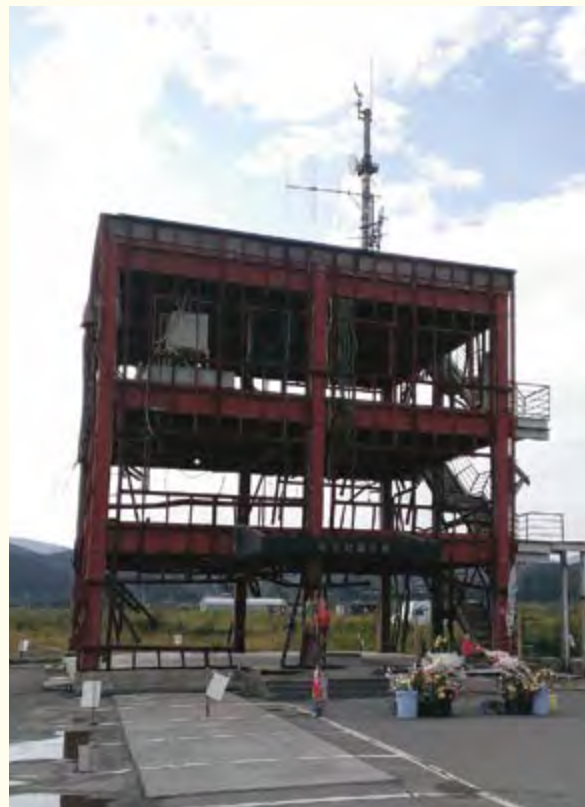
写真3 平成25年9月撮影 南三陸町 被災した町の防災対策庁舎。
