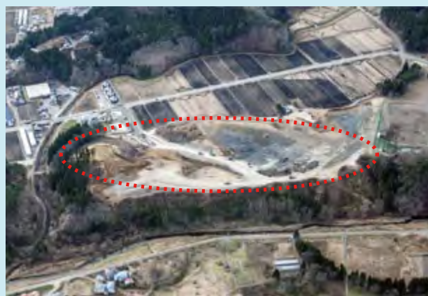
城内高台団地予定地（造成中）
