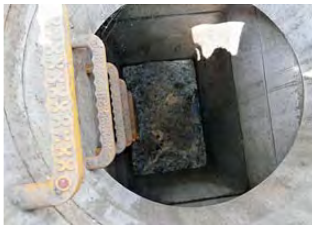
人孔 B 汚水の滞水状況 平成 25 年 8 月 12 日撮影
