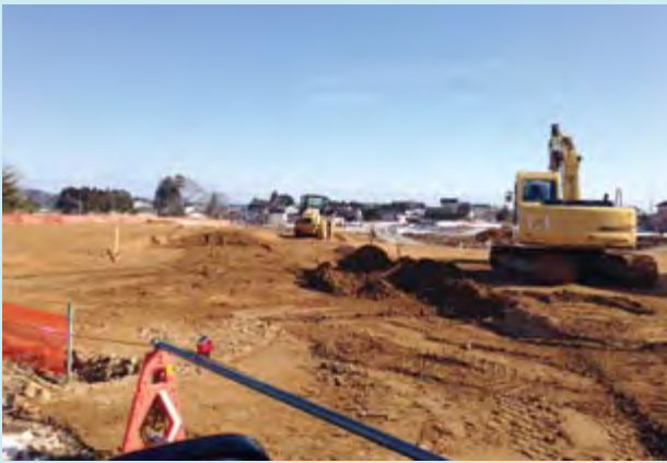
階上地区災害公営住宅建設予定地
