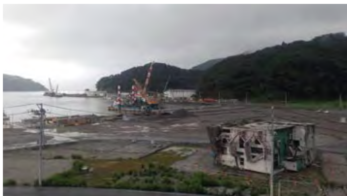
平成 25 年 7 月撮影 女川町 写真奥が女川漁港。手前は津波で横倒しになった建物。
