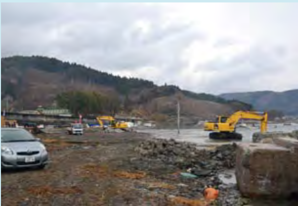
物揚場工事 着手前
