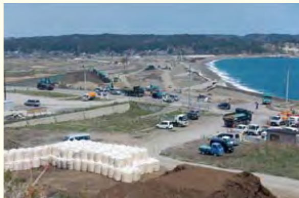
田老地区の防潮堤整備工事
