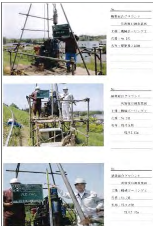
総合グラウンド地質調査（検尺）
