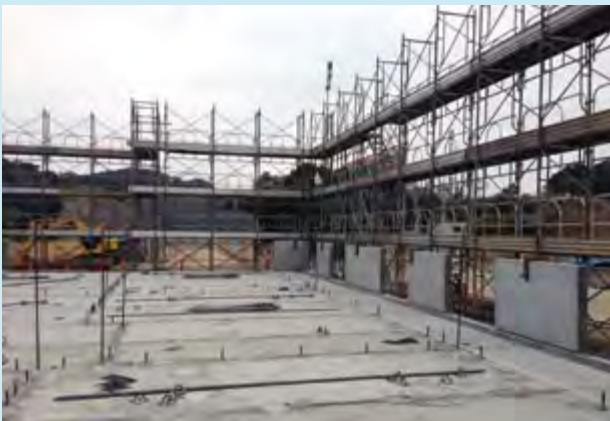
薄磯団地建築工事②
