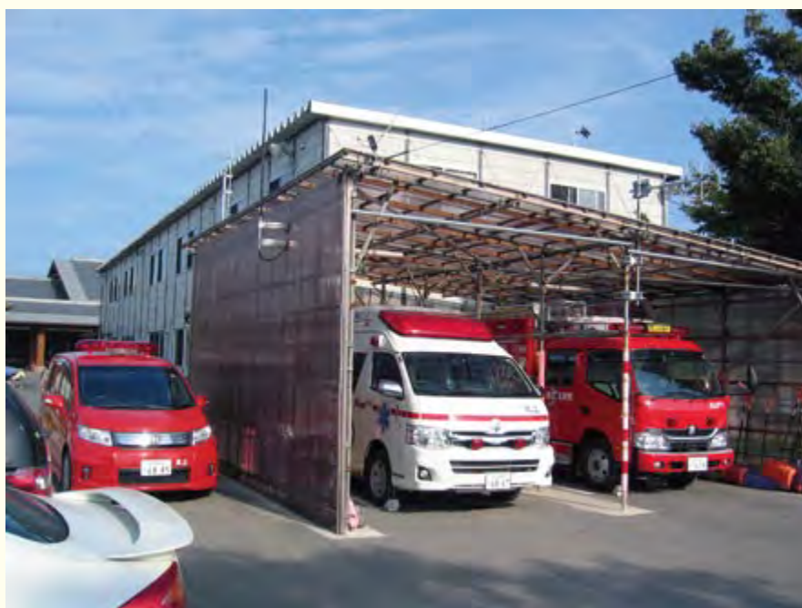
河北消防署北上出張所仮設庁舎（平成 25 年 10 月）
