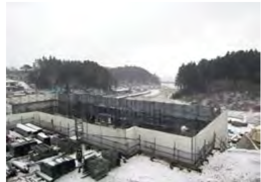
入谷地区（平成 26 年 1 月 10 日） 集合住宅建築工事中
