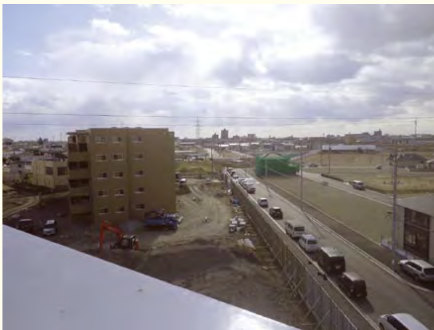
建設中の田子西復興公営住宅
