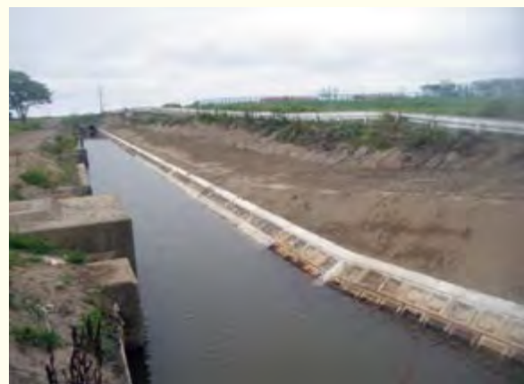
工事完了後 25年7月（鈴木堀）
