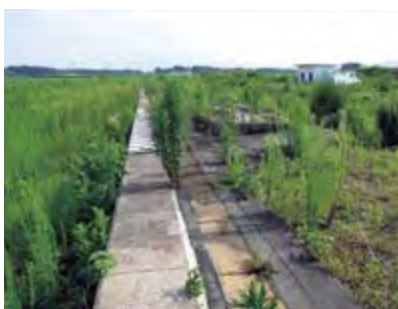
写真 1 被災した新地駅
