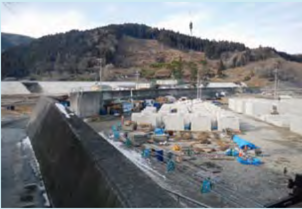
泊漁港外郭施設復旧工事
