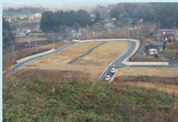
南浜高台団地造成地
