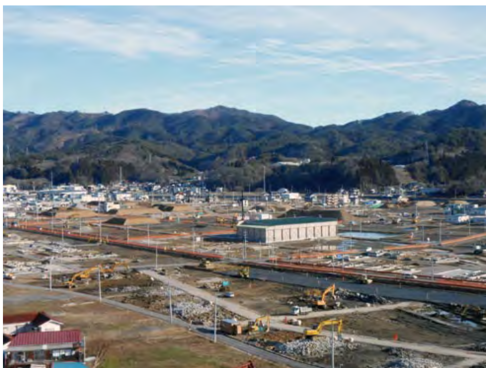
平成 25 年 12 月時点鹿折地区状況写真
