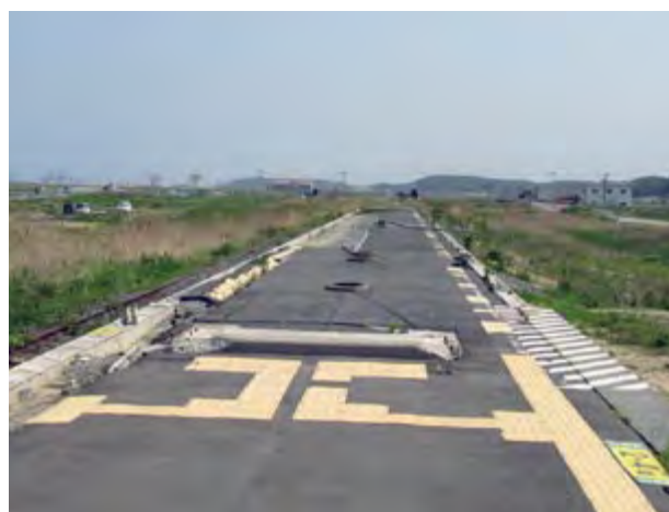
常磐線坂元駅のホーム H25.5.27 撮影（左手が海側）
