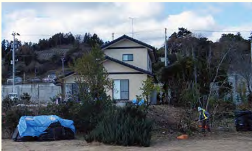
久ノ浜周辺（除染作業） H25.12.24
