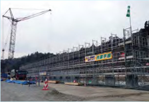
薄磯団地建築工事①
