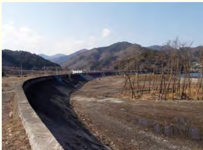
写真1 取壊し前の防潮堤（小白浜海岸）（H25.4 撮影）
