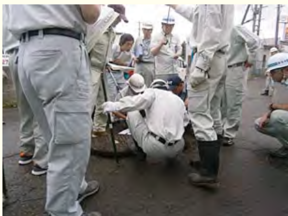
実地査定状況（雨の中の実地査定でした。） 平成 25 年 7 月 24 日撮影
