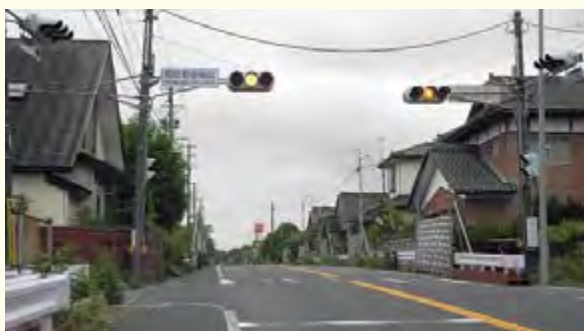
バリケードの設置状況（国道6号線）
