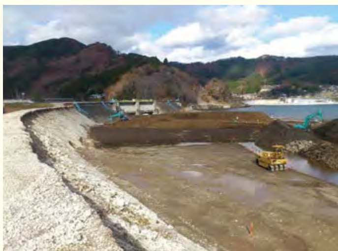
写真2 取壊し後盛土を開始（小白浜海岸）（H25.11 撮影）
