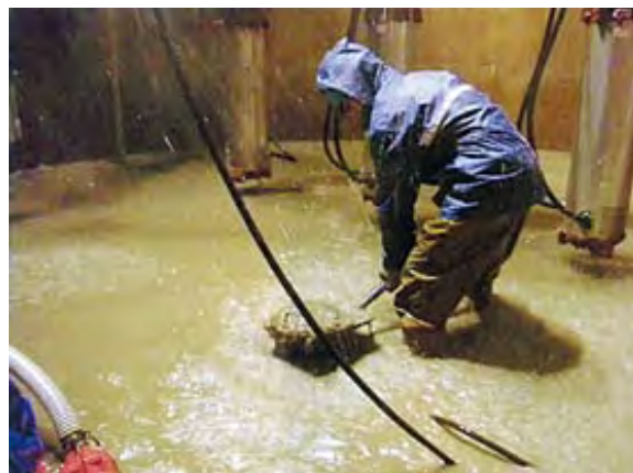
津波により浸水した水源（井戸）の復旧作業（陸前高田市）
