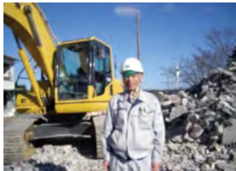
楡葉中学校解体工事現場で
