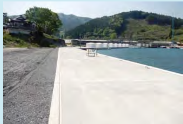
物揚場工事 完了後
