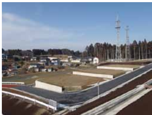
防災集団移転促進事業 館浜団地造成工事
