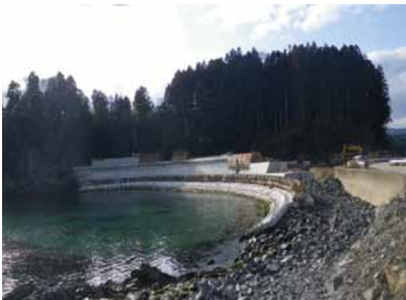
館浜海岸災害復旧事業施工状況 1
