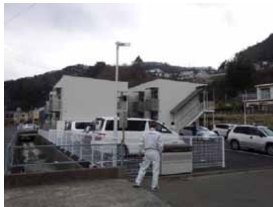
復興推進計画で認定された応急仮設建築物の職員寮、釜石市にて、H27.1頃
