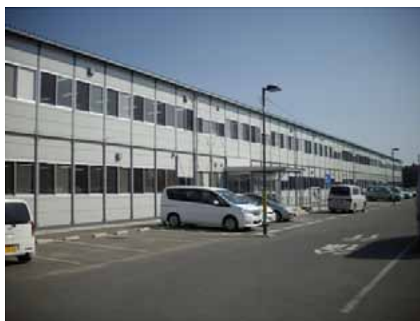
合同庁舎の様子(仮設)
