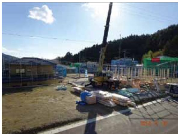
防災集団移転促進事業により整備された区画に住宅建設が進む崎浜地区【岩手県大船渡市】（平成26年11月）
