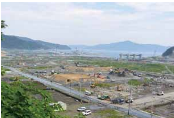
復興に向け嵩上げ工事が進んでいる大槌町役場周辺
