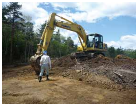
重機による表土剥ぎ 薄く表土をすきとっていく
