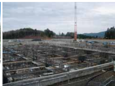
町立病院・総合ケアセンター工事現場(平成26年12月)
