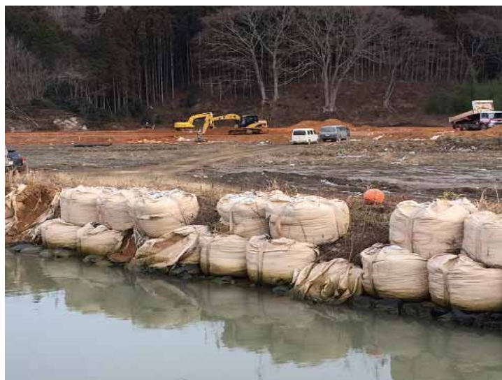
浸水地を埋め立て、防潮堤建設準備が進む(平成27年1月撮影)
