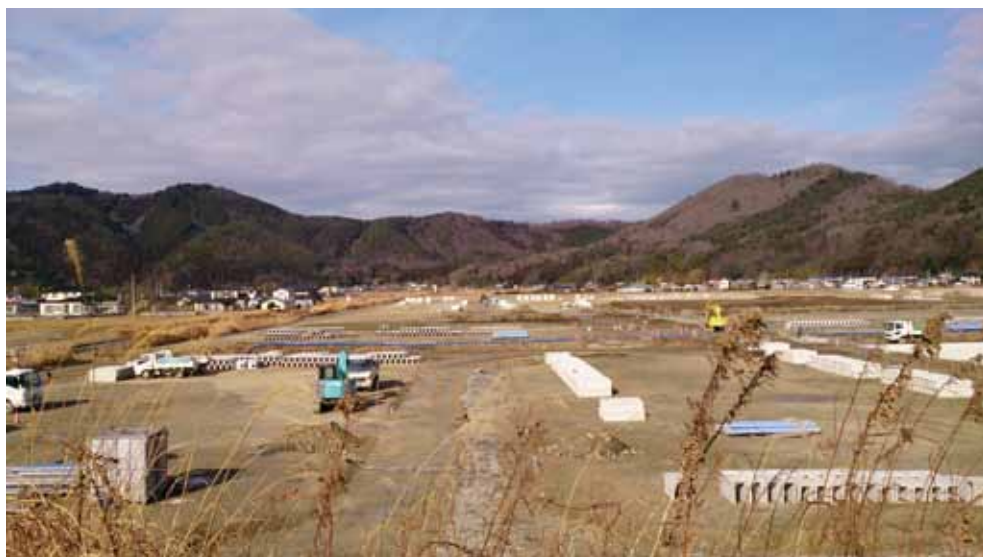
内陸部の田畑を宅地造成している(新渡波地区H27.1.16)
