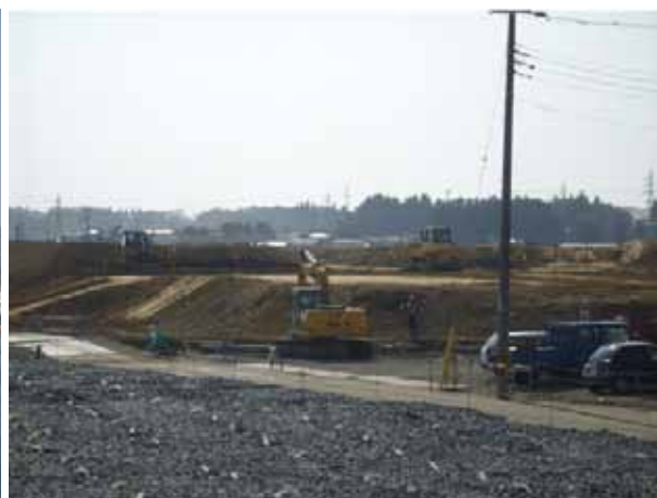
地盤改良・盛土工事状況
