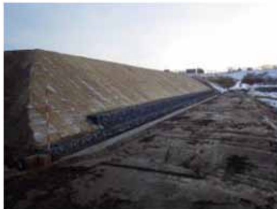
法面および排水路修復 工事完了後
