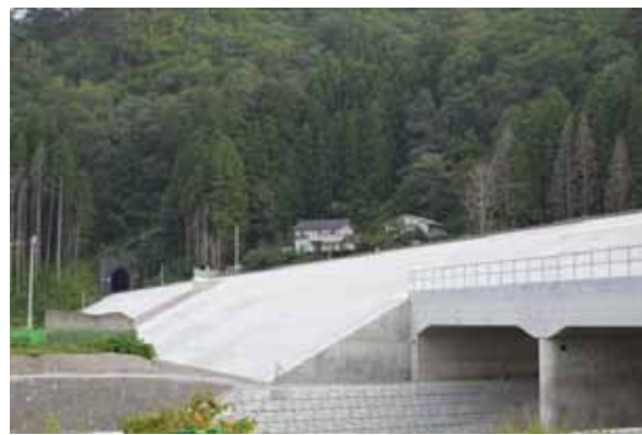
平成26年9月に立ち寄った三陸鉄道・島越駅付近。津波により流失した高架橋及び線路が見事復活。復興は着実に進んでいるのだと実感。
