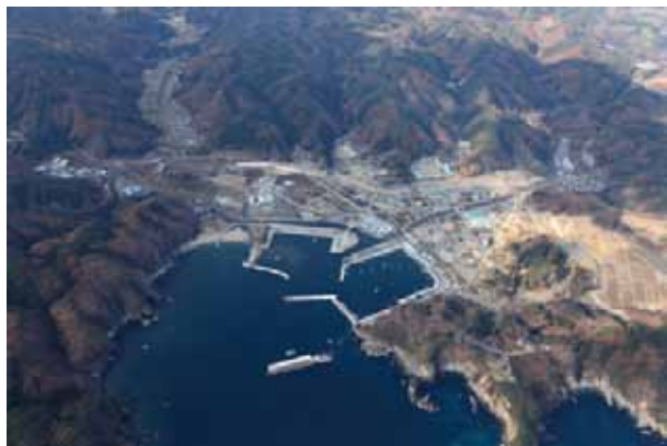
宮古市田老地区 平成26年11月
