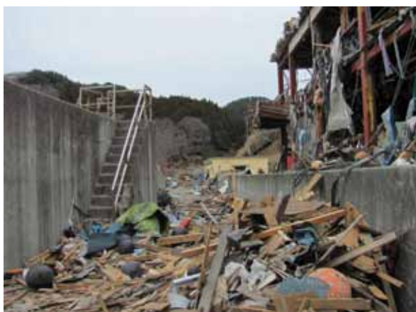
白浜（鵜）漁港被災状況（平成23年4月撮影） 津波は左側の防潮堤（高さ約5m）の天端を越えて集落を襲いました。ここ白浜集落でも、防潮堤の門扉を閉鎖しようとした複数の消防団員の方が殉職されたとのことです。あらためて御霊のご冥福をお祈りするとともに、復興の前進をお誓い申し上げます。
