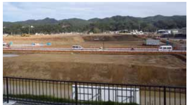
気仙沼市鹿折地区(平成26年10月撮影)
