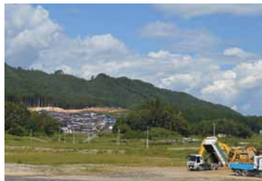
高台土地造成工事中の山田町
