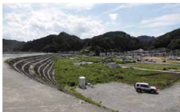
宮古市田老地区防潮堤(平成26年7月撮影)
