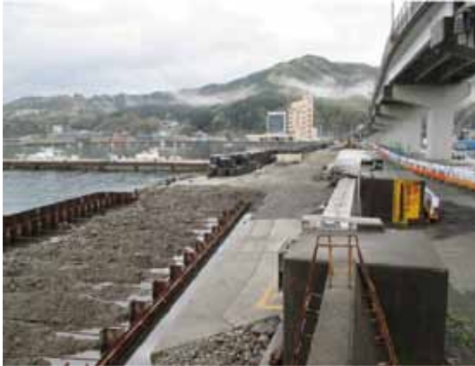
(H26.4赴任当初)仮設土のうによる応急復旧、既設防潮堤・陸間の一部が残存
