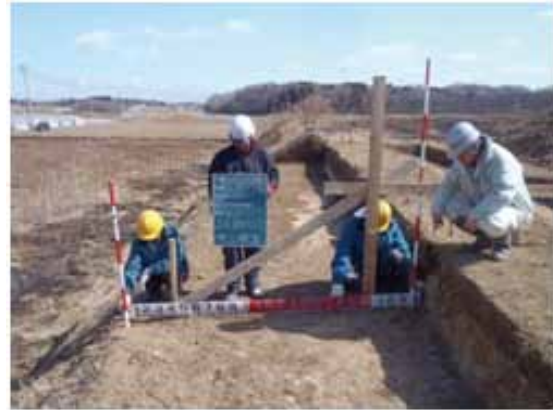
施工検査立会の様子②
