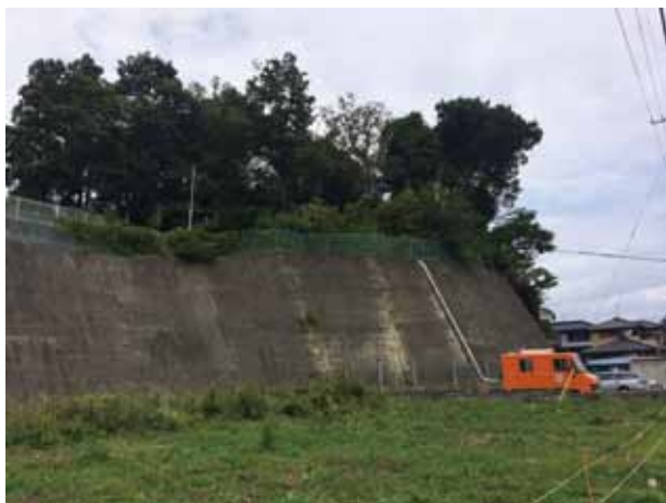
現場写真①
