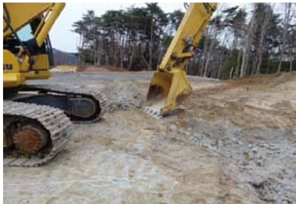
女川消防署牡鹿出張所工事着手(平成27年1月着手)
