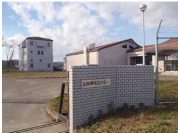
維持管理業務などを委託する 「特定環境保全公共下水道事業・山元浄化センター」
