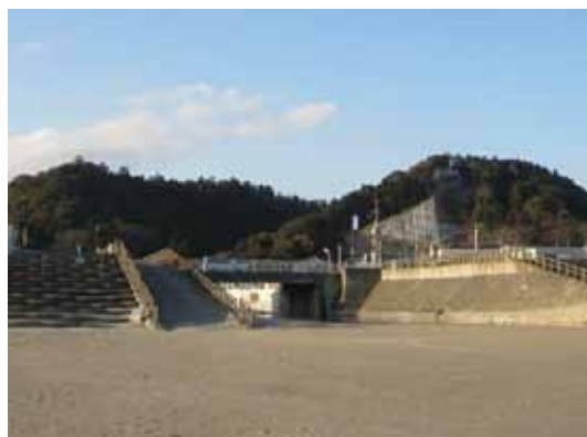
樋門を設置する大平川河口(H26.12撮影) 27年2月中頃から地盤改良工事実施
