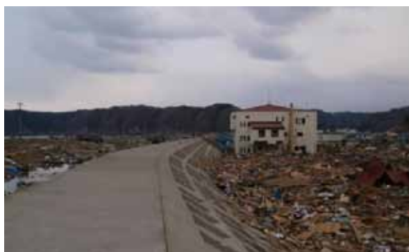
宮古市田老地区防潮堤(平成23年3月撮影)
