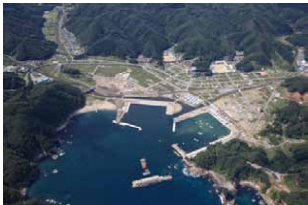
宮古市田老地区 平成25年9月
