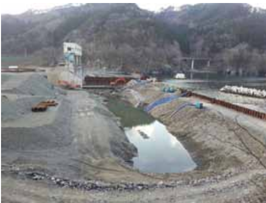
(H26.4赴任当初)右岸部防潮堤基礎工事のため、水替工を実施中
