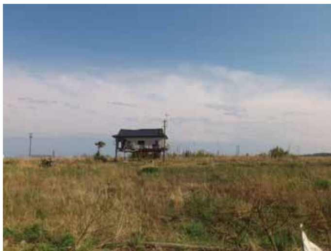
津波被災地域の様子
