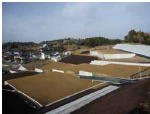
防災集団移転促進事業 石浜・名足団地造成工事
