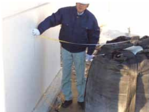
現場計測の様子(京都府からの派遣職員の方に手伝ってもらっています)
