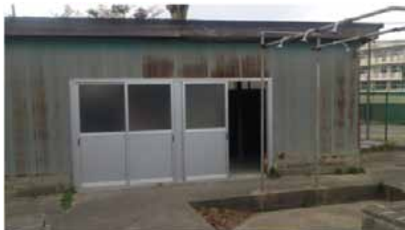
住吉小学校プール附属棟改築工事(改修前) 直営設計、工事発注、施工監理直営
