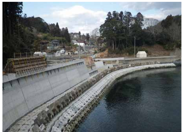
館浜海岸災害復旧事業施工状況 2
