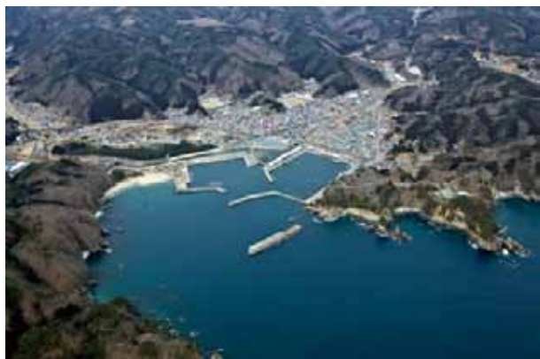
宮古市田老地区 被災前
