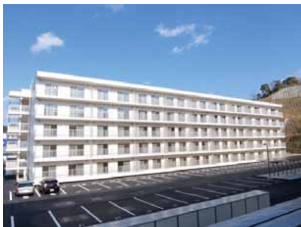
下神白団地1工区 完成(外観) H27.1
