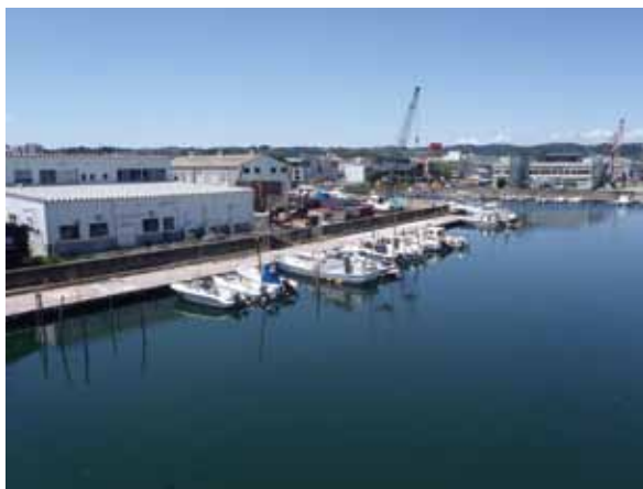
塩釜港区の災害復旧工事
