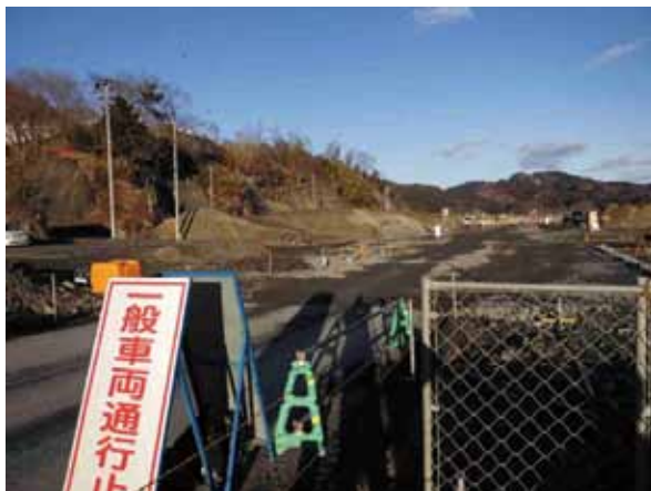
大槌町町方地区の盛土工事現場 (任期付職員担当現場) 2m程度盛土を行う
