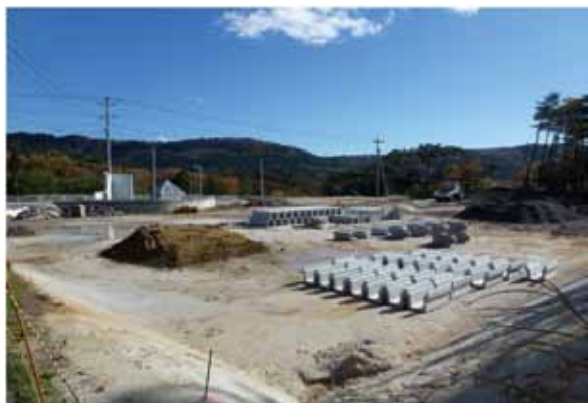
女川消防署牡鹿出張所建設予定地 (設計委託監督・工事発注・施工監理担当)
