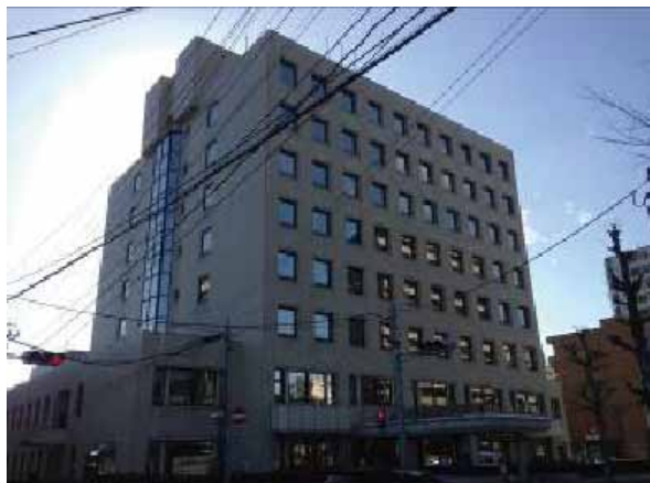
事務所が入っている福島県自治会館
