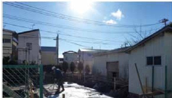
住吉小学校プール附属棟改築工事(改修中) 直営設計、工事発注、施工監理直営
