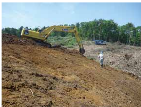
斜面地の表土剥ぎ 非常に難しい作業
