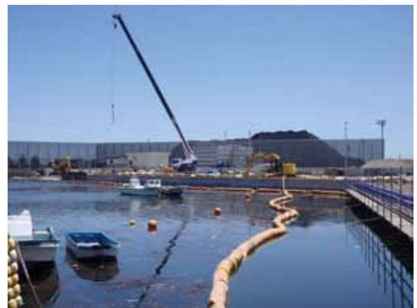
仙台港区の災害復旧工事
