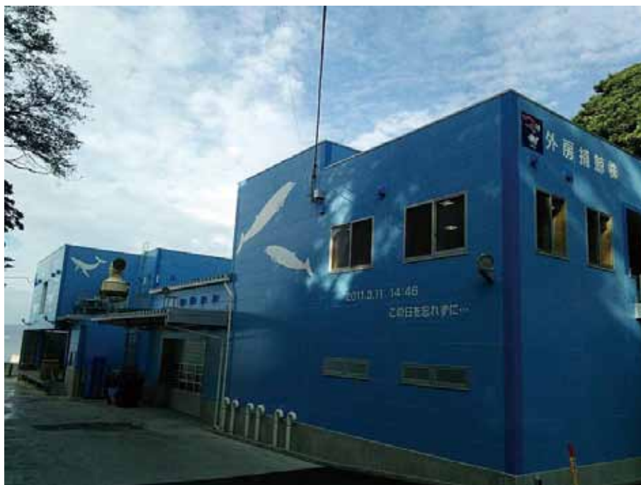
復旧後の施設
