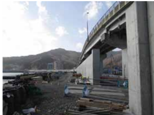
(H27.3離任時)スリット付防潮堤の復旧完了
