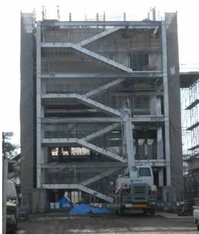
高台避難が困難な区域に建設中の津波避難タワー(大宮町H27.1.27)
