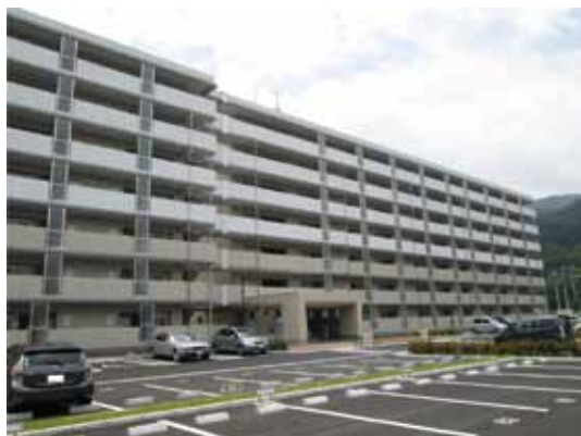
釜石市平田地区災害公営住宅(平成26年1月完成)
