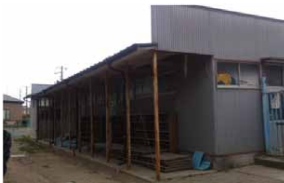
向陽小学校プール附属棟改築工事(改修前) 直営設計、工事発注、施工監理直営
