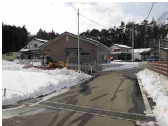
野田村米田地区高台団地 (任期付職員担当現場) 平成27年2月4日撮影
