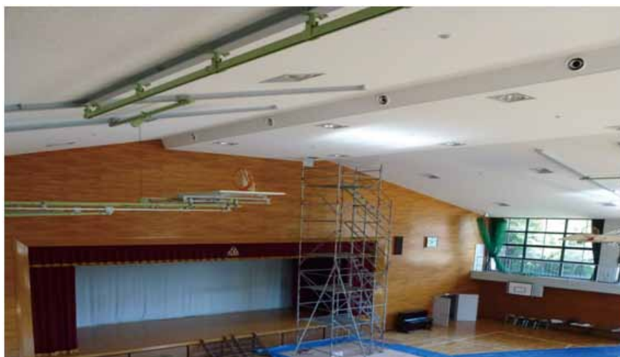
東浜小学校屋内運動場天井等落下防止対策 設計調査状況(設計監督員)
