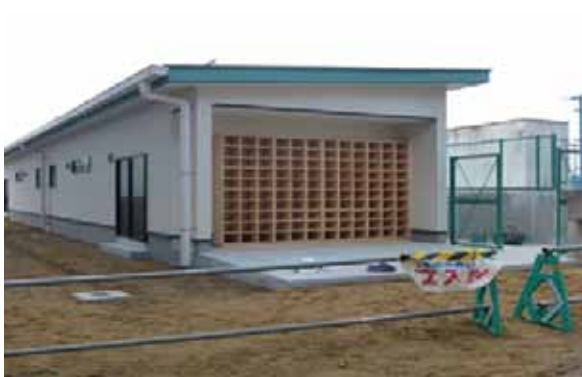
向陽小学校プール附属棟改築工事 (改修後)直営設計、工事発注、施工監理直営
