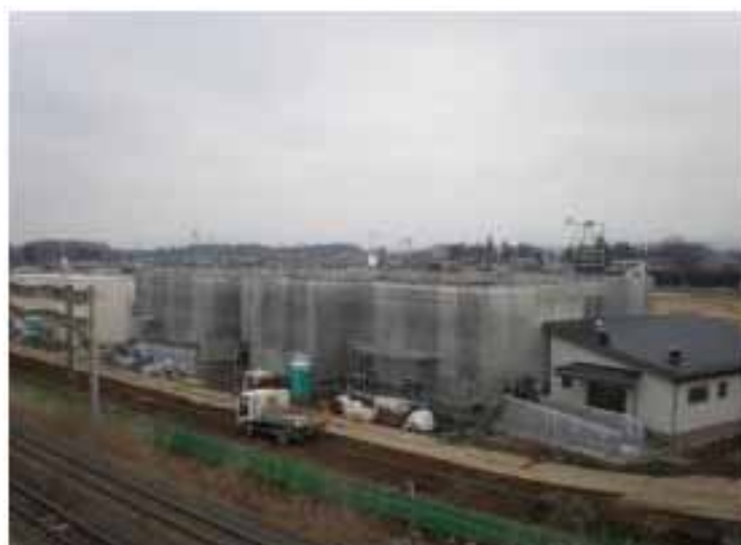
災害公営住宅 施工状況
