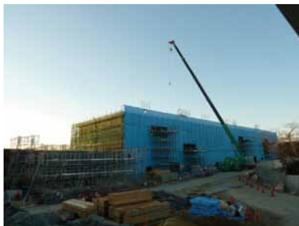
磐城農業高校校舎棟 施工状況 H27.1
