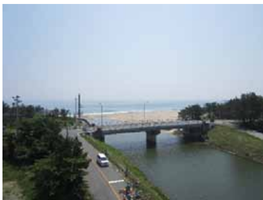
水門を設置する滑津川河口(H26.9撮影) 27年4月中頃から現場着工予定
