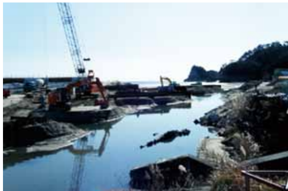
動き始めた水門工事 現況
