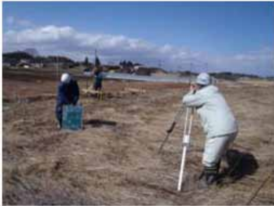
施工検査立会の様子①
