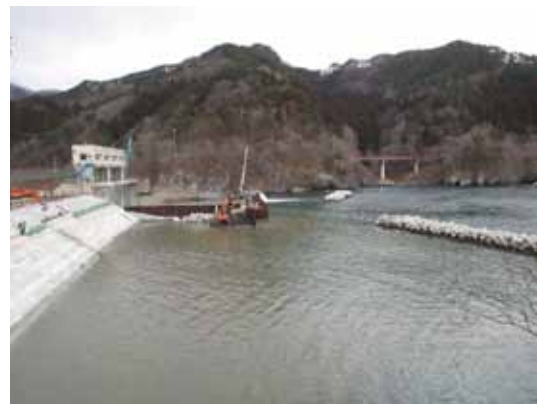
(H27.3離任時)防潮堤がTP+9.0m付近まで完成。仮締切を撤去完了
