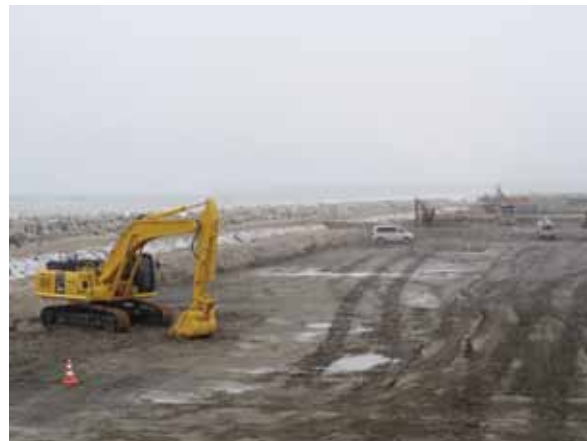
相馬松川浦漁港復旧現場
