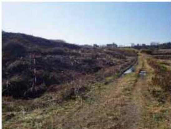
法面および排水路修復 工事着工前
