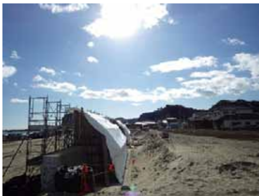
沼ノ内海岸(施工過程) 堤防嵩上げ工事(H27.1月撮影)
