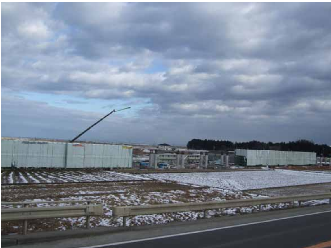
線路部分を高架にし、津波対策を施すJR新常磐線の工事状況(国道6号より撮影)
