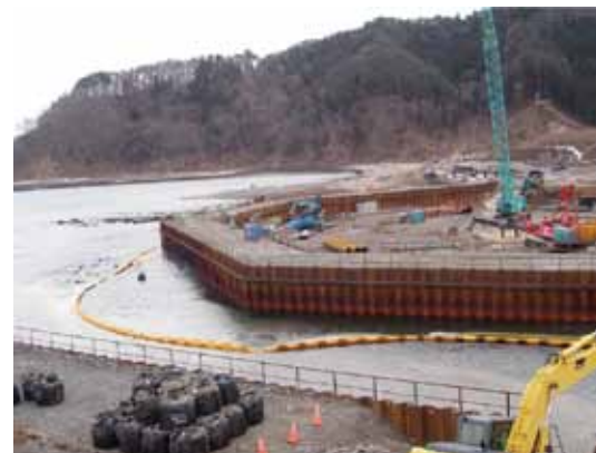
(H27.3離任時)河川を切回し、水門部仮締切工完了、基礎工事着手
