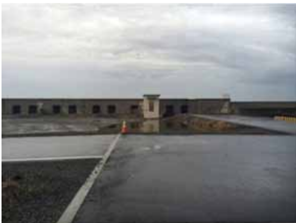
舗装工事実施予定の現場
