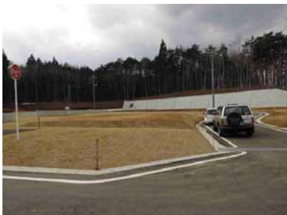
野田村米田地区高台団地 (任期付職員担当現場) 平成26年4月10日撮影
