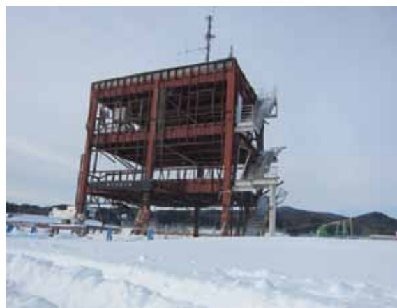
南三陸町防災庁舎(震災遺構候補)
