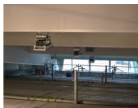
広瀨小防災機能強化工事 施工中
