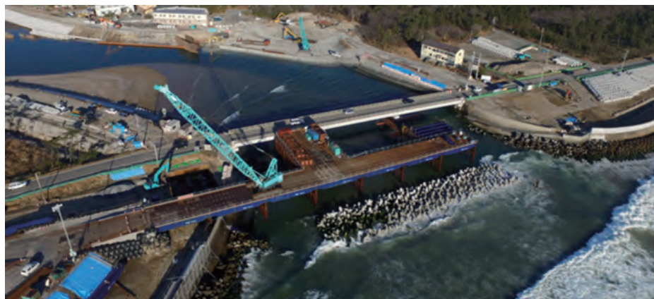
●四倉地区（東舞子橋） 栈橋と現橋の間に新橋を築造する
