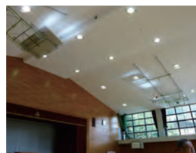
東浜小学校集会所 防災機能強化工事竣工前
