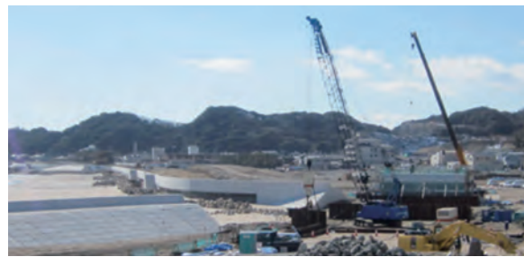
●すぐ下流河口部で橋台 築造中の諏訪橋（UR 委託）
