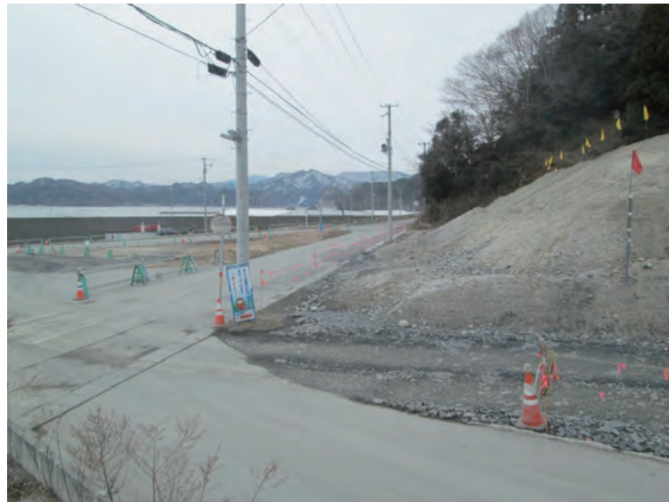
写真①県道吉里吉里釜石線 右側で区画整理事業の盛土を施工中です。
