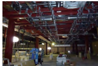
石巻東学校給食センター コンテナ室兼発送室
