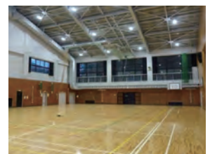
東浜小学校集会所 防災機能強化工事施工後
