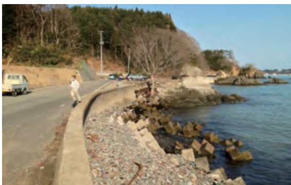
館浜海岸工事着工前（平成 25 年撮影）
