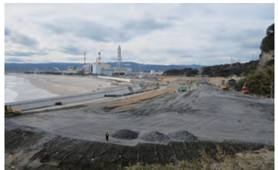
岩間工区 1月定点写真
