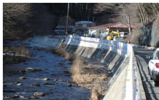
2016 年 1 月撮影（施工中）
