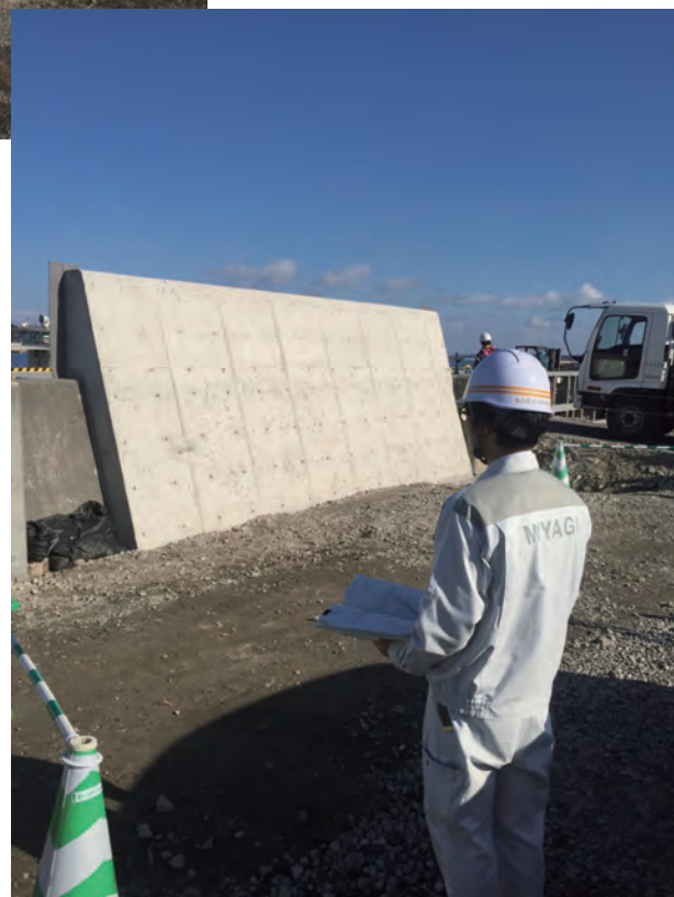
胸壁の高上げ工事の様子
