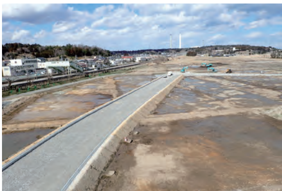
【2015.3 造成工事 途中】
