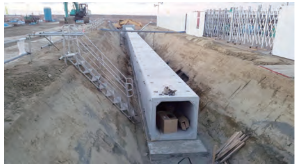
新門脇地区土地区画整理事業地内での下水道雨水災害復旧事業 【高盛土造成箇所：下水道雨水管敷設状況】
