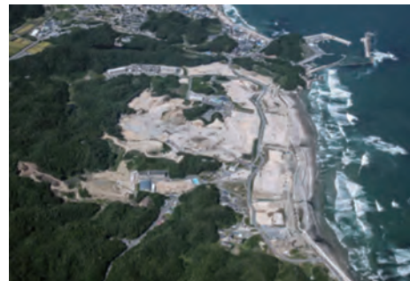
薄磯区域工事状況 平成27年9月撮影
