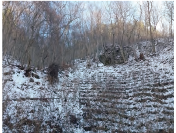
○境界確認中。標高約 1,000m、気温は零下、急傾斜こちらもしんどかったです。
