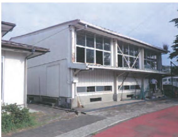
いわき総合高校南校舎耐震改修外工事（H27・9）
