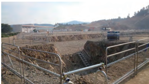
宅地造成を終えた志津川地区西団地東工区 ：平成 27 年 7 月
