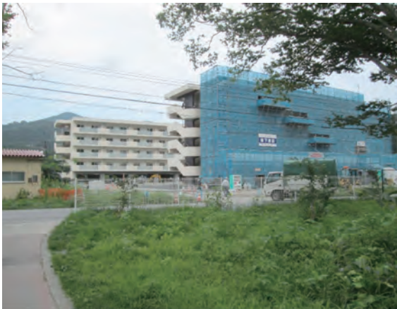
○災害公営住宅（建設中）
