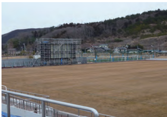
フットボール場 スコアボード改修工事施工中
