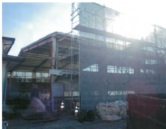
いわき総合高校南校舎耐震改修外工事（H27・12）
