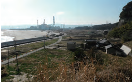
岩間工区 4月定点写真
