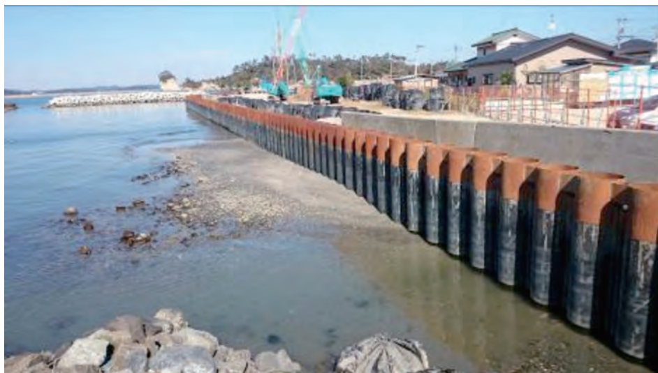
写真－住宅地が隣接する護岸災害復旧工事（代々崎清水護岸工事）
