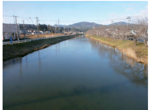
神山川上流の様子（工事未着手） H27.11
