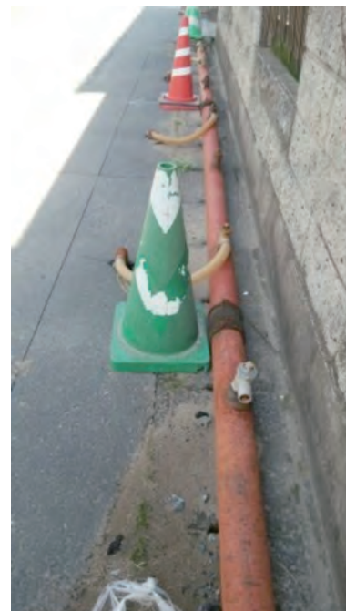
ウェルポイント工法による地下水低下工
