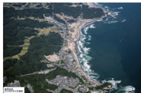
豊間区域工事状況 平成27年9月撮影
