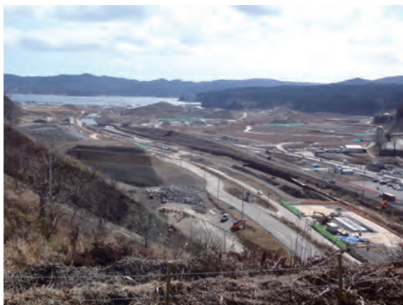
→ 南三陸町志津川地区（平成 28 年 2 月撮影）
