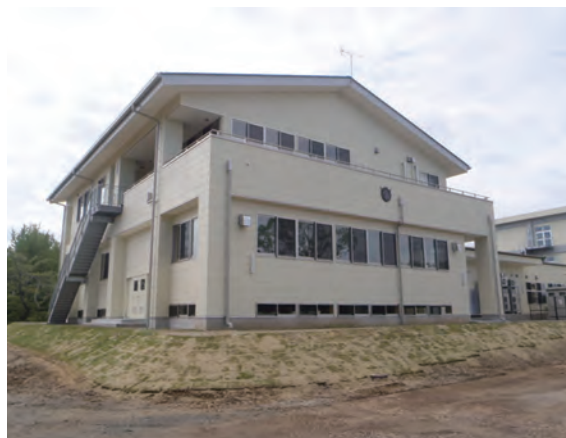
磐城農業高校実習棟改築工事（完成）
