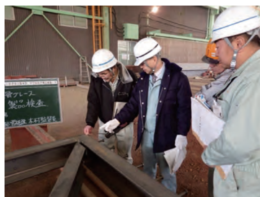
地震補強工事 工場検査
