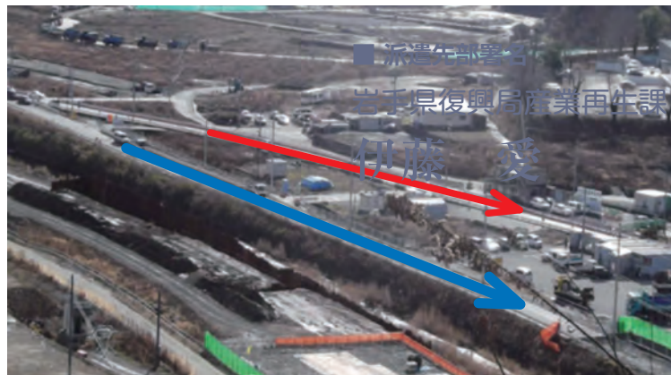
平成 28 年 1 月撮影。 かつての 398 号線（青線）から現在は仮設道路（赤線）で供用されています。 写真左端から道路工事が進められてくることになっています。写真下部では 橋梁の工事が始められました。
