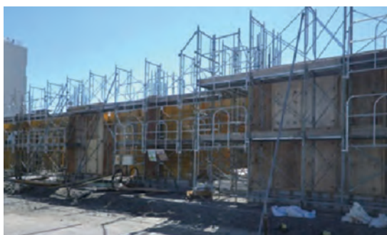
管理運営（再復）工事（施工中 H27・8）
