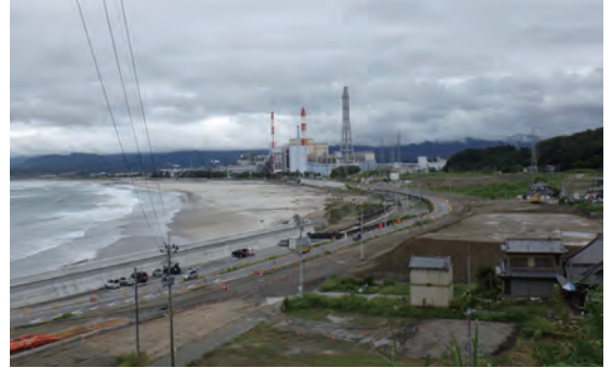
岩間工区 8月定点写真
