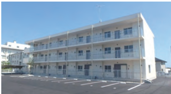
平八幡住宅 外観写真 H27・8
