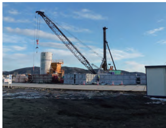
渡波中移転新築工事
