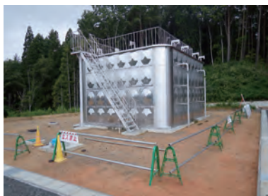
平成27年10月（配水池）
