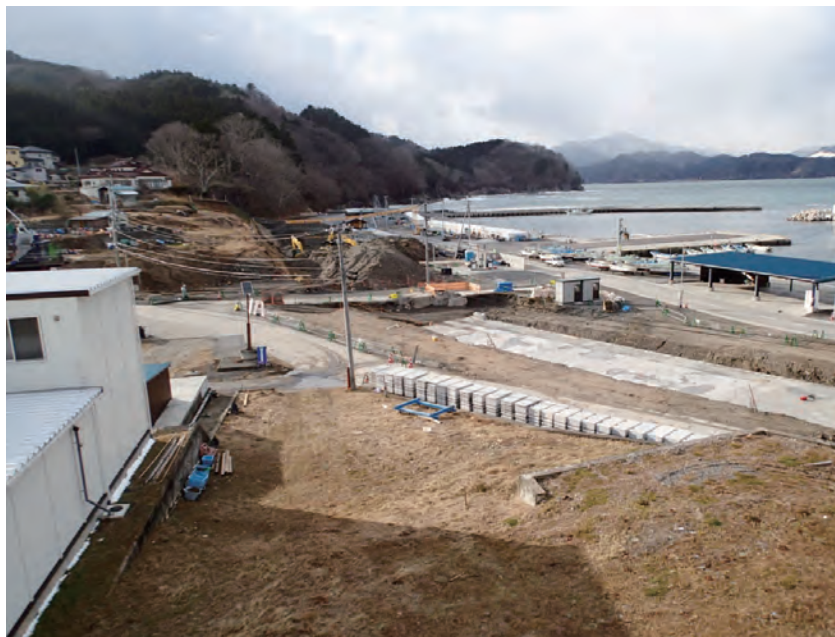
写真②白浜（鵜住居）漁港 右側中央部で防潮堤基礎打設中 左端に防潮堤用地にあって移転（再築）された漁具倉庫
