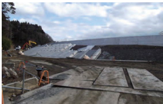
用地買収完了、工事中（平成 27 年撮影）
