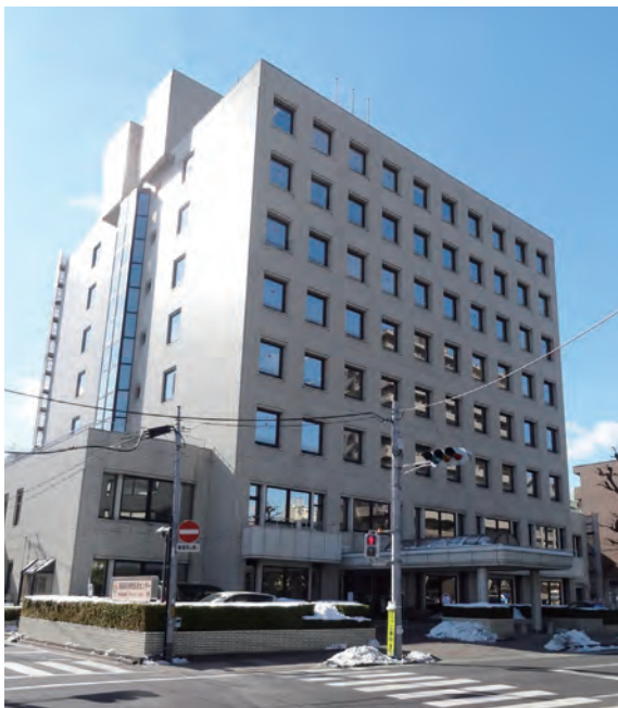
福島県事務所が入る福島県自治会館 平成 28 年 2 月撮影
