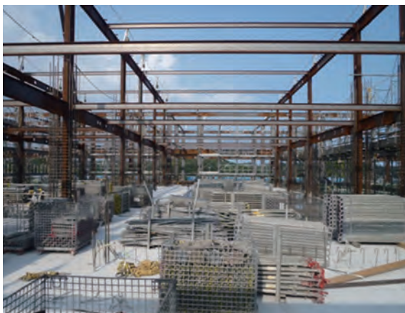
磐城農業高校実習棟改築工事（施工中）
