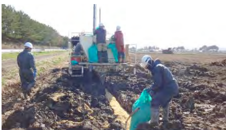
担当地区工事：左・施工中
