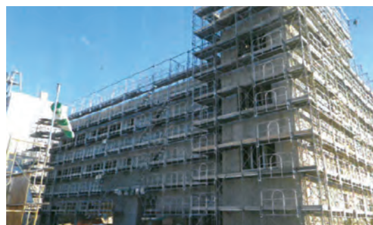
管理運営（再復）工事（施工中 H27・12）
