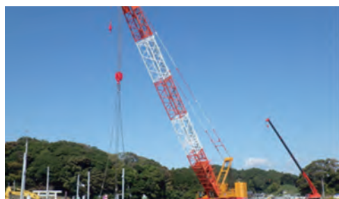
●東北に2機しかない 500t クレーンで旧橋撤去
