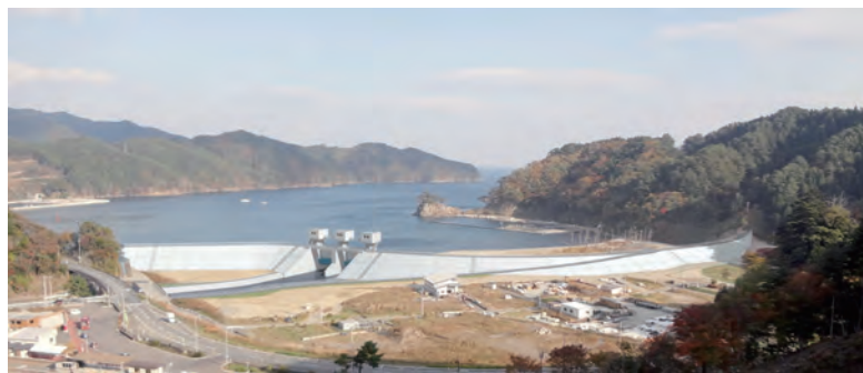
小白浜海岸防潮堤災害復旧事業（H 30 年 1 月末完了予定）
