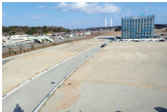
【2016.1 造成工事 現在】
