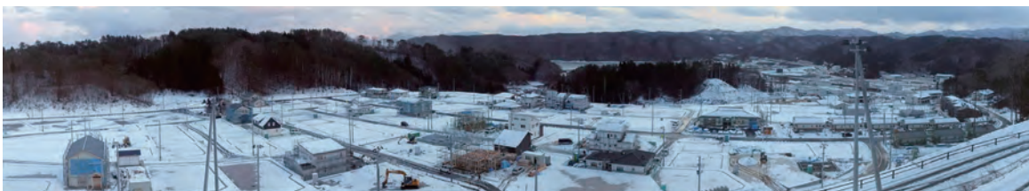
宮古市田老地区三王団地・まちはらき直前（平成 27 年 9 月）と住宅の建築状況（平成 28 年 1 月）
