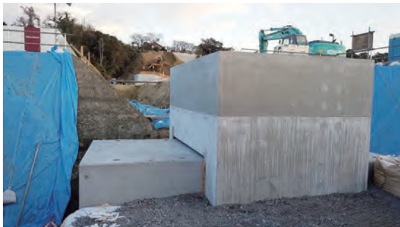
新門脇地区土地区画整理事業地内での下水道雨水災害復旧事業 【高盛土造成箇所：下水道雨水管敷設状況】
