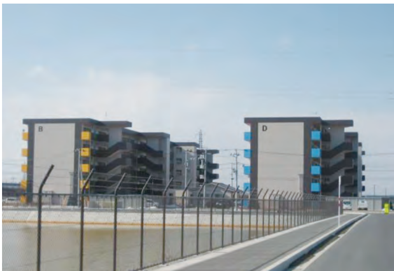
新蛇田地区被災市街地復興土地区画整理事業が進められている様子（H28.2.5 撮影）
