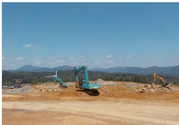
牧沢地区造成工事（転石発生状況）
