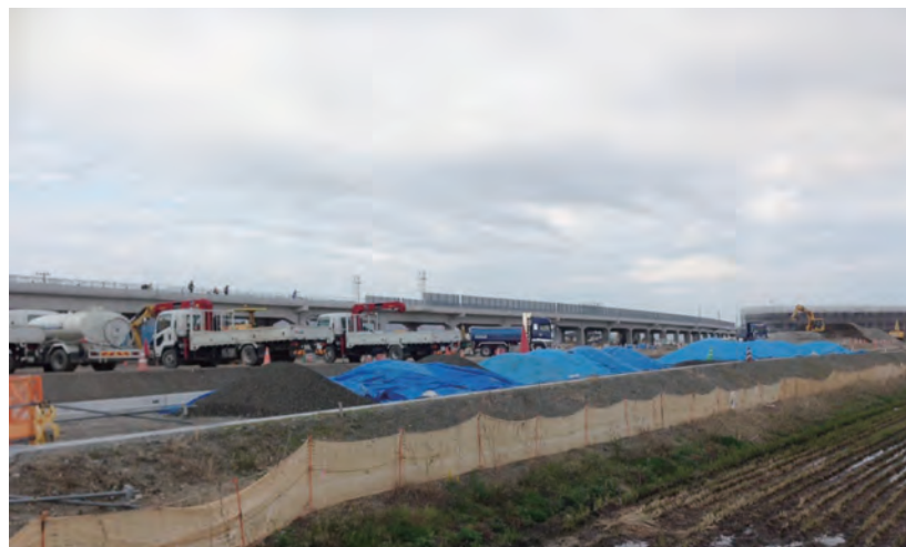
< JR 常磐線の新坂元駅周辺の整備工事風景>
