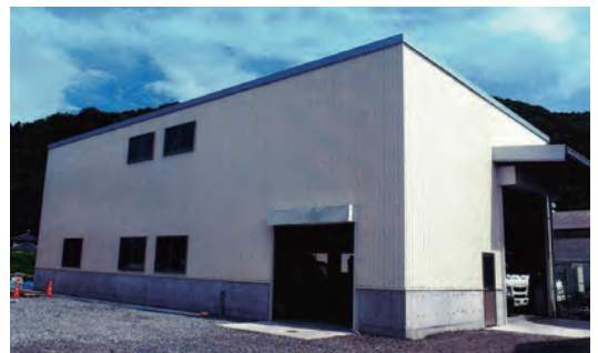
復旧した工場
