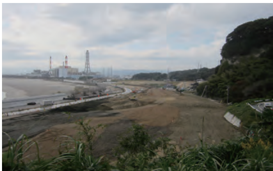
岩間工区 10月定点写真
