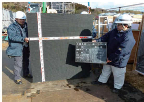
スコアボードパネル材料検査
