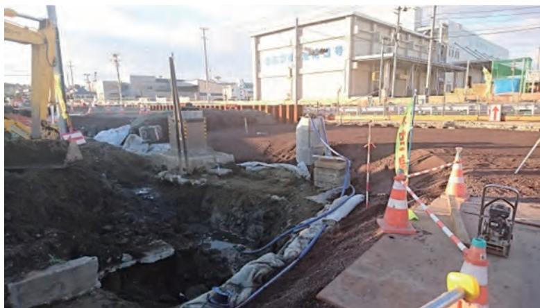
道路のかさ上げ工事中的写真です。この場所では、1.5 mほどかさ上げを行います。
