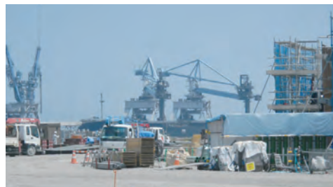
相馬市松川浦漁港復興の様子 （平成27年7月頃）
