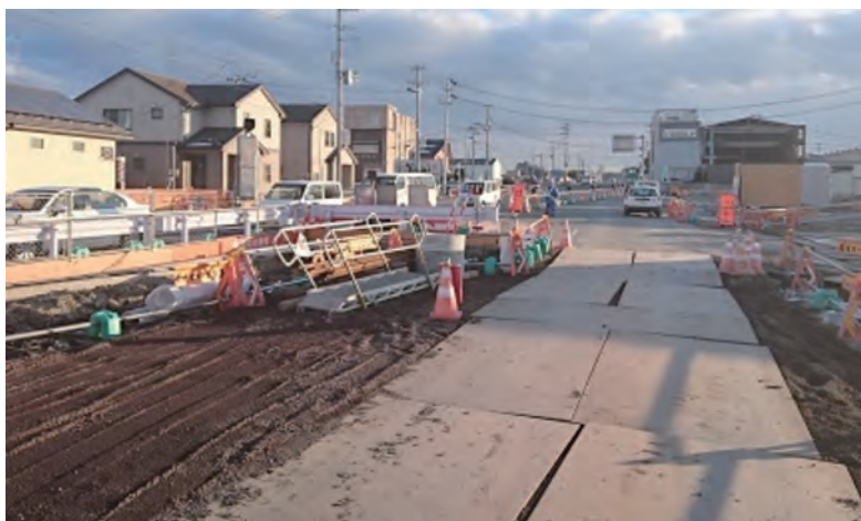
道路かさ上げ工事中現場から、八幡築港線拡幅工事現場を撮影。
