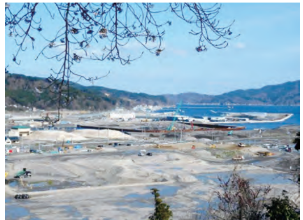
＜山田町＞湾の縁には防潮堤建設の高い鉄杭が見える。＜大槌町＞港湾・工場地帯の工事(奥)と嵩上げ・区画整理(手前)が進む
