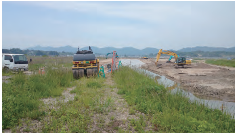
<戸花川の堤防復旧工事風景：手前側は未買収の多数名共有地>
