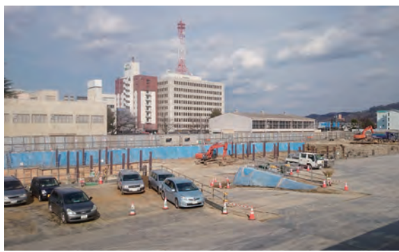
県警本部現場 進捗状況 (H28.2)
