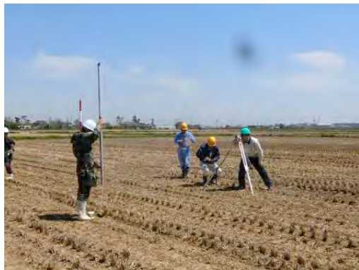
暗渠排水工事現場立会状況
