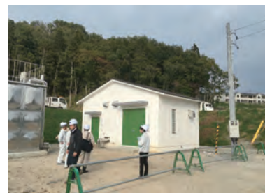
平成27年10月（ポンプ場）
