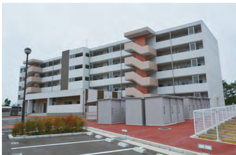
竣工した災害公営住宅（宮古市）
