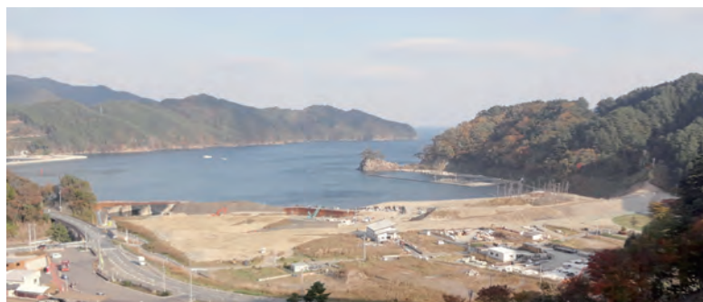
小白浜海岸防潮堤災害復旧事業（H 27 年 11 月末現在）
