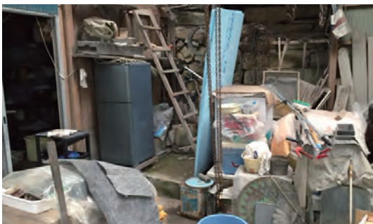
被災工場の写真
