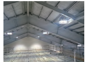
飯野川小学校屋内運動場 防災機能強化工事
