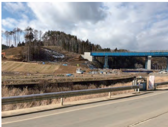
伊里前川上流部と三陸道
