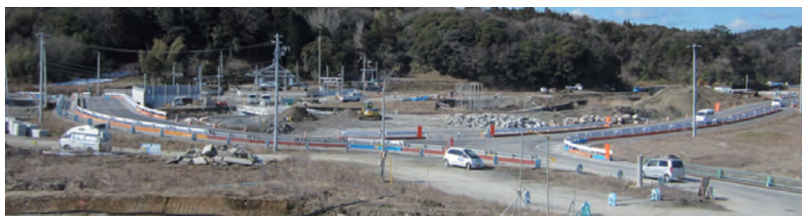
●迂回仮県道 中央部で豊間橋の橋台築造中
