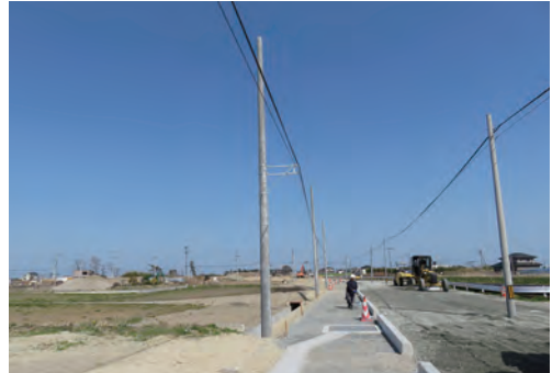
工事中（電柱移設時）
