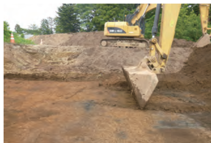
小型重機でのすき取り作業
