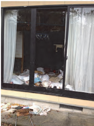
(右写真：イノシシが窓ガラスを壊して家屋に侵入)
