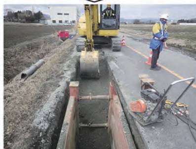
② 掘削状況
