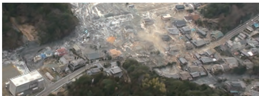
小浜地区被災状況
