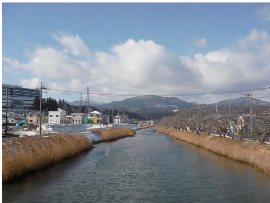
神山川。右側は桜。左側に一部施工済み区間。左奥は新気仙沼市立病院
