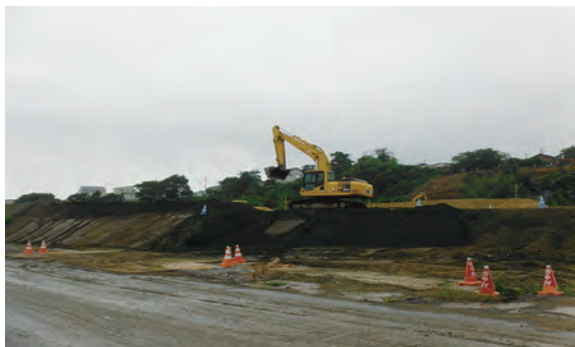
1. 平成 27 年度 新門脇地区被災市街地復興土地区画整理事業 南光門脇線整備事業（盛土道路整備）
