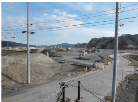
大槌町町方地区（平成26年12月）
