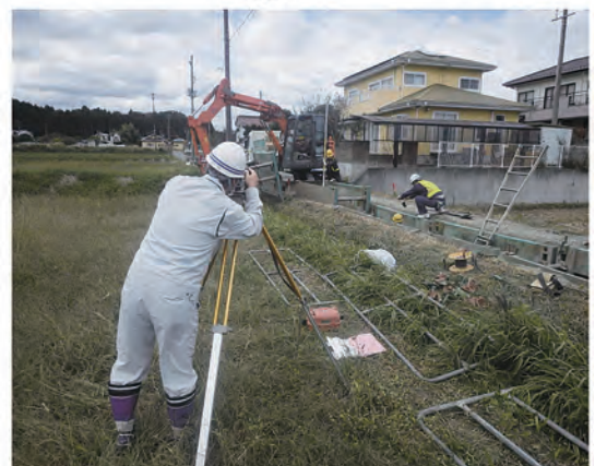
立会状況 (丁張高さ確認)
