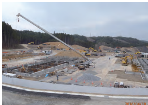
南三陸町志津川中央地区（災害公営住宅建設中）の復興状況（平成 28 年 4 月撮影）
