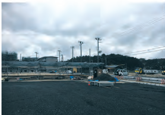
中心市街地に建設中の共同店舗（山田町）
