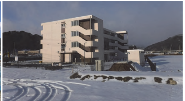
災害公営住宅片岸地区
