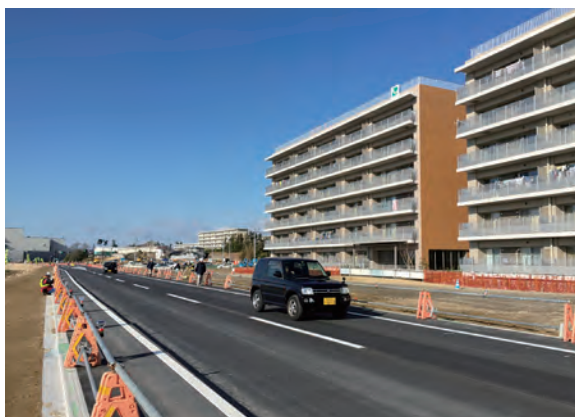
4. 平成 28 年度 新門脇地区被災市街地復興土地区画整理事業南光門脇線整備事業（盛土道路整備） 復興公営住宅整備事業 道路下に雨水幹線
