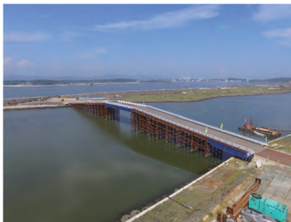
資材運搬のための仮設橋：相馬地区
