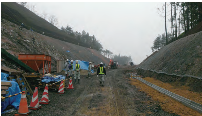
建設中の戸倉復興道路（平成 28 年 4 月）
