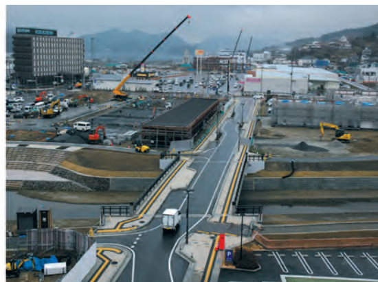
本設が進む中心市街地（大船渡市）
