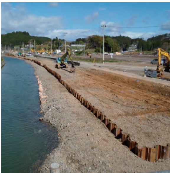
二級河川水尻川災害復旧事業（河川堤防工事）の様子 （本吉郡南三陸町：平成28年5月撮影）
