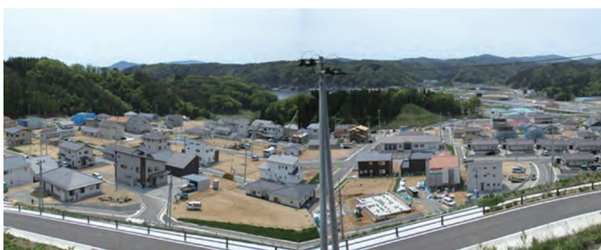
写真3 (住宅建設中：自力再建した多くの住宅が見えます) 平成28年6月撮影
