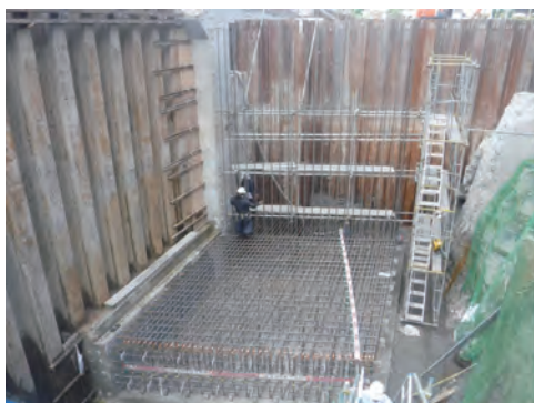
橋梁半断面施工状況 (下部工配筋状況)
