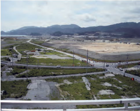
区画整理工事が進む中心市街地（陸前高田市）
