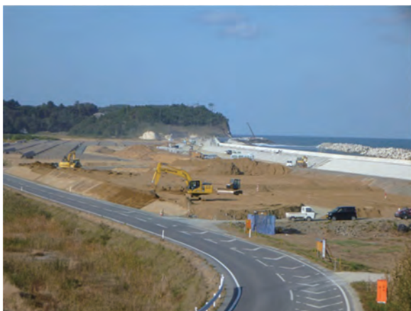
防災林造成工事実施状況：鹿島地区
