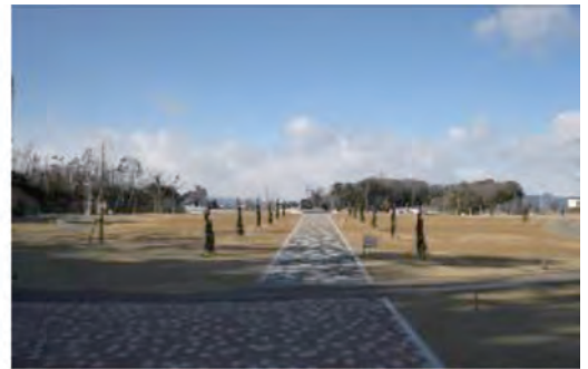
植栽等施工状況（御製碑プロムナード）H29.2.2 現在
