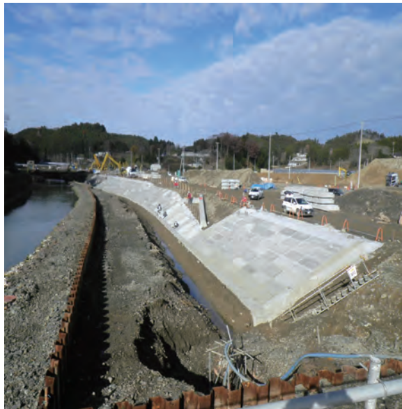
二級河川水尻川災害復旧事業（河川堤防工事）の様子 （本吉郡南三陸町：平成28年11月撮影）
