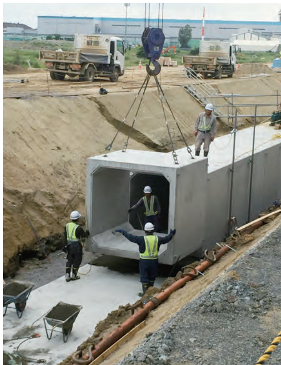
2. 平成 28 年度 南光門脇線整備事業（盛土道路整備） 盛土道路整備に合わせ雨水幹線工事を実施
