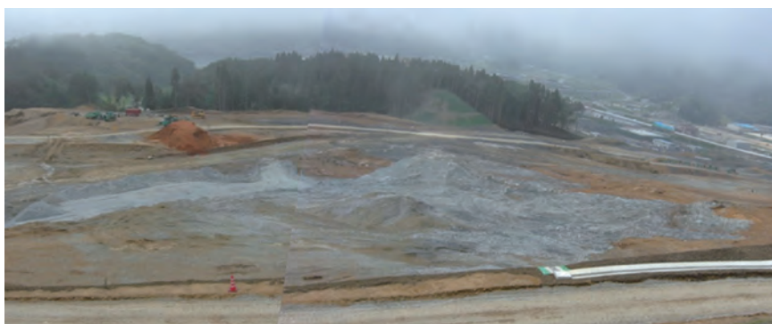
写真1 (造成中：切土がほぼ終わった状況です) 平成26年7月撮影
