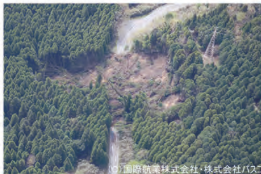
図3 19次査定現場 被災状況写真
