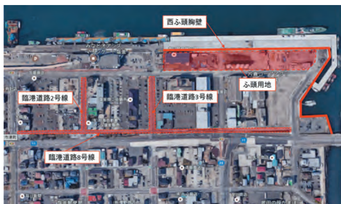
西ふ頭胸壁災害復旧（その2）工事
