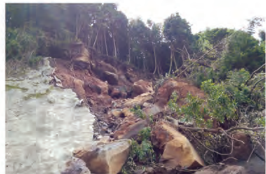
図4 20次査定現場 被災状況写真
