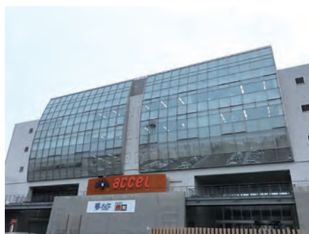
事務所全景（5階が事務所）
