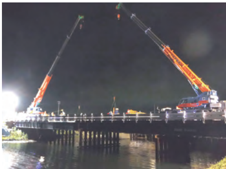
蛭田橋（びんだばし） 夜間通行止めで一気に作業を進める。
