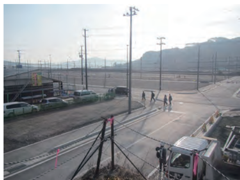
大槌町町方地区（平成28年12月）
