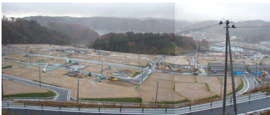
写真2 (造成完了：道路や宅地境が分かります) 平成27年11月撮影
