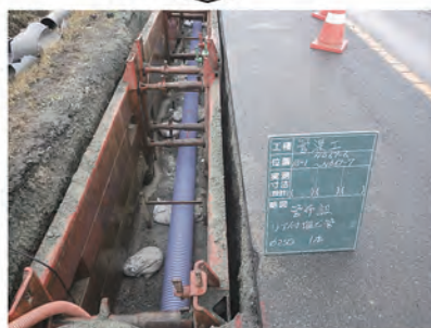
③ 管渠布設状況
