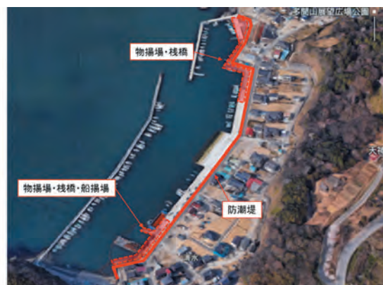
代ヶ崎清水防潮堤外災害復旧工事
