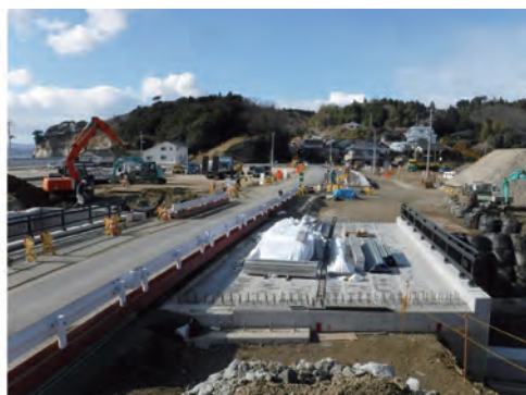
橋梁半断面施工状況 (上部工施工状況)
