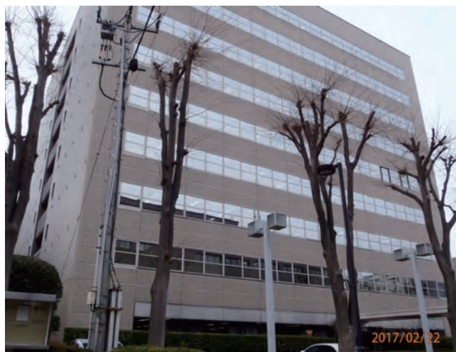
現地事務所の入る宮城県自治会館
