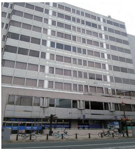
【旧岩手県事務所のあった建物（外観）】 中ノ橋 106ビル 7階
