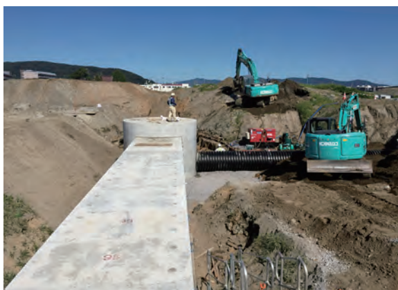
3. 平成 28 年度 南光門脇線整備事業（盛土道路整備） 雨水幹線敷設工事完了
