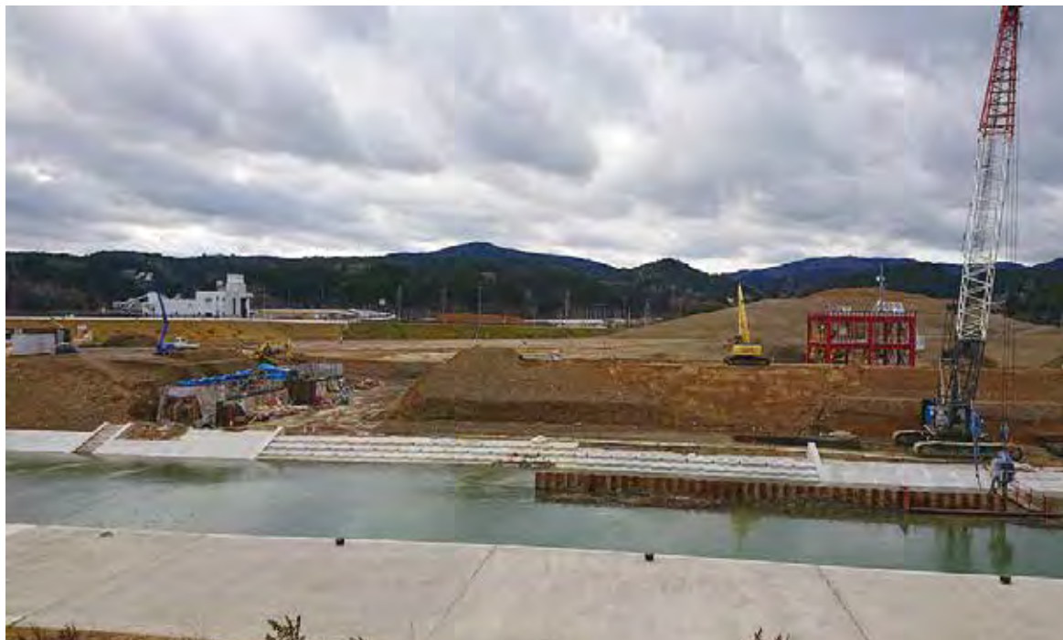
県道志津川登米線復興道路事業（道路改良）
