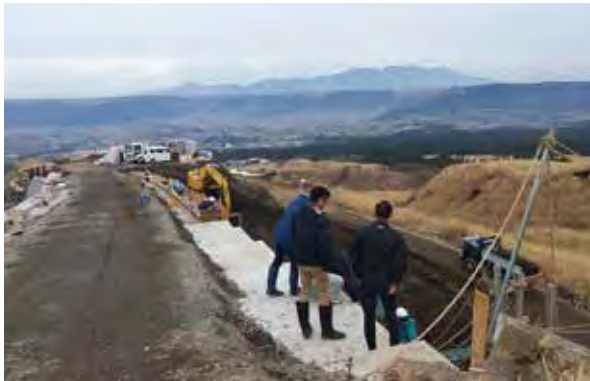
12月 市町村成功認定 阿蘇市仙酔峡工事現場
