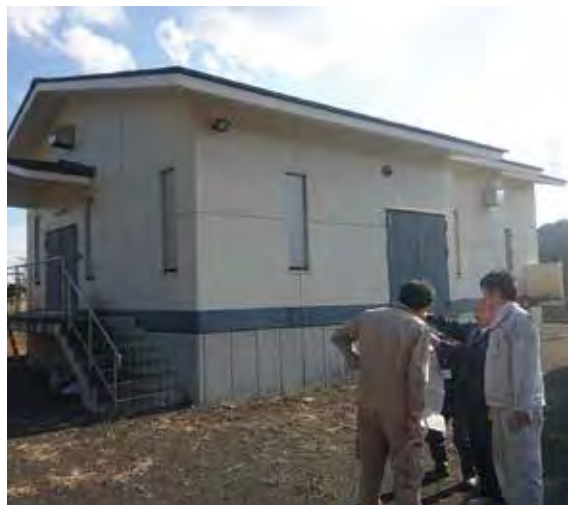
避難指示区域内(双葉町)の現地調査 工事中のポンプ所の調査
