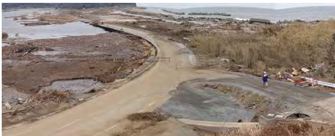
写真D 平成23年3月25日撮影 被災後（写真Cと同じ箇所）
