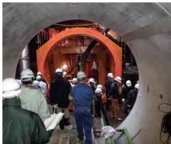
【建設現場内（H30.11）】 主催した工事現場見学会
