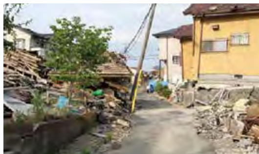
（写真2）狭隘道路沿いの家屋倒壊
