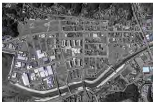
復興が進む鹿折地区 (H30.9)
