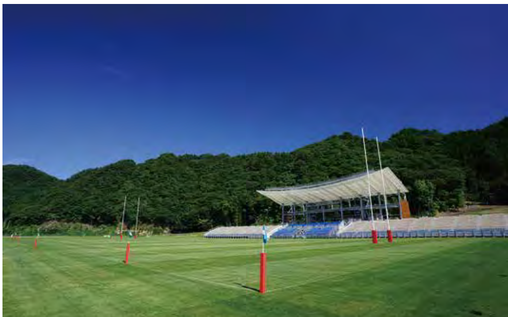
鵜住居地区に隣接して整備された「鵜住居復興スタジアム」 （釜石市 face book より）
