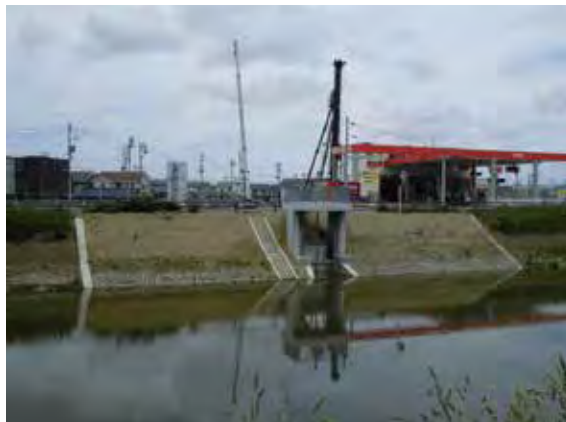
完成後の現場状況（平成 30 年 12 月）
