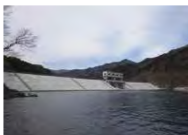
水海水門防潮堤
