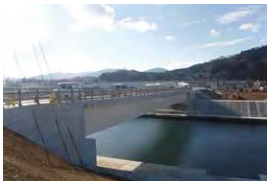
架替が完了した浪板橋 (H30.12)
