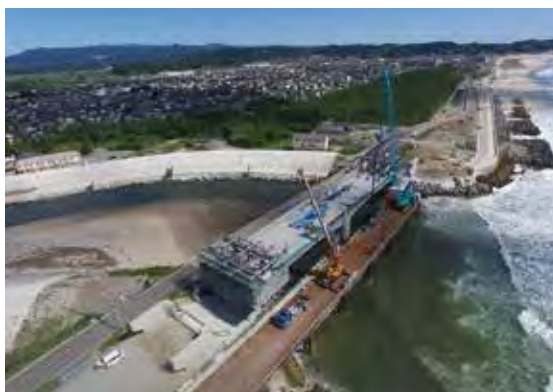
建設が進む東舞子橋 [H30.6]
