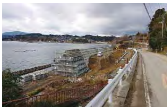
荒砥地区海岸災害復旧事業（防潮堤建設）
