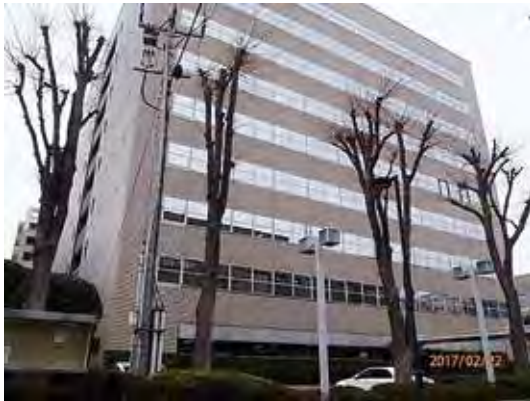
現地事務所の入る宮城県自治会館
