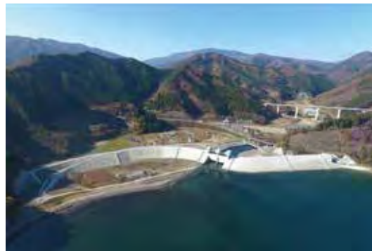
H30.11 水門防潮堤（ほぼ）完成
