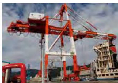
釜石港ガントリークレーン
