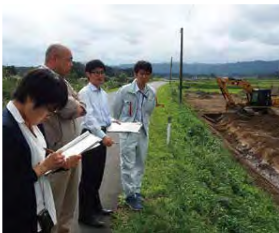
被災地域にて圃場整備（農地整備）の現場視察 （平成30年10月）
