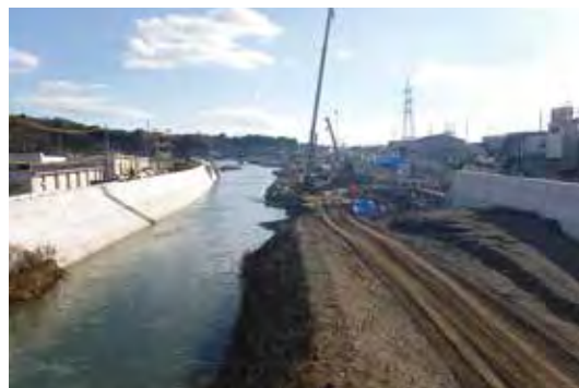
防潮堤工事が進められている鹿折川 (H30.12)
