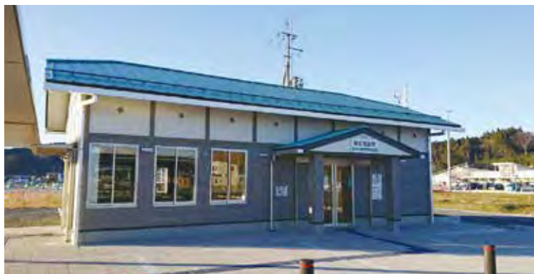
< JR 陸前高田駅 > 筆者が家屋評価を担当した新築の駅舎。 BRT（バス高速輸送システム）により 運行中。
