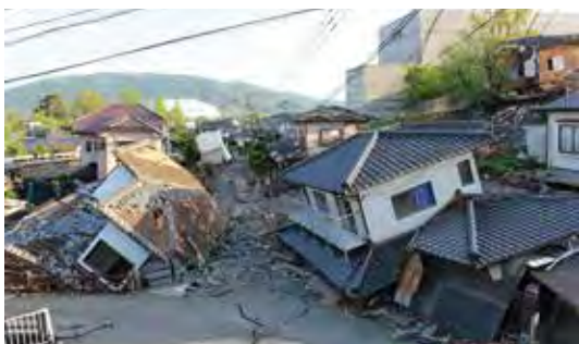
（写真3）区域内道路沿いの家屋倒壊
