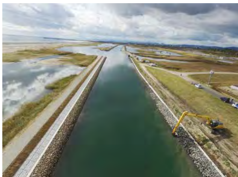
一級河川名取川水系北貞山運河（工事中）
