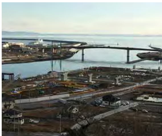
【建設現場の全景（H30.12）】 中央排水ポンプ場
