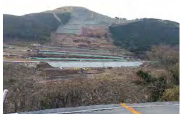
12月 国直轄ですが、国道57号の工事現場 谷間には阿蘇大橋が今も残っています。
