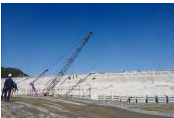
復旧工事中の片岸海岸防潮堤。復興も大詰めを迎え、急ピッチで作業が進んでいます
