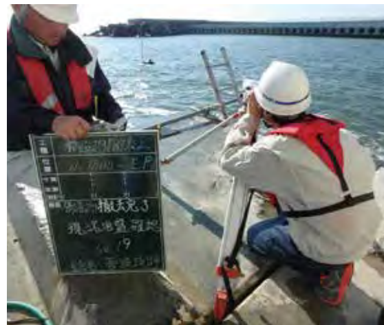
H30.11.28 現場立会い (基礎捨石投入前現況地盤確認)
