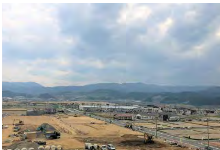
盛造成工事が進む様子 (平成 30 年 6 月、陸前高田市)
