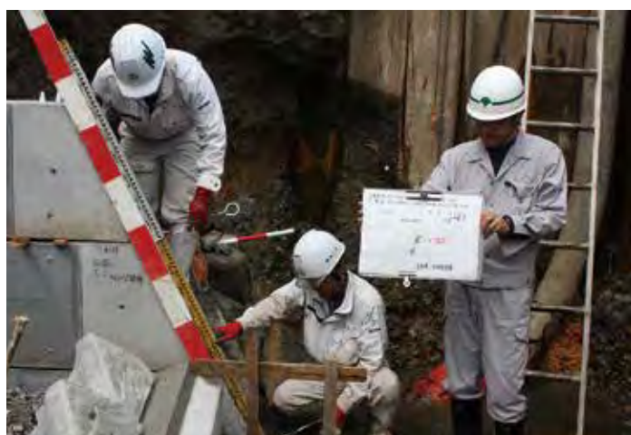
段階検査（2018年5月撮影）
