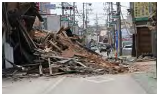
（写真4）家屋倒壊による交通機能の喪失
