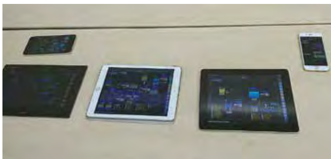
スマートフォンやタブレット端末による水道施設の 遠隔監視・操作システム(南会津町)
