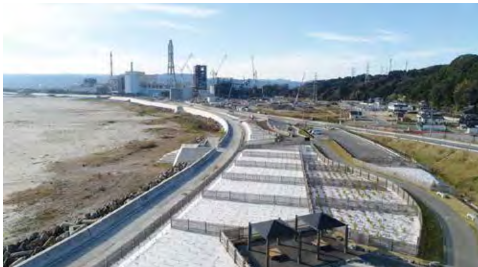
概成した岩間防災緑地（写真奥は火力発電所）
