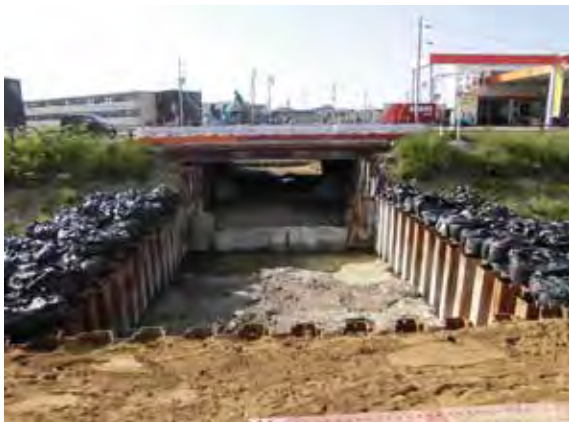
派遣直後の現場状況（平成 29 年 5 月）
