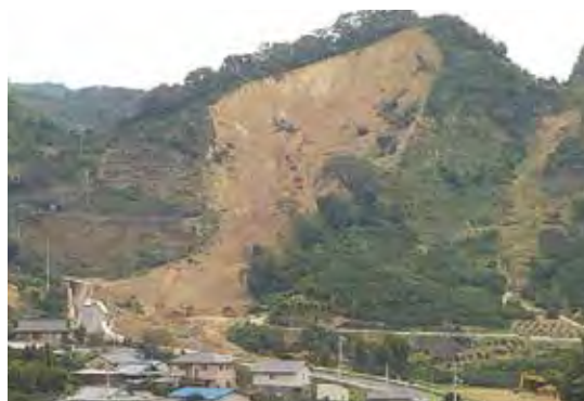
樹園地崩落、モノレール流失（宇和島市吉田町）
