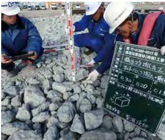
H30.11.20 現場立会い (上部工撤去後小割寸法確認)
