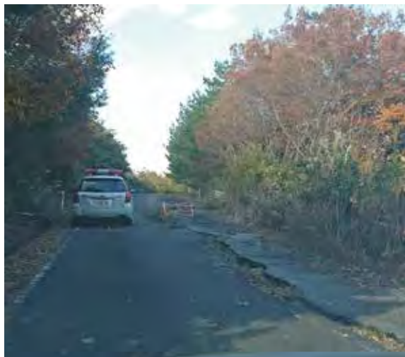
避難指示区域内(双葉町)の現地調査 震災後そのままの道路
