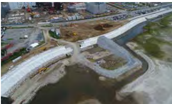
仮設道路（海岸工事）の切替状況
