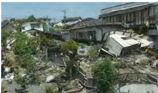
（写真1）家屋及び宅地擁壁の倒壊
