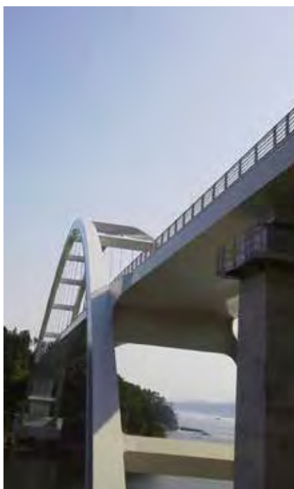
気仙沼市にある大島架橋
