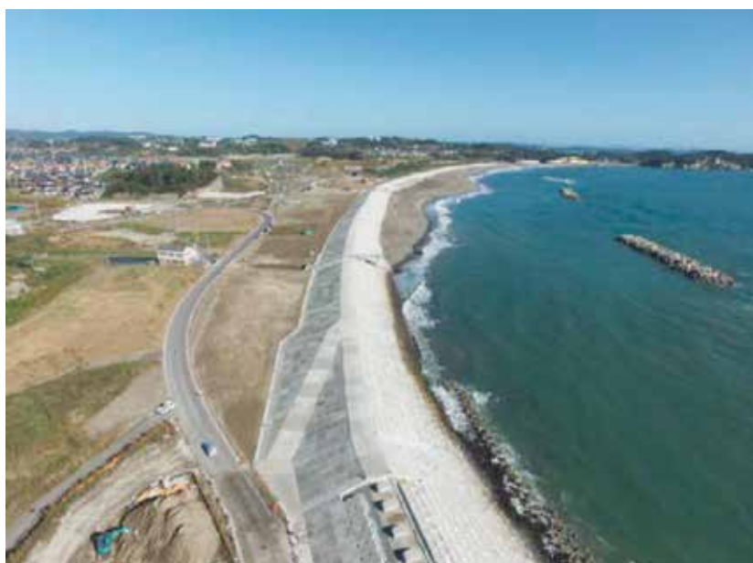
菖蒲田浜海岸防潮堤（平成 30 年 3 月完成）
