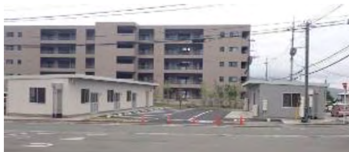
手前：仮設店舗 奥：災害公営住宅
