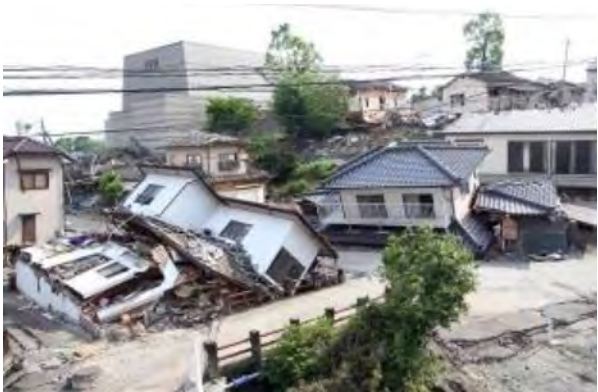
倒壊した建物
