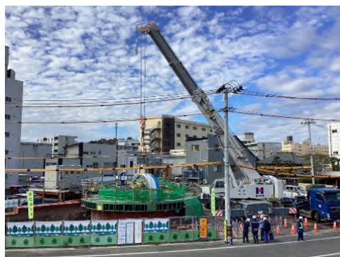
【施工中の全景（R4.11）】 住吉1号幹線シールドマシンの投入組立
