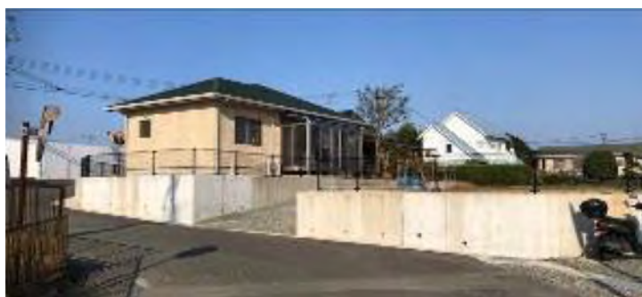
再建が完了した住宅
