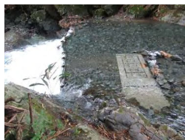
8月の大雨による導水管路土砂流失による露出及び取水口取水堰
