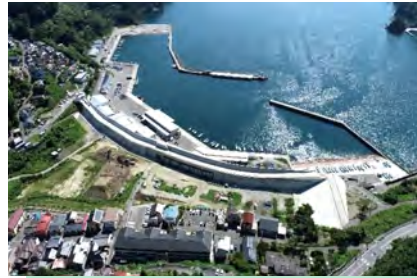
● 完成した小白浜漁港防潮堤 (岩手県)
