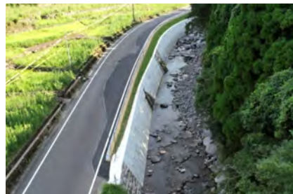
● 令和2年7月豪雨被災道路の復旧工事 (熊本県)
