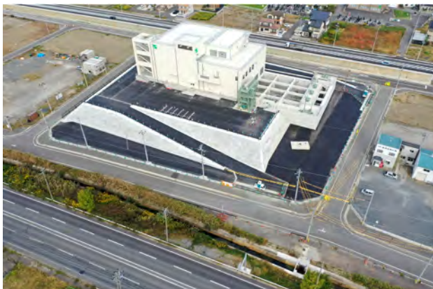
【建設現場全景（R4.11）】 完成した石巻港排水ポンプ場
