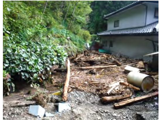
＜大量の土砂と流木が民家を襲った様子＞
