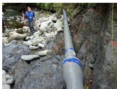
8月の大雨による導水管路土砂流失による露出及び取水口取水堰
