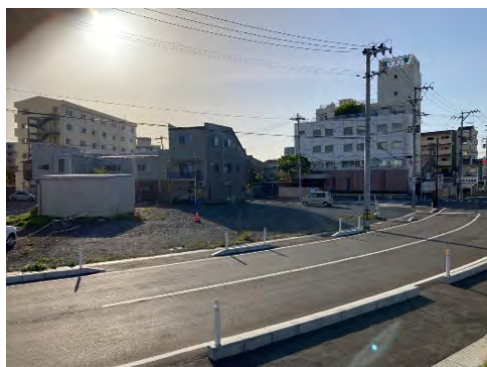
【施工前の全景（R4.4）】 住吉1号幹線発進立坑用地
