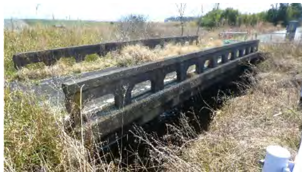
震災前は利用されていた増田橋
