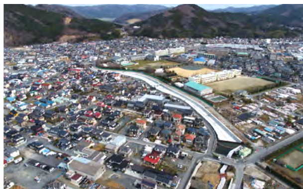
【建設現場全景（R4.4）】 施工中の赤堀調整池
