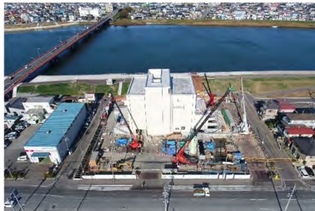
【建設現場全景（R4.11）】 施工中の不動沢排水ポンプ場
