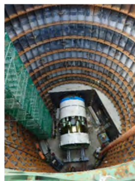
【施工中の全景（R4.11）】 住吉1号幹線シールドマシンの投入組立
