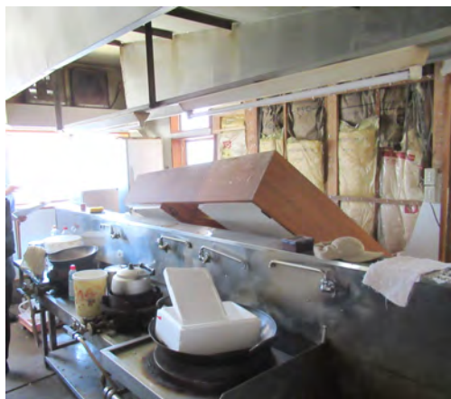
事業者（飲食業）の被害確認視察 （令和 4 年福島県沖地震分）
