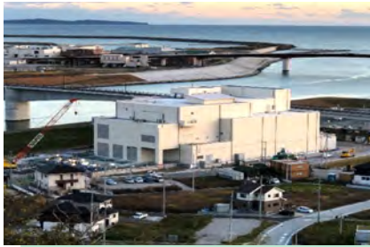
● 施工中の中央排水ポンプ場 (R4.11) (石巻市)
