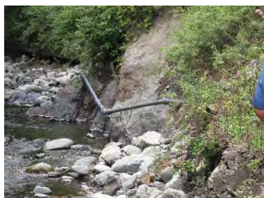
8月の大雨による導水管路土砂流失による露出及び取水口取水堰
