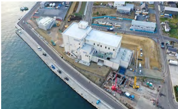
【建設現場全景（R4.11）】 施工中の渡波排水ポンプ場
