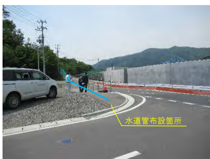
大船渡市永浜地区 現地調査 (5月撮影)
