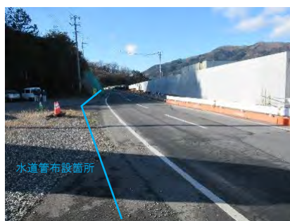
大船渡市永浜地区 現地調査 (12月撮影)
