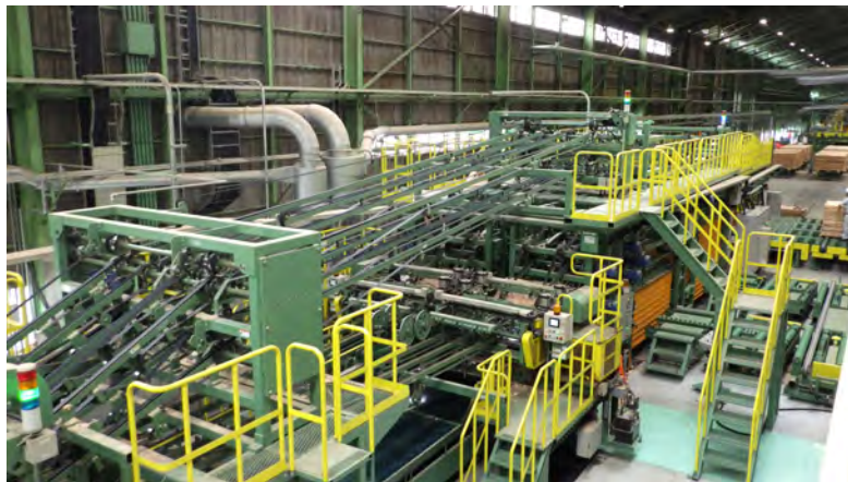
事業者（製造業）の復旧設備 （東日本大震災分）
