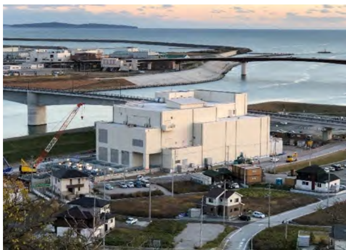
【建設現場の全景（R4.11）】
