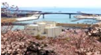
日和山より望む完成した 石巻中央排水ポンプ場（石巻市）
