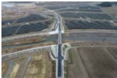
浜街道バイパス道路工事 （角部内工区：福島県）
