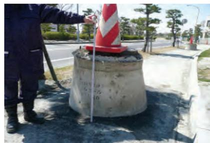
液状化によって突出した人孔(浦安市)
