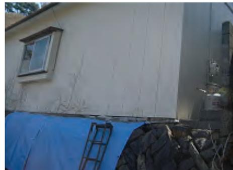
擁壁崩壊、基礎の著しい被害(Cランク)
