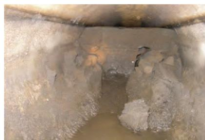
液状化によって管渠内に堆積した土砂(香取市)
