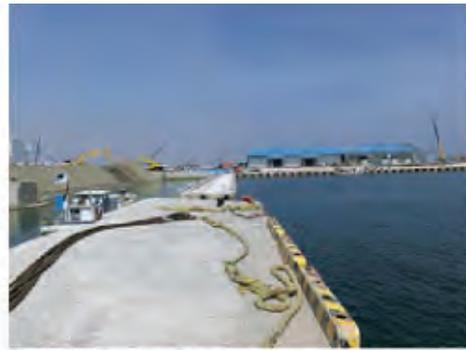
写真手前が復旧前で、50cm 沈下し、50cm 海側へ傾いている
