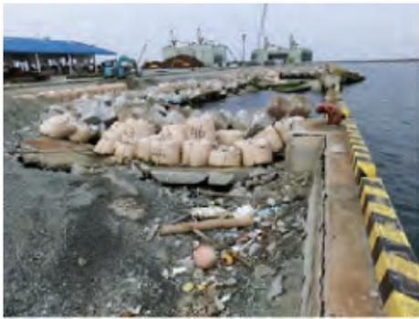
損失板岸壁の倒壊
