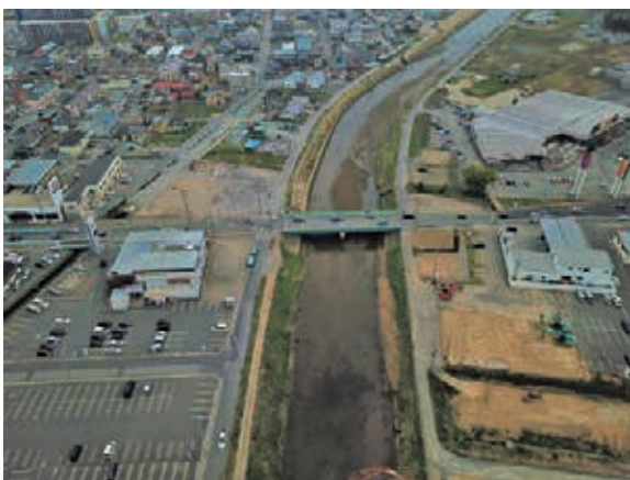
神山川橋工事着手前（平成 30 年 5 月）
