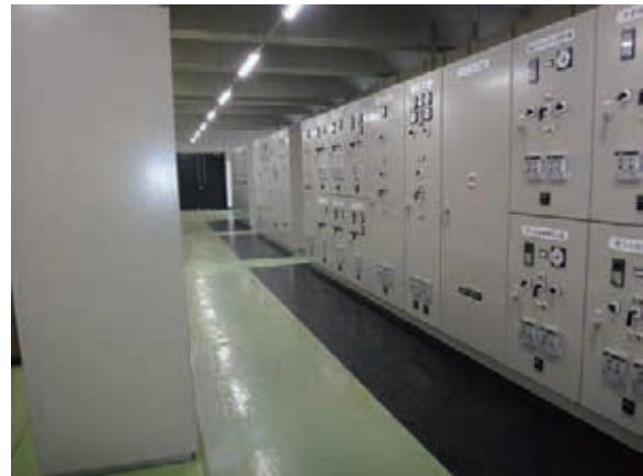
電気室（復旧後）
