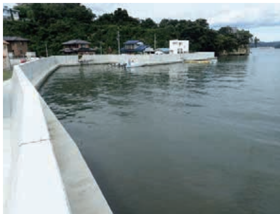
東宮浜の災害復旧工事完了後
