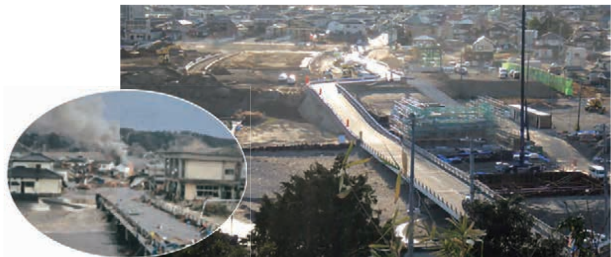
いわき市久之浜地区（蔭磯橋）
