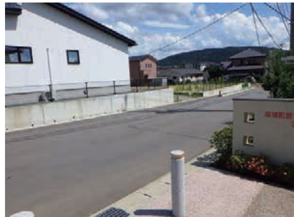
区画整理による宅地造成
