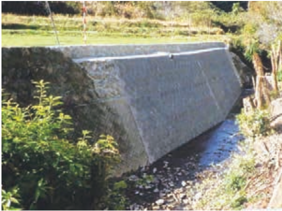
椽元川（復旧工事後）
