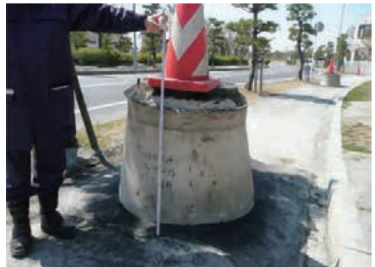
液状化によって突出した人孔（浦安市）
