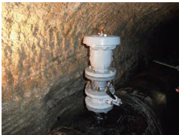
空気弁の取替に伴い補修弁を設置
