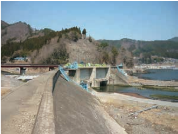
小白浜海岸の被害直後（平成23年4月）
