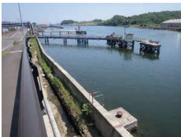
貞山通胸壁整備着手前
