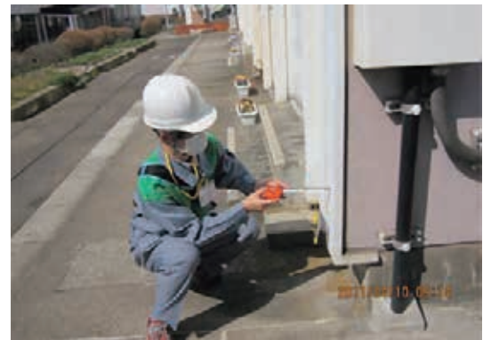
建築職による建物調査
