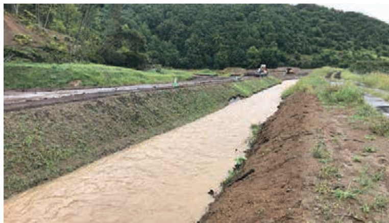
ハビウ川護岸工事（令和2年9月）
