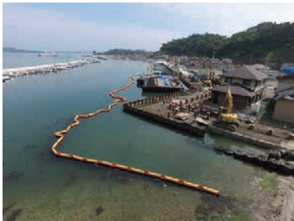
代ヶ崎清水防潮堤等復旧工事中
