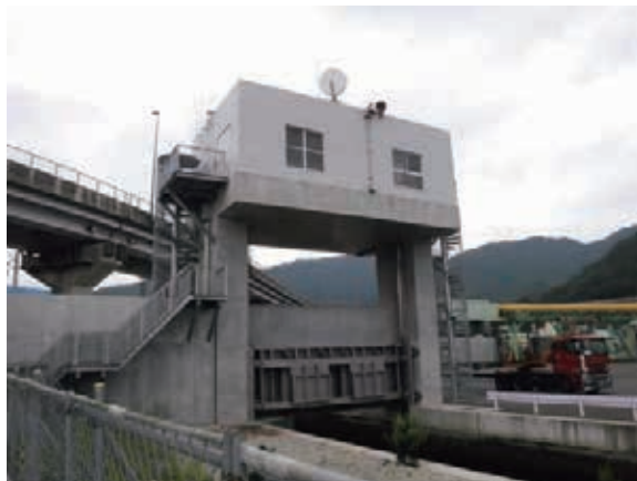
釜石港防潮堤水門（令和元年 7 月）
