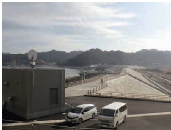
片岸海岸防潮堤復旧工事竣工（令和 2 年 1 月）
