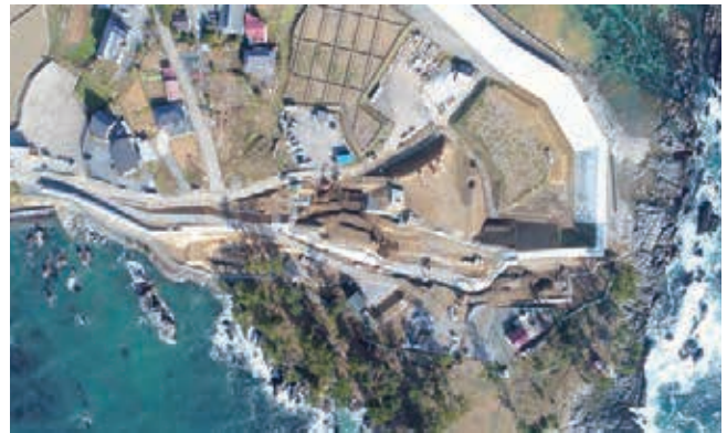
岩井崎地区（平成 29 年 11 月撮影）
