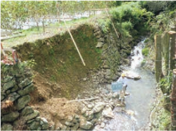
椽元川（復旧工事前）
