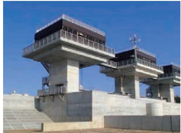
滑津川水門 完成（平成30年3月）
