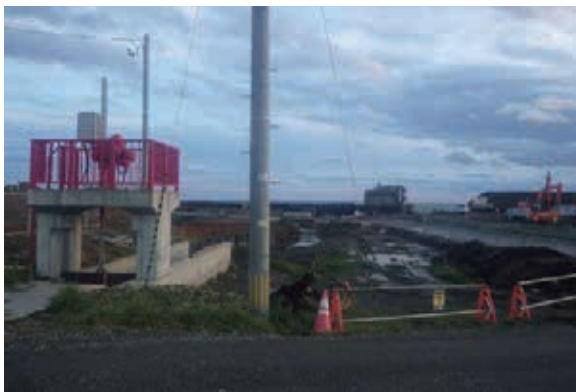
杉ノ下地区海岸 着手前（平成 30 年 12 月）
