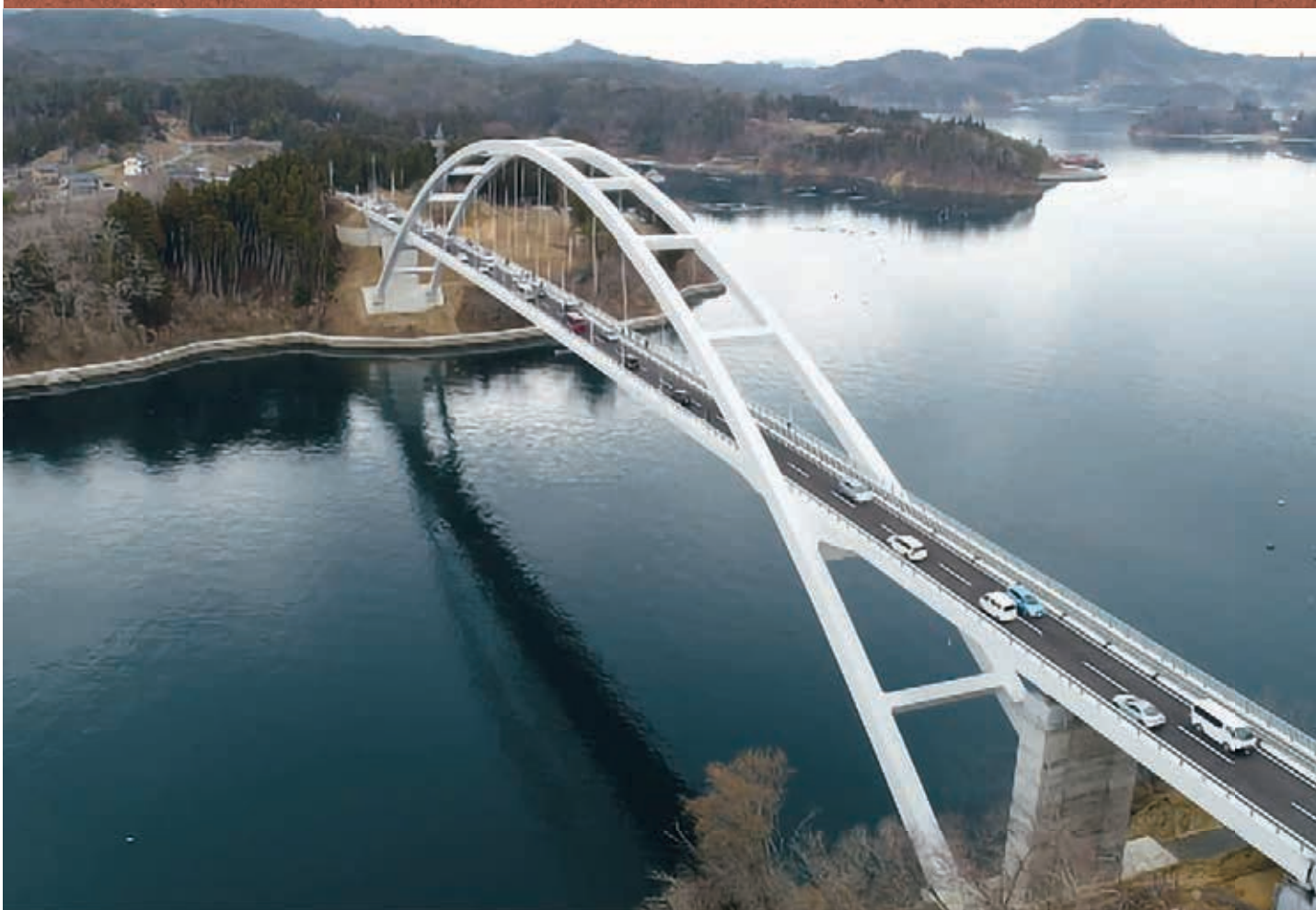
気仙沼大島大橋 宮城県気仙沼市（平成30年4月供用開始）
