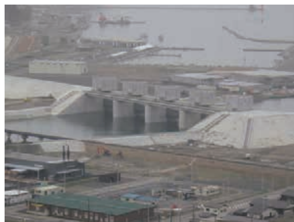
大槌川水門 完成（令和 3 年 3 月）
