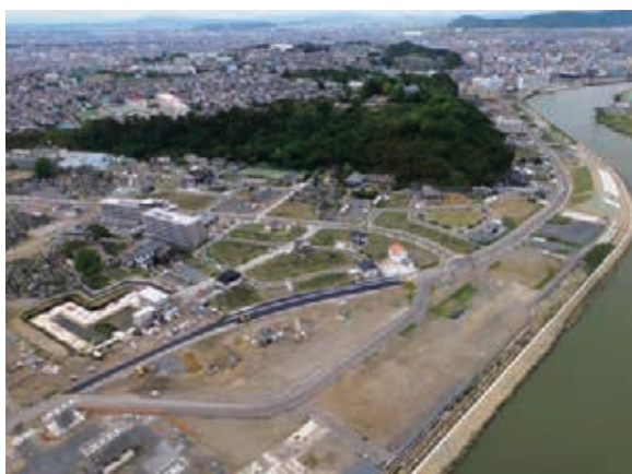
中央排水ポンプ場予定地（平成30年9月）
