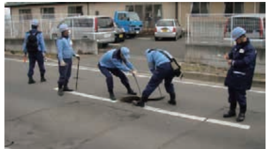
現場調査状況（仙台市）
