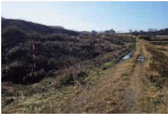
法面及び排水路修復工事 着工前
