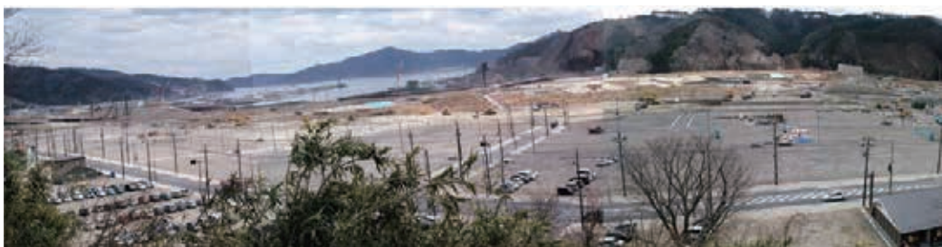
水道復旧事業実施中（平成29年9月）
