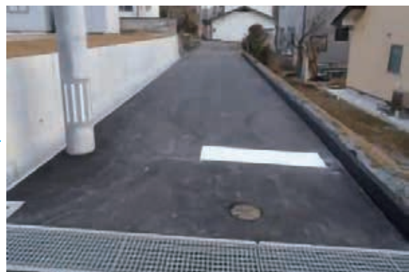
道路の復旧・完成 鏡石 5 工区
