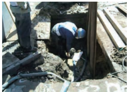
漏水箇所の掘削（浦安市）
