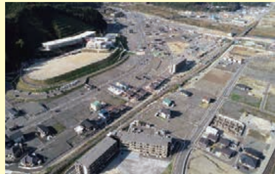
釜石市 被災市街地復興土地区画整理事業 (鶴住居地区)
