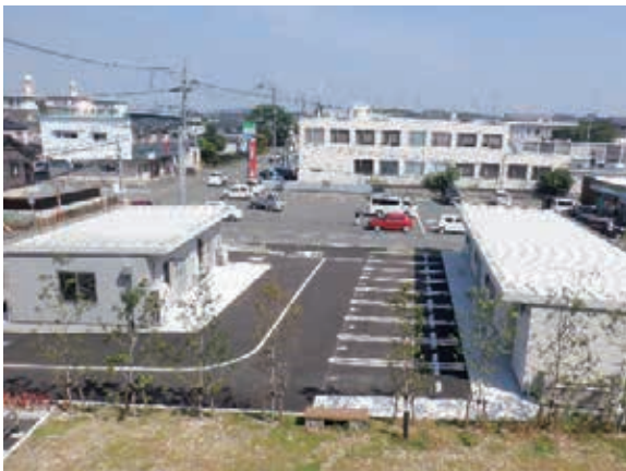
区画整理地内に仮設店舗設置
