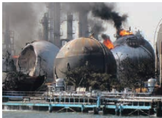
LPG貯蔵タンク延焼状況
