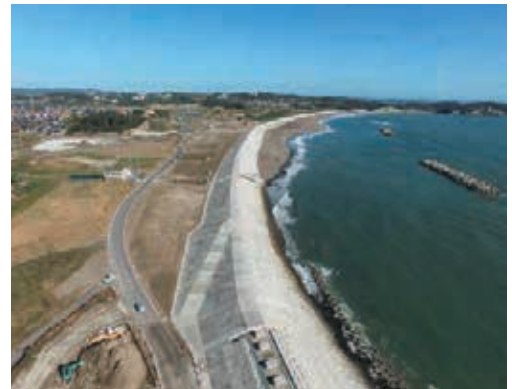
完成した菖蒲田浜海岸防潮堤（平成 30 年 3 月）
