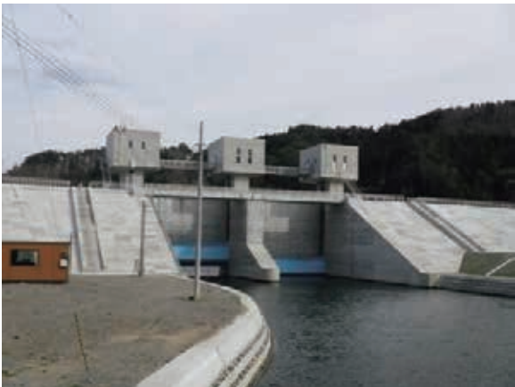
小白浜海岸水門の復旧・復興状況（令和元年11月）
