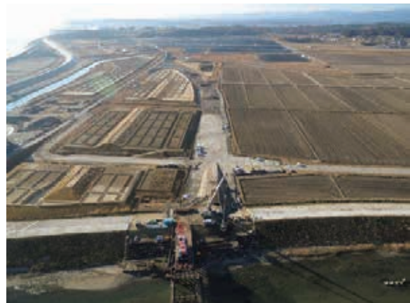
県道広野小高線（令和元年12月撮影）
