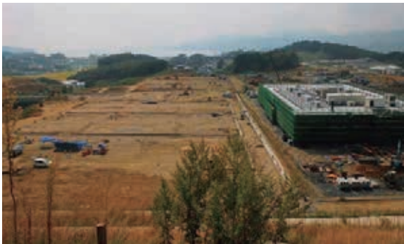
水道復旧事業実施中（平成29年9月）
