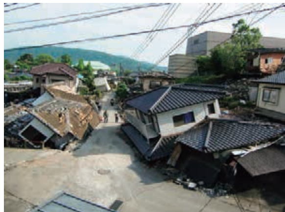
益城町内の倒壊家屋
