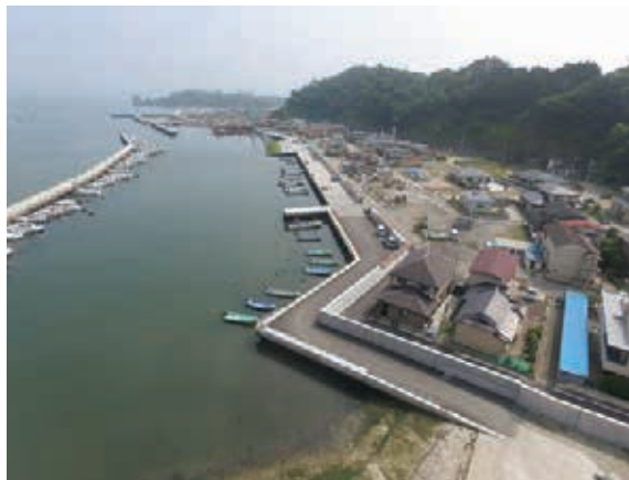
代ヶ崎清水防潮堤等復旧間近
