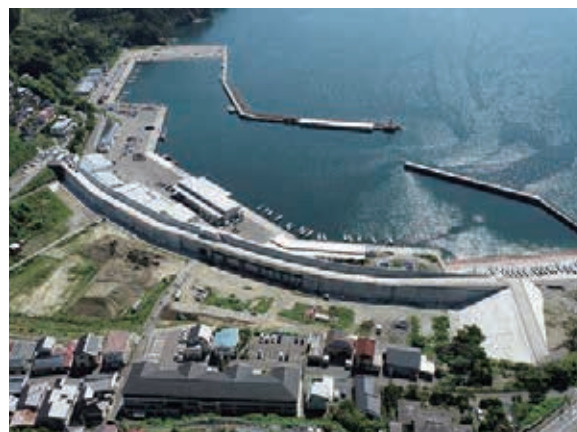
完成した白浜漁港防潮堤
