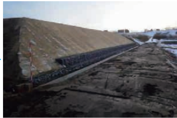
法面及び排水路修復工事 完了後
