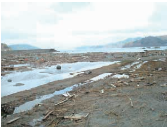
片岸海岸被災後（平成 23 年 4 月）
