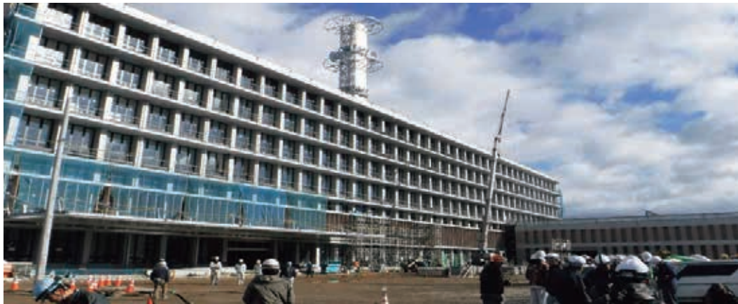
福島県警察本部庁舎工事風景
