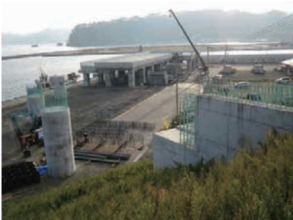
工事中の津波避難誘導デッキ
