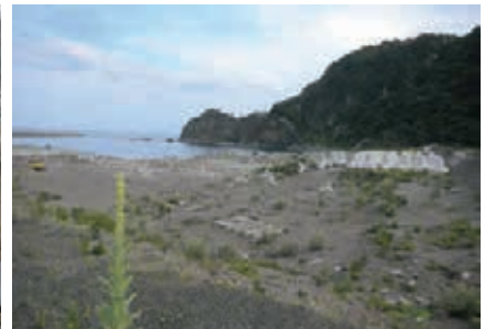
工事着手3か月後の小本港
