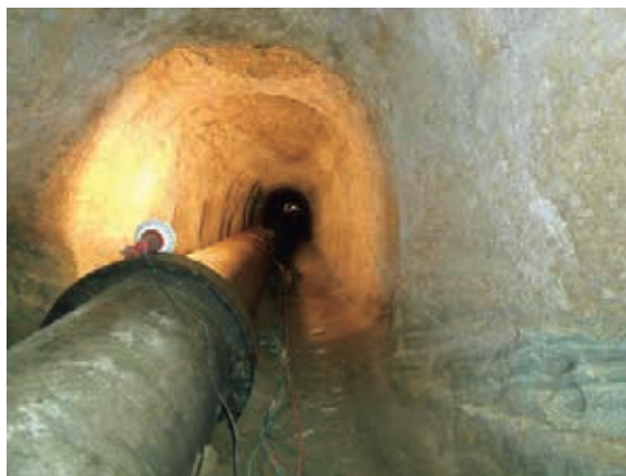
昭和 37 年完成の隧道とφ 700 鋼管
