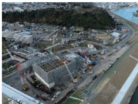
中央排水ポンプ場建設中（令和3年11月）
