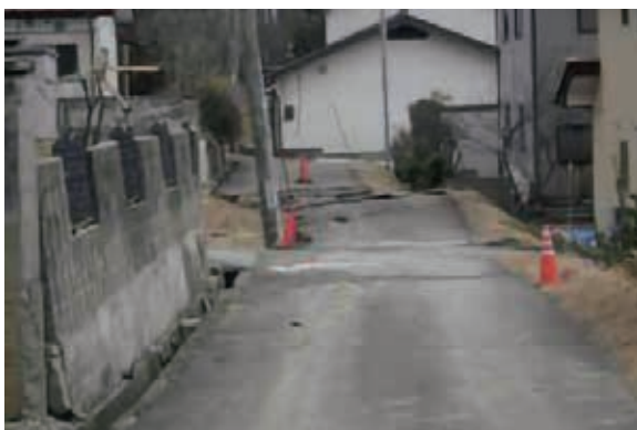
道路の復旧・施工前 鏡石 5 工区
