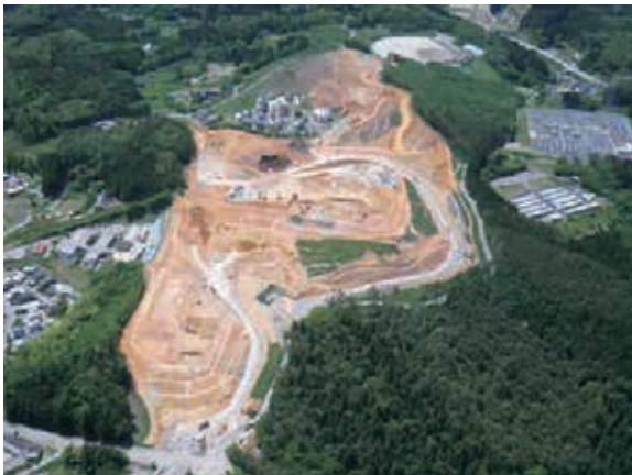
災害公営住宅牧沢地区の造成工事
