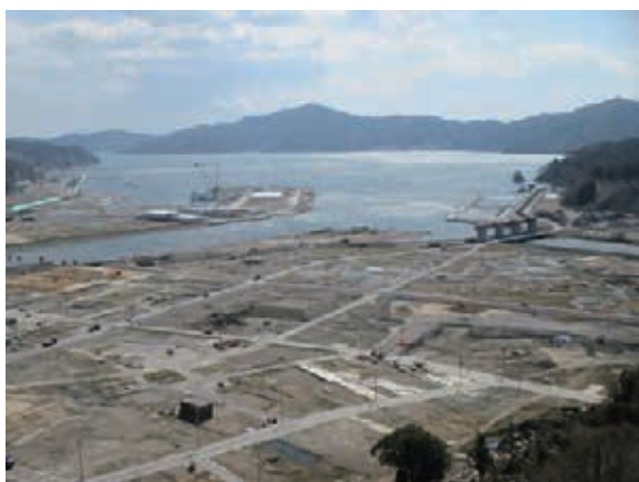
大槌川・小槌川被災後状況（平成 26 年 4 月）
