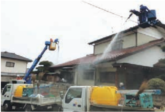
家屋の高所作業車による高圧洗浄
