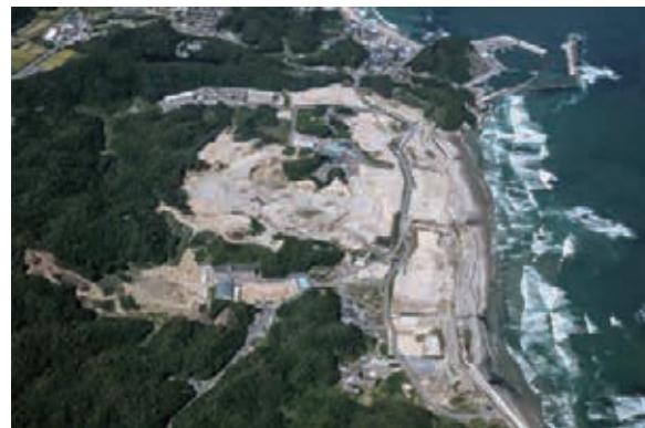
薄磯地区工事等状況（平成 27 年 9 月）
