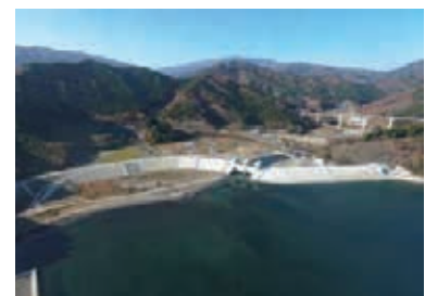
小白浜海岸（防潮堤・水門高上げ）
