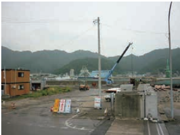
釜石港防潮堤被災状況（平成 24 年 7 月）
