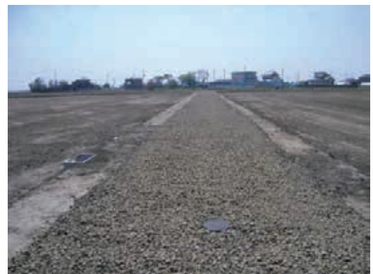
農地整備工事施工後
