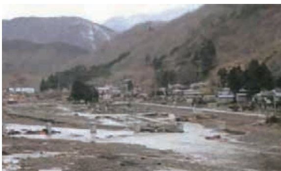
下安家橋復旧工事
