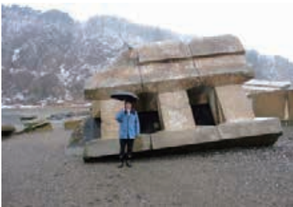
津波で港に打ち上げられたブロック
