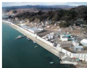
宮古港海岸（防潮堤新設）
