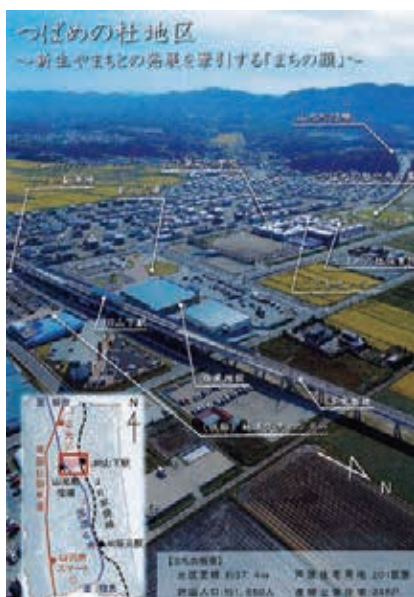
新市街地 つばめの杜地区
