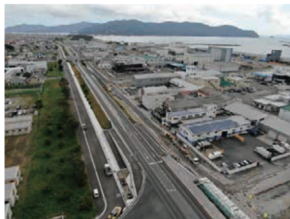
魚町工区、交差点付近（令和3年9月）
