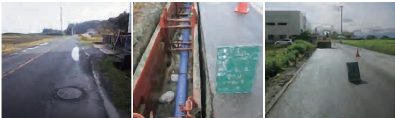
農業集落排水（下水道）復旧（左から着工前、管渠布設替え、工事完了）
