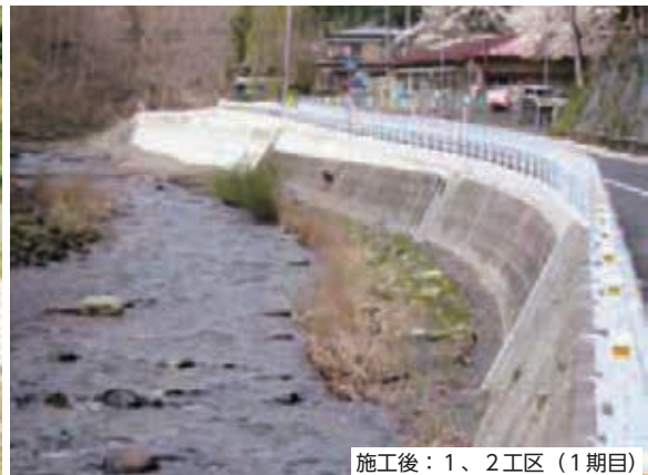
施工前：1、2 工区（1 期目）
