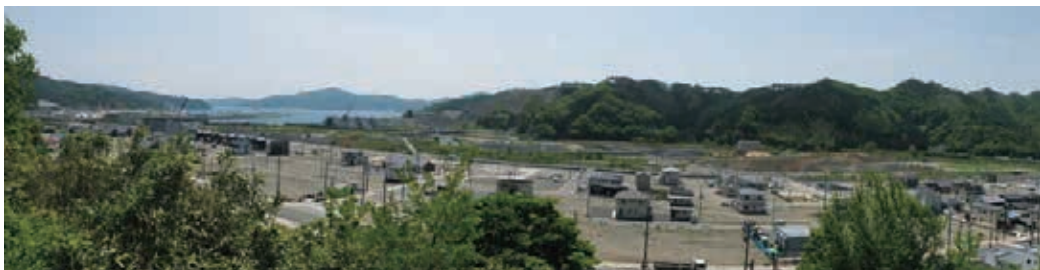
水道復旧事業完了済（平成30年）
