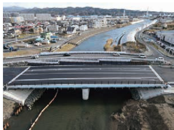
神山川橋竣工（令和 3 年 12 月）
