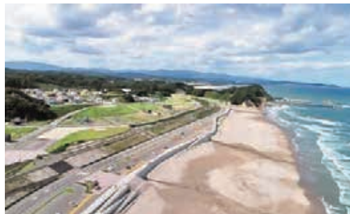
薄磯地区の整備後の様子
