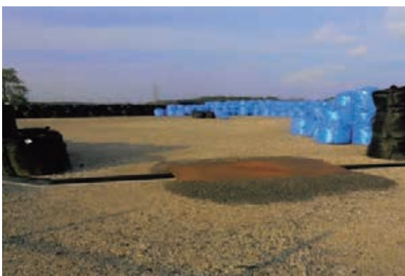
除染廃棄物仮置き場の設置状況
