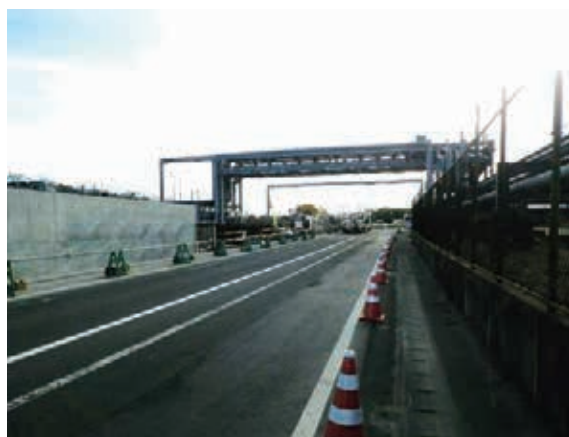
貞山通胸壁整備現場（令和2年12月）
