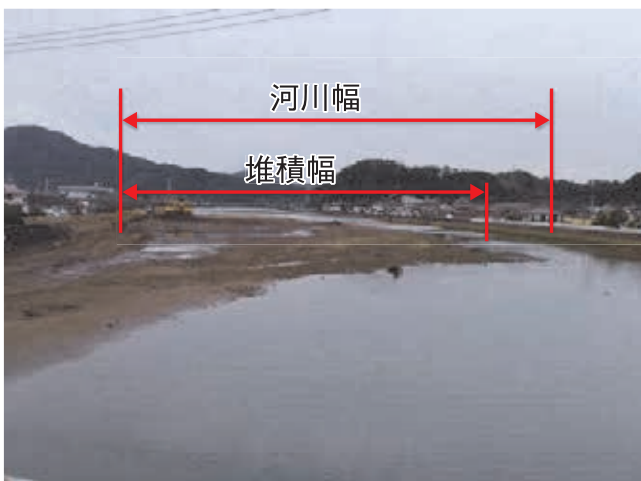
河川内の土砂堆積状況 (佐敷川)
