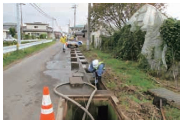
側溝除染（高圧水洗浄）
