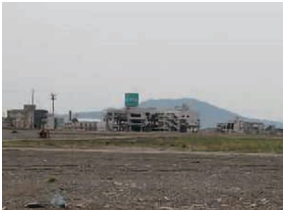
津波被害建物の様子（平成 24 年 5 月撮影）
