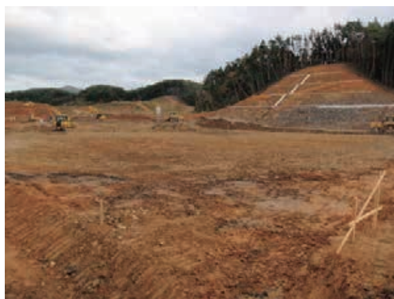
建設地造成中 平成 26 年 10 月
