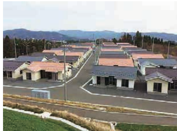
牧沢災害公営住宅（完成時）
