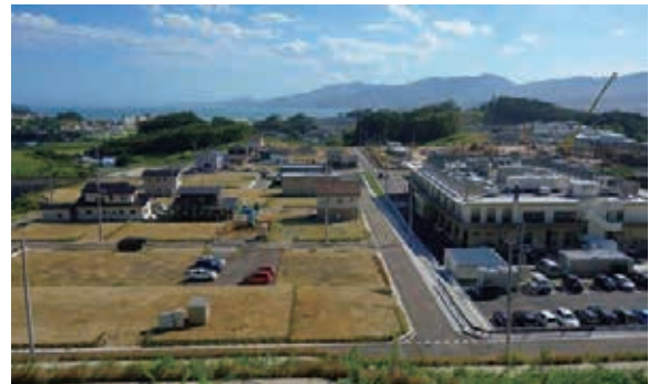
水道復旧事業完了済み（平成30年9月）
