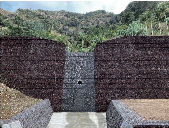
八ツ瀬川砂防施設
