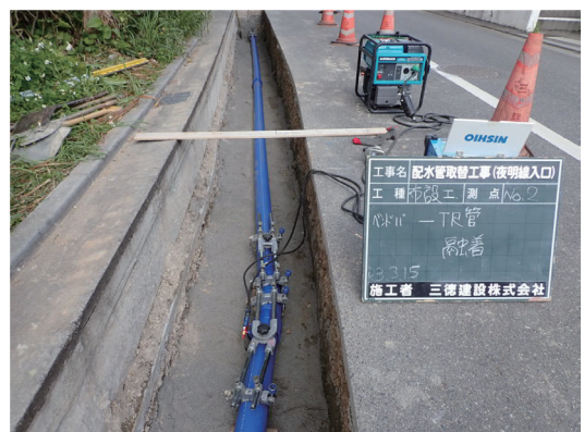
耐震仕様管布設状況
