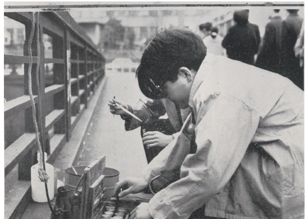
お茶の水橋での水質汚濁検査 『河は汚されている』東京都首都整備局、昭和35年9月 (請求番号：都市C71)
