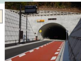
〔梅ヶ谷トンネル〕
