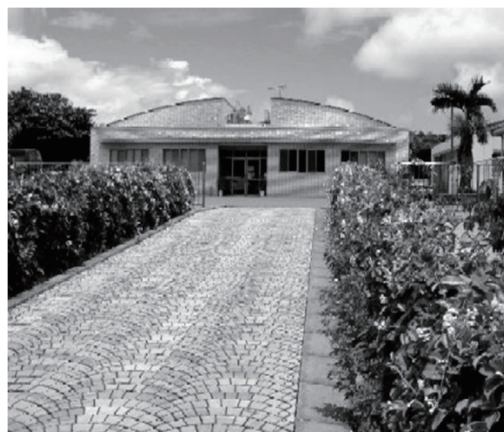
亜熱帯農業センター本館
