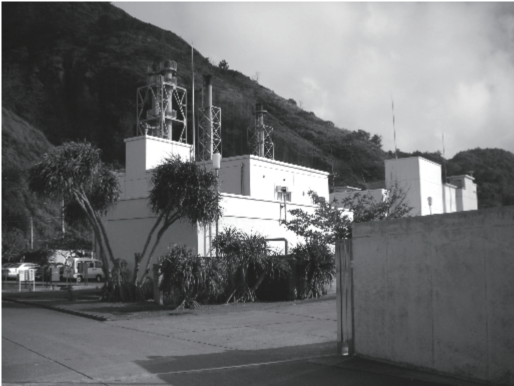
父島内燃力発電所（父島 奥村）
