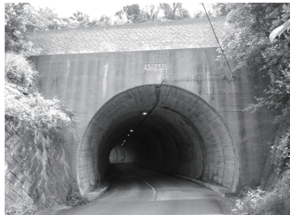
長崎トンネル
