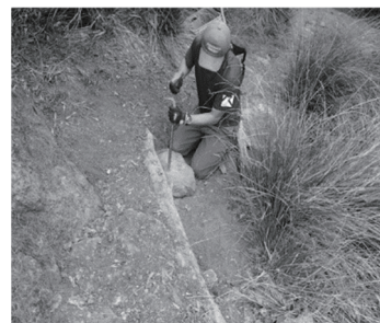
都レンジャーによる歩道補修
