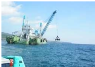
【自然石の投入】
