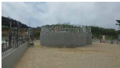
最終沈殿池 外観
