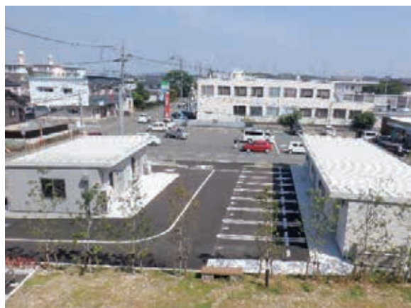
区画整理地内に仮設店舗設置
