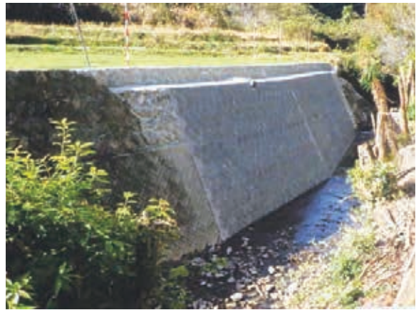
椽元川（復旧工事後）
