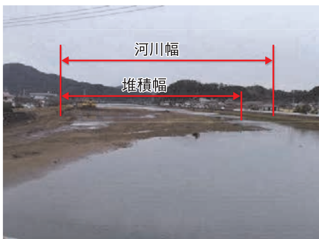
河川内の土砂堆積状況（佐敷川）
