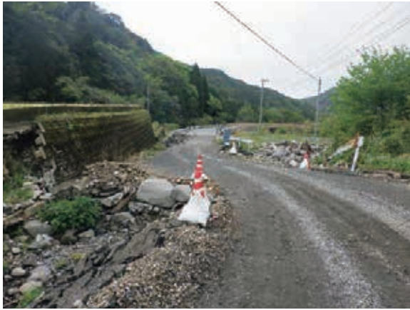
一般県道 331 号古石天線国見地内（着手前）
