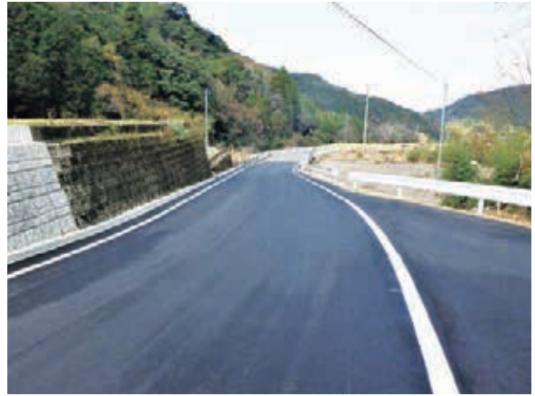
一般県道 331 号古石天線国見地内（完了後）
