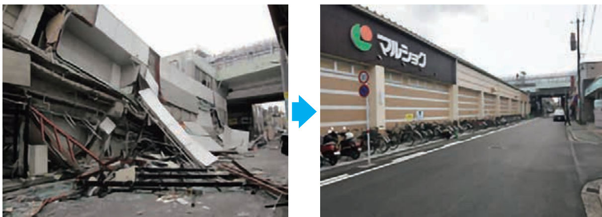
県内被災商業施設の復旧前後の様子
