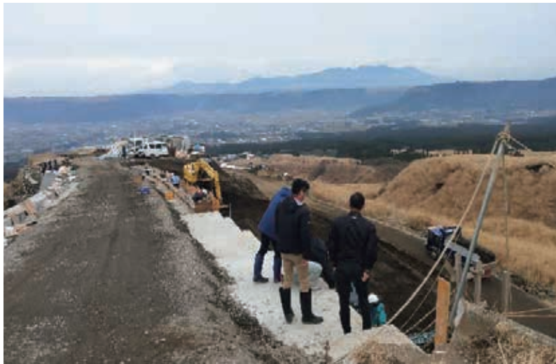
市町村成功認定 阿蘇市仙酔峡工事現場
