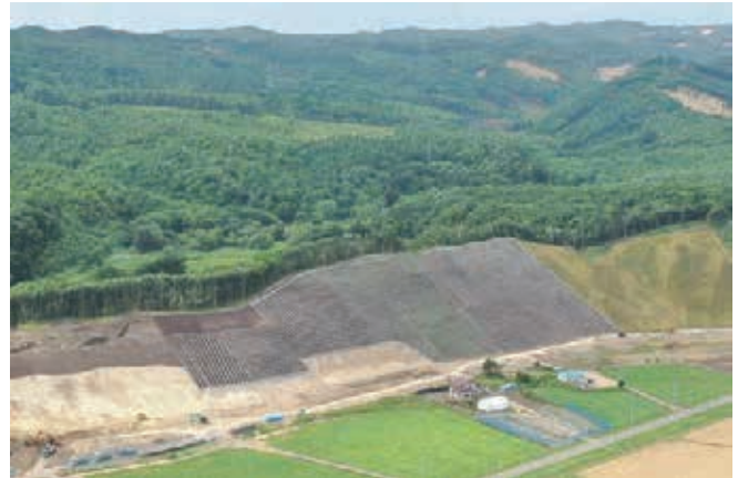
厚真町吉野地区の急傾斜地（令和2年8月）
