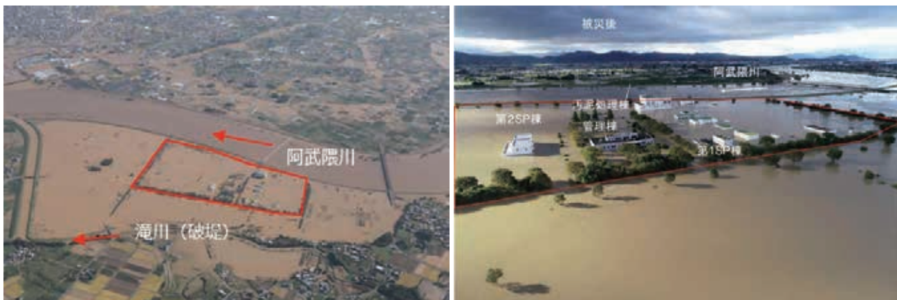
浸水被害状況（赤枠が県北浄化センター）
