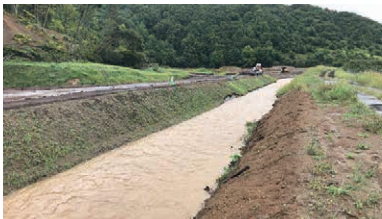
ハビウ川護岸工事（令和2年9月）
