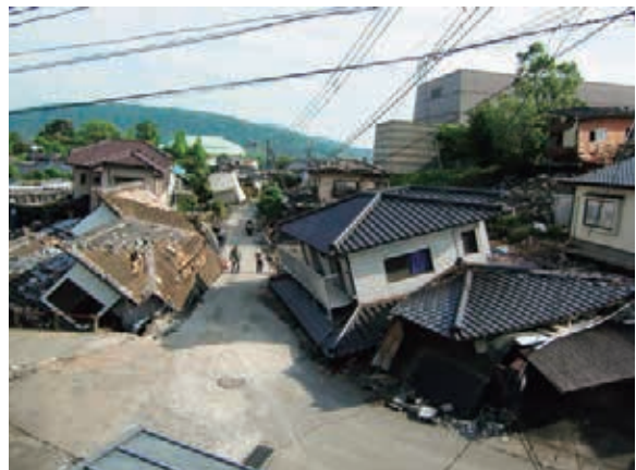
益城町内の倒壊家屋
