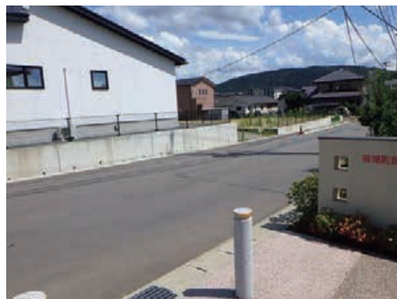
区画整理による宅地造成
