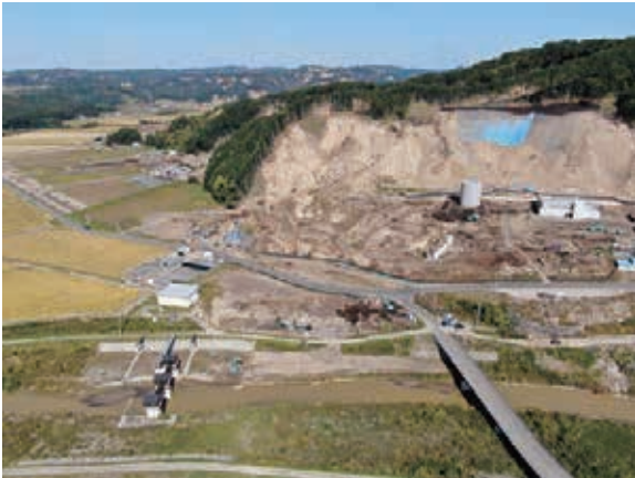
損壊した浄水場と被災護岸（令和元年9月）
