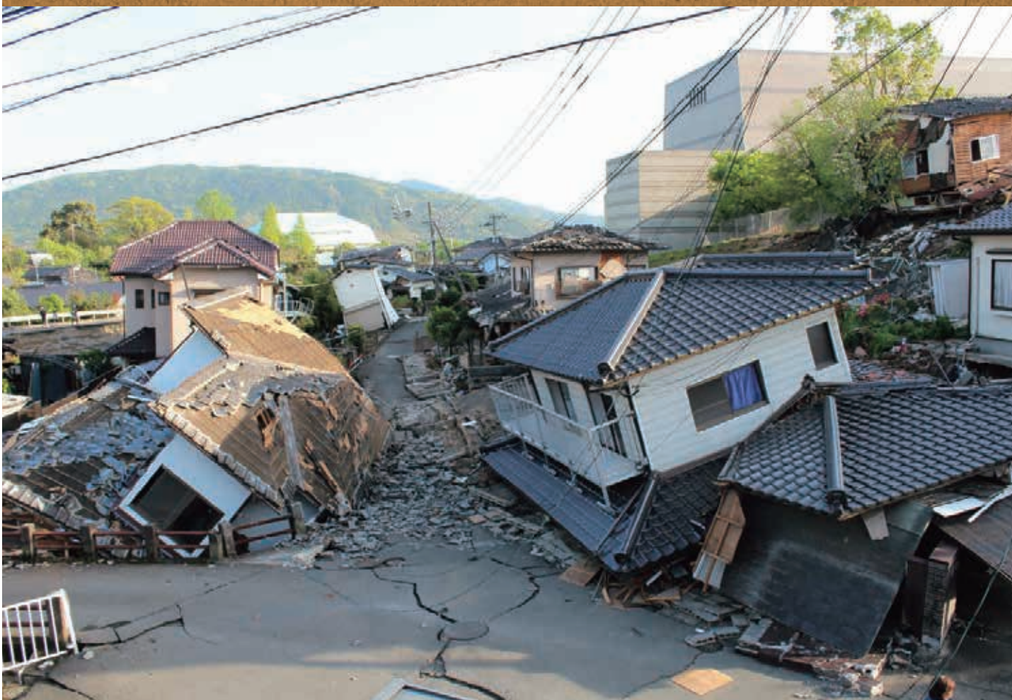
道路沿いの家屋倒壊 熊本県（熊本地震（平成28年）発災後）
