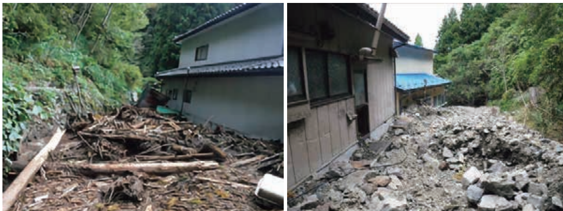
大量の土砂・流木が住居を直撃（釜石市）
