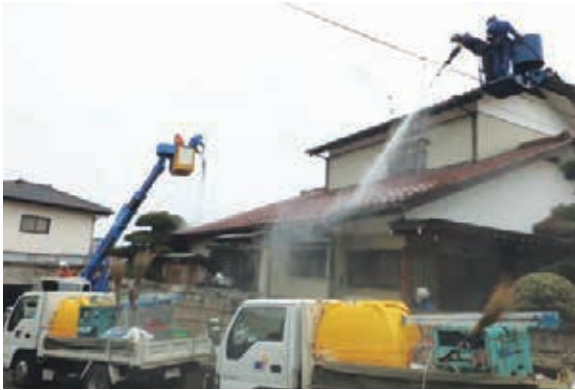
家屋の高所作業車による高圧洗浄
