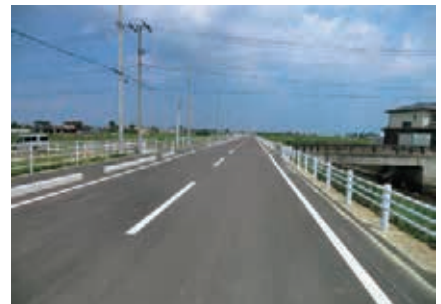
町道浅生原笠野線工事完成（平成28年度）
