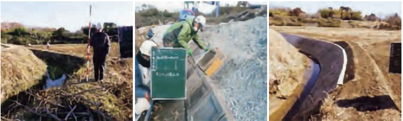
水路復旧 左から着工前、法面積ブロック復旧、工事完了
