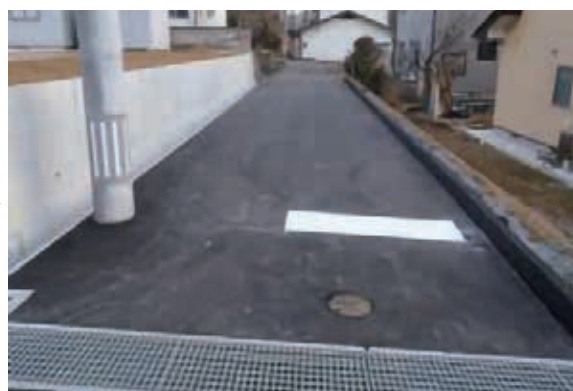
道路の復旧・完成 鏡石5工区
