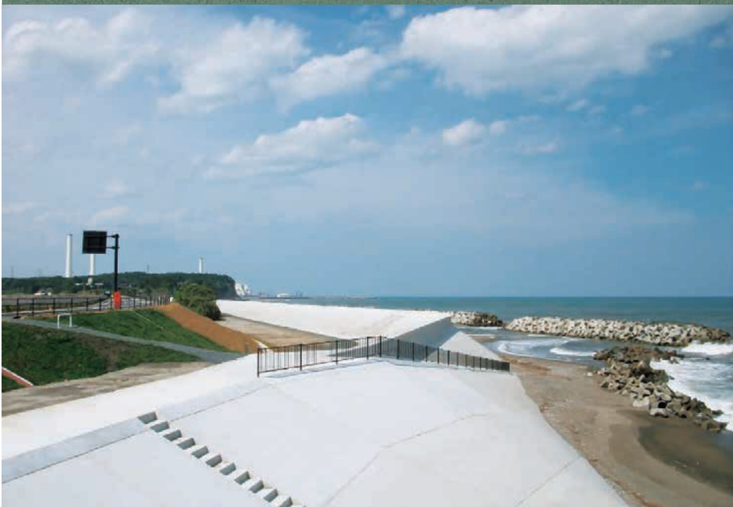
福島県広野町 海岸堤防と防災緑地（平成 29 年度撮影）
