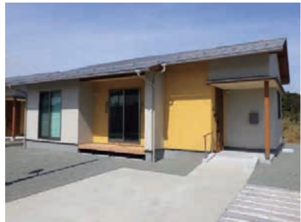
檜葉町災害公営住宅（シウ神山住宅）
