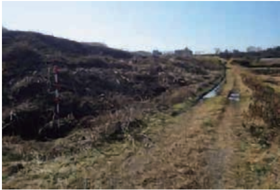
法面及び排水路修復工事 着工前
