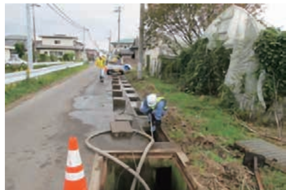
側溝除染（高圧水洗浄）
