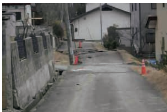
道路の復旧・施工前 鏡石5工区
