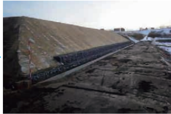
法面及び排水路修復工事 完了後
