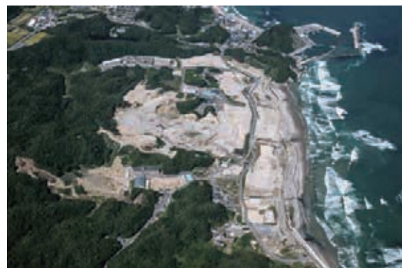
薄磯地区工事等状況（平成 27 年 9 月）
