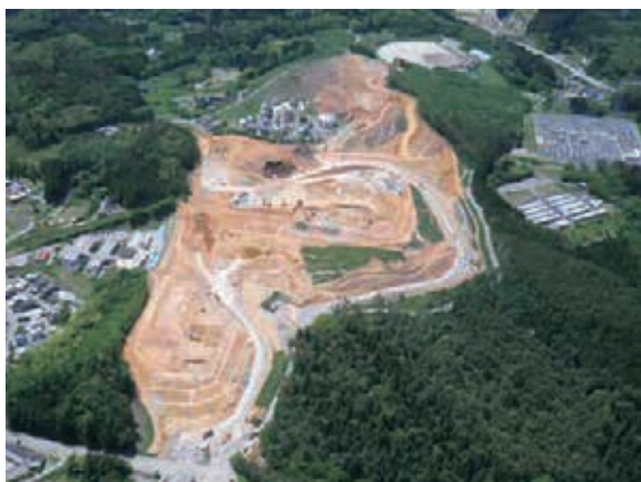
災害公営住宅牧沢地区の造成工事
