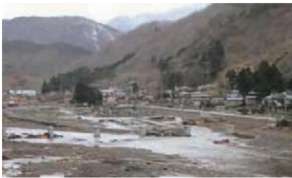
下安家橋復旧工事
