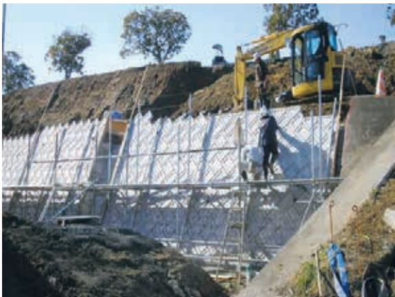
総合グラウンド法面復旧工事（平成26年当時）
