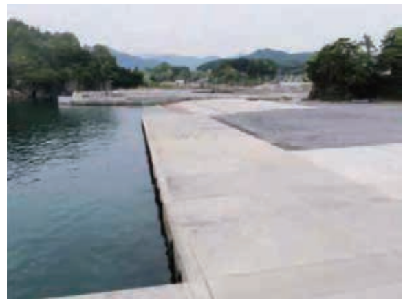
泊里漁港復旧状況（平成 29 年 6 月）
