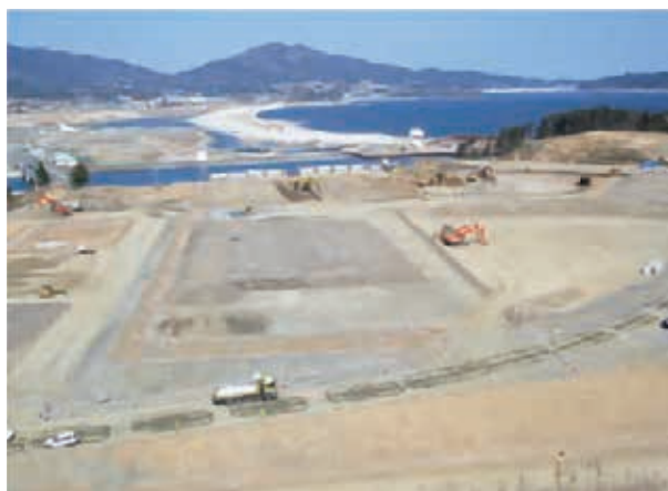
造成工事が進む陸前高田市今泉地区（平成28年度）
