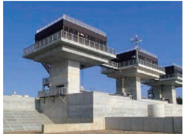
滑津川水門 完成（平成30年3月）
