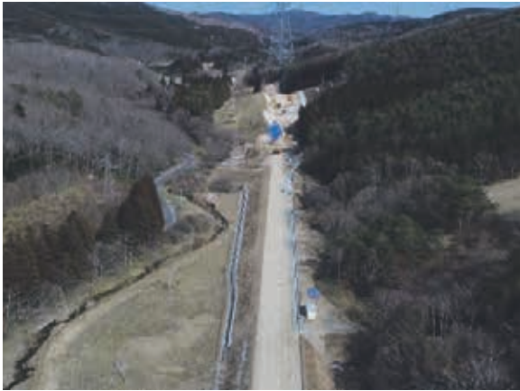
県道小野富岡線（小白井工区） 旧道（写真左）のバイパス道路（写真右）を新設
