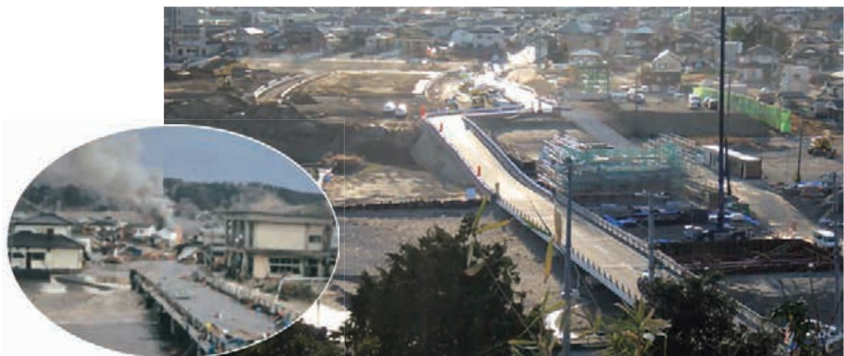
いわき市久之浜地区（蔭磯橋）
