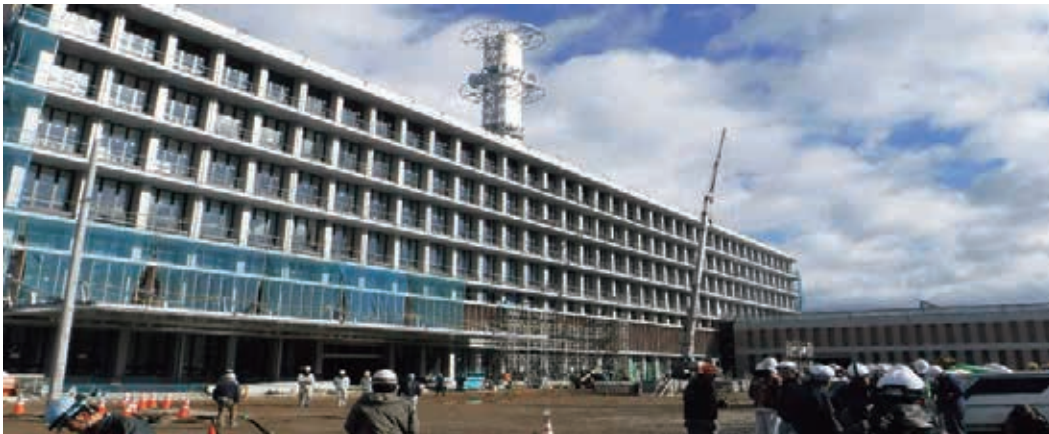
福島県警察本部庁舎工事風景
