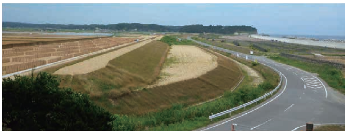
海岸防災林造成後（南相馬市鹿島区 令和元年 9 月撮影）
