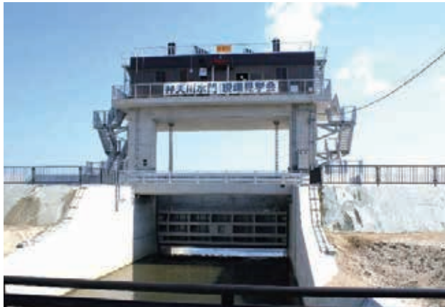
福島県内初の津波高潮対策水門 弁天川水門完成（平成29年3月）
