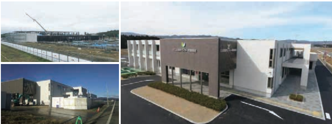
ふたば医療センター附属病院(左は建設中の様子(平成 29 年 8 月から 12 月頃))
