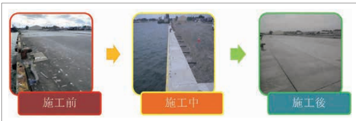
復旧前後の様子（相馬港 1 号埠頭岸壁）
