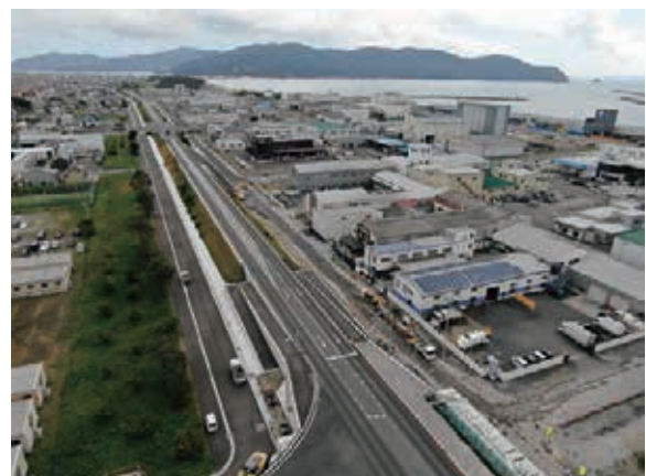
魚町工区、交差点付近(令和3年9月)
