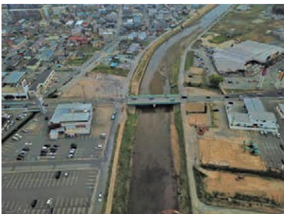
神山川橋工事着手前（平成 30 年 5 月）
