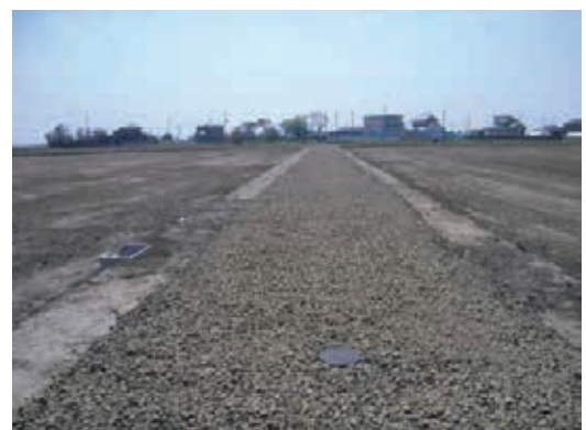
農地整備工事施工後
