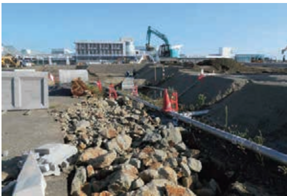
魚市場前道路改良工事（水道管φ150 仮配管）
