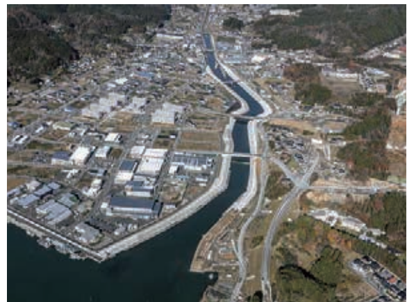
鹿折地区の復旧・復興状況（令和元年11月）
