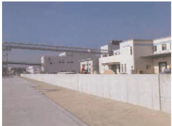
塩釜漁港中ふ頭東棧橋背後防潮堤完成
