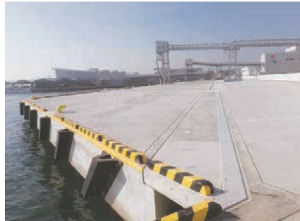
塩釜漁港 中ふ頭東棧橋完成
