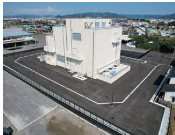
完成した北北上運河右岸第二排水ポンプ場 (令和3年11月撮影)
