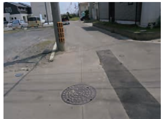
路面状況（液状化による異常は見られない） （平成 25 年 8 月 12 日撮影）
