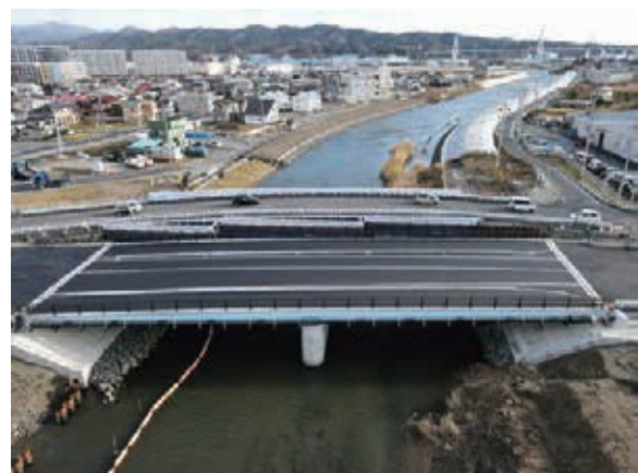
神山川橋竣工（令和 3 年 12 月）
