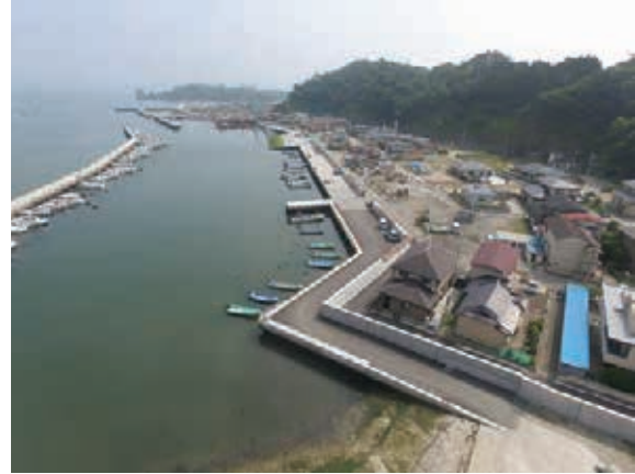
代ヶ崎清水防潮堤等復旧間近
