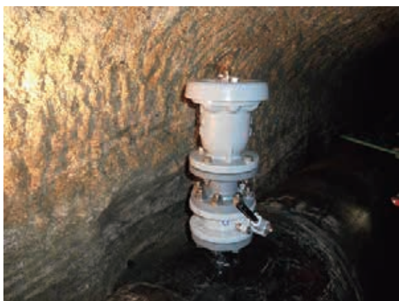
空気弁の取替に伴い補修弁を設置
