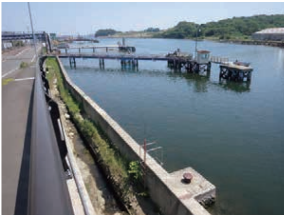
貞山通胸壁整備着手前
