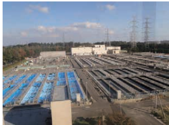
仙塩浄化センター処理施設（平成23年10月31日撮影）
