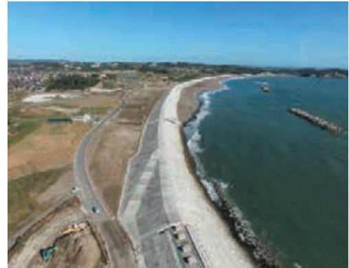
完成した葛蒲田浜海岸防潮堤（平成30年3月）
