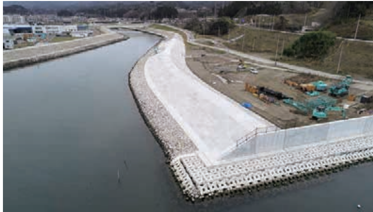
鹿折川左岸河口部（約 200m 区間）防潮堤完成（令和 3 年 12 月）
