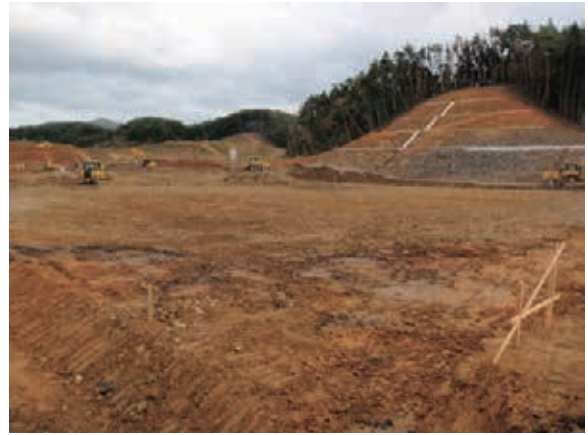
建設地造成中 平成 26 年 10 月
