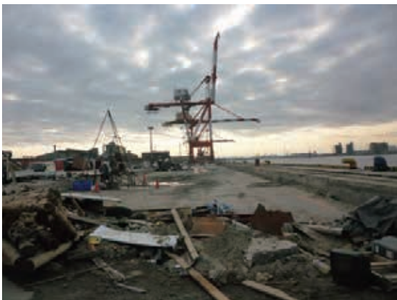
震災後の高砂コンテナターミナル
