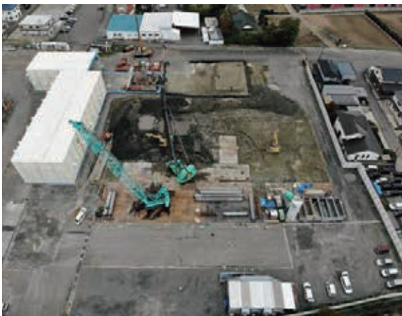
ポンプ場建設地 白い建物シールド工防音ハウス (令和元年5月撮影)
