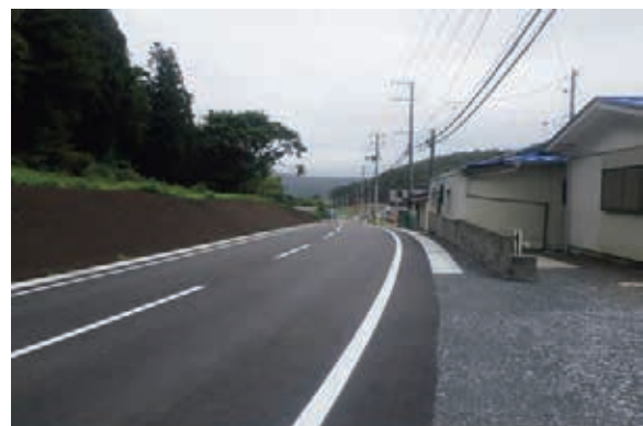
県道石巻雄勝線（着工後）
