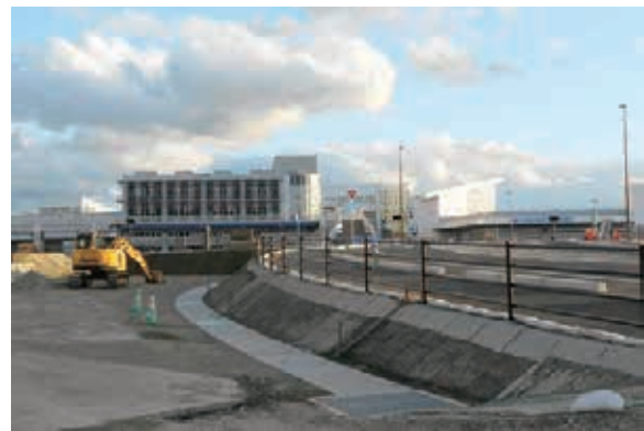
道路舗装箇所（歩道部に水道管布設）奥が魚市場
