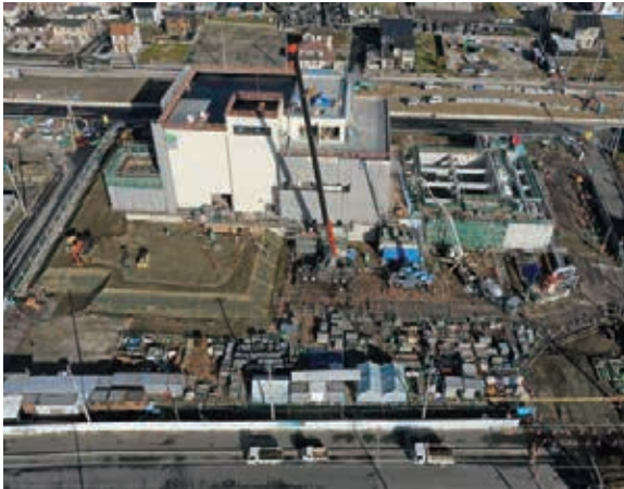
建設中の石巻港排水ポンプ場 (令和3年11月)
