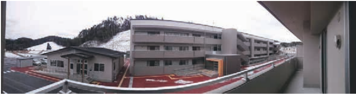
完成した町営戸倉災害公営住宅：平成 28 年 2 月 建物背後に見える杉山は、建設予定地の写真の杉山と同じ
