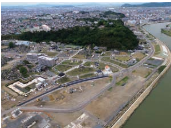
中央排水ポンプ場予定地（平成30年9月）
