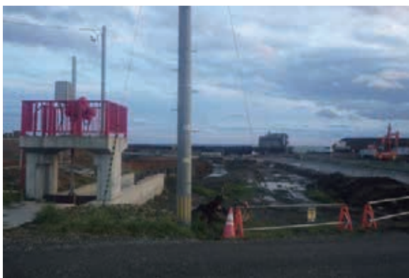
杉ノ下地区海岸 着手前（平成 30 年 12 月）
