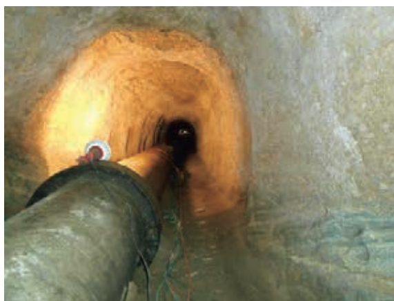
昭和 37 年完成の隧道とφ 700 鋼管
