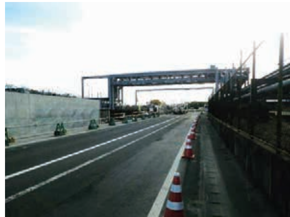
貞山通胸壁整備現場（令和2年12月）
