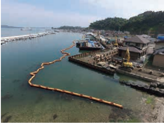
代ヶ崎清水防潮堤等復旧工事中
