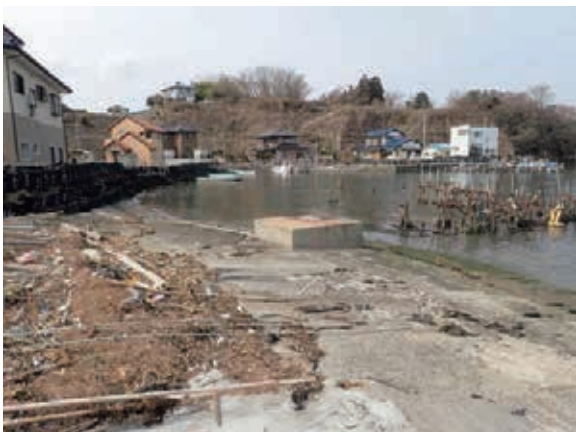
東宮浜被災後の状況
