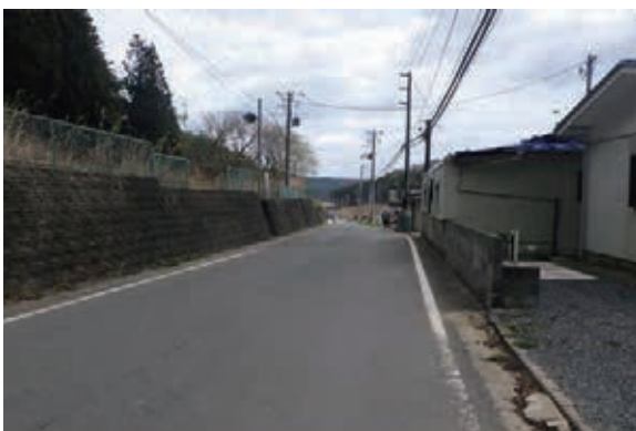
県道石巻雄勝線（着工前）
