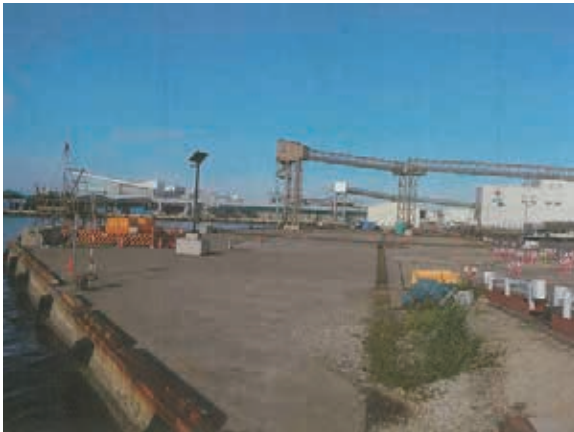
塩釜漁港 中ふ頭東棧橋着手前
