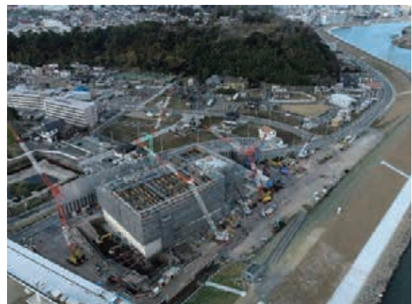
中央排水ポンプ場建設中（令和3年11月）
