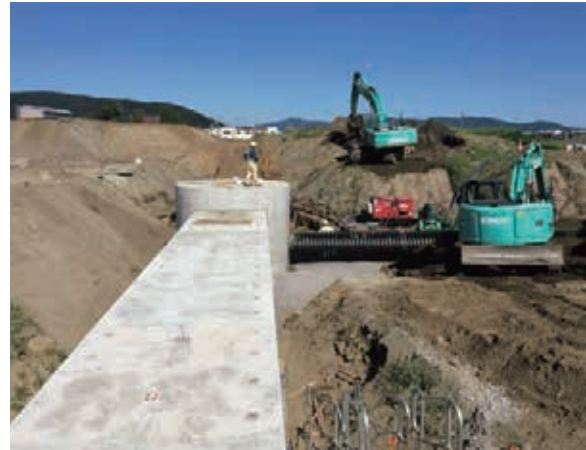
新門脇地区被災市街地復興土地区画整理事業内（高盛土道路整備）での下水道雨水幹線敷設災害復旧事業（令和3年11月）
