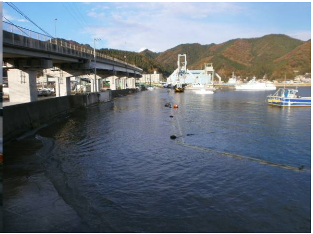
地盤沈下で満潮時に水没する釜石港公共埠頭と物揚場
