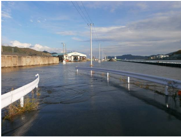
地盤沈下で満潮時に水没する釜石港公共埠頭と物揚場
