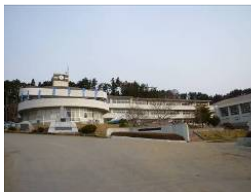
（志津川中学校校舎）
