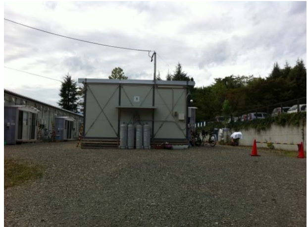
仮設住宅のガスはプロパンです
