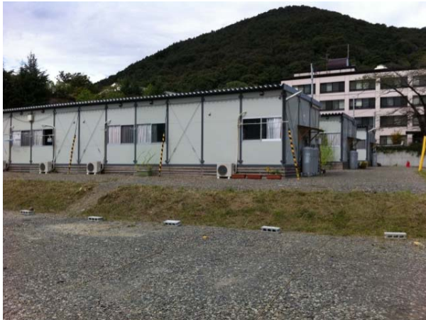
福島市内の森合仮設住宅（3棟計18戸）
