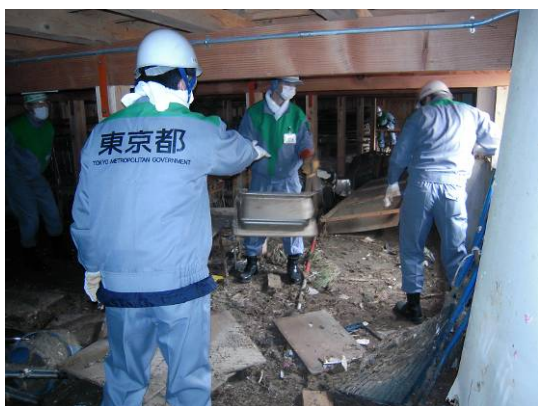
〈 高田小学校体育館の作業中 〉
