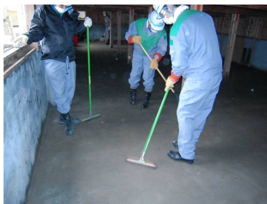
〈 高田小学校体育館の作業後 〉
