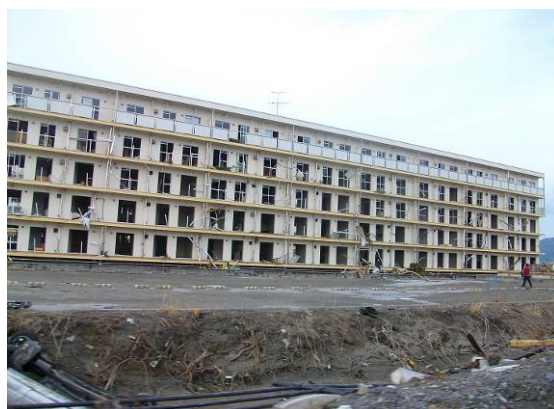
〈 津波被害を受けた住宅 〉
