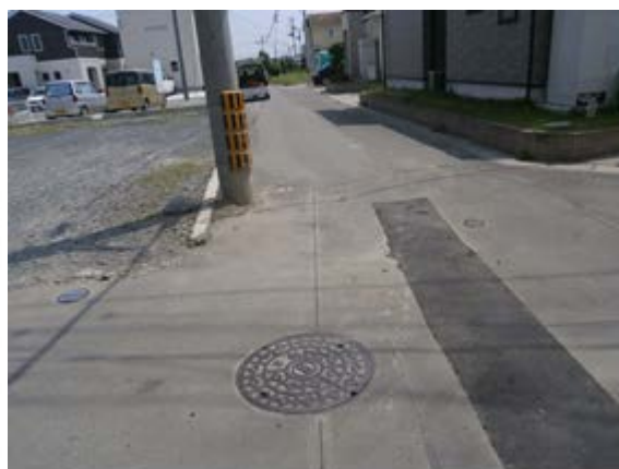
路面状況(液状化による異常は見られない) 平成 25 年 8 月 12 日撮影
