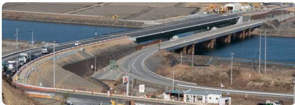
交通が切り替えられた「気仙大橋」(左)と仮設橋(右)
