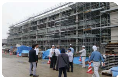
富岡町内視察（災害公営住宅建設現場）
