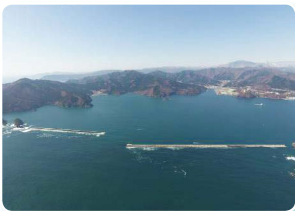
湾口防波堤全景
