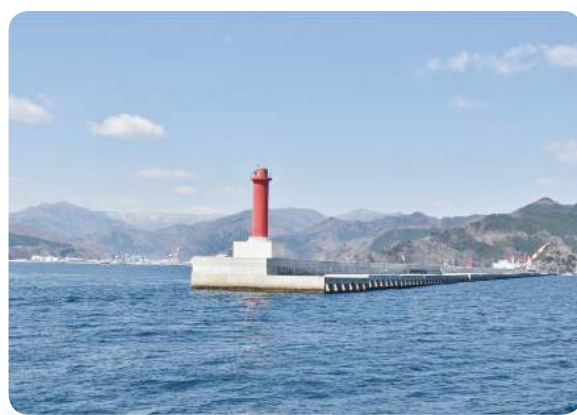
完成した北堤
