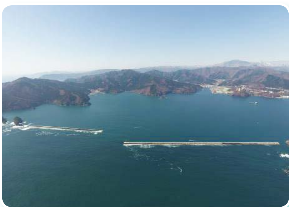
湾口防波堤全景
